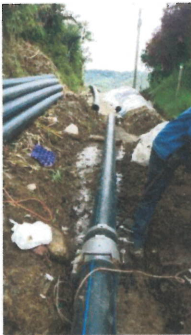
Termofusion de tubería de 8"
