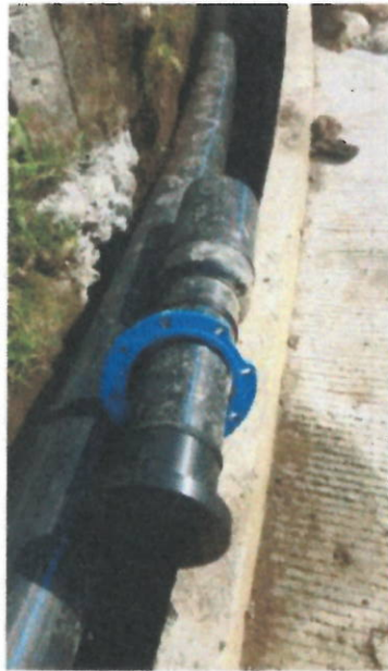
Brida loca en la punta de la tubería de 8"
