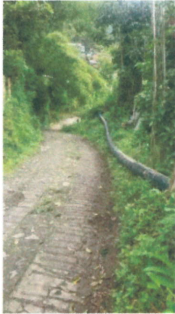
Tramo de tubería de 8" instalado predio adyacente al tanque
