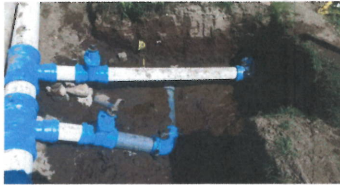
Empalme de tubería de 10" a 6"
