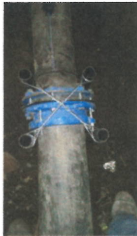
Instalación de tubería galvanizada para anclaje
