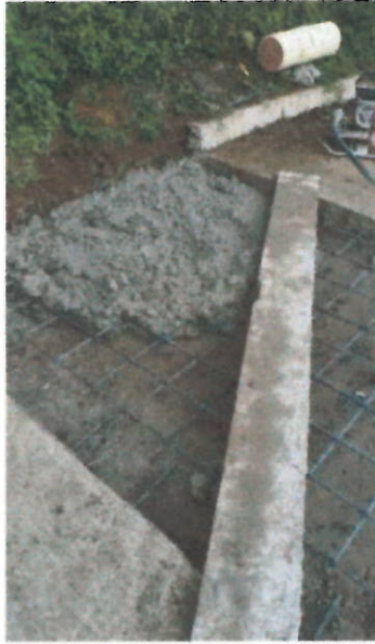
Vaciado de pavimento MR 42
