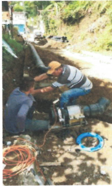
Termofusion de tubería de 8"
