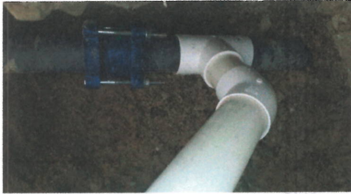
Instalacion de codo y tubería PVC presión de 3"
