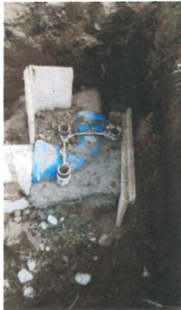
Anclaje para codo de 90° con su respectiva tubería galvanizada
