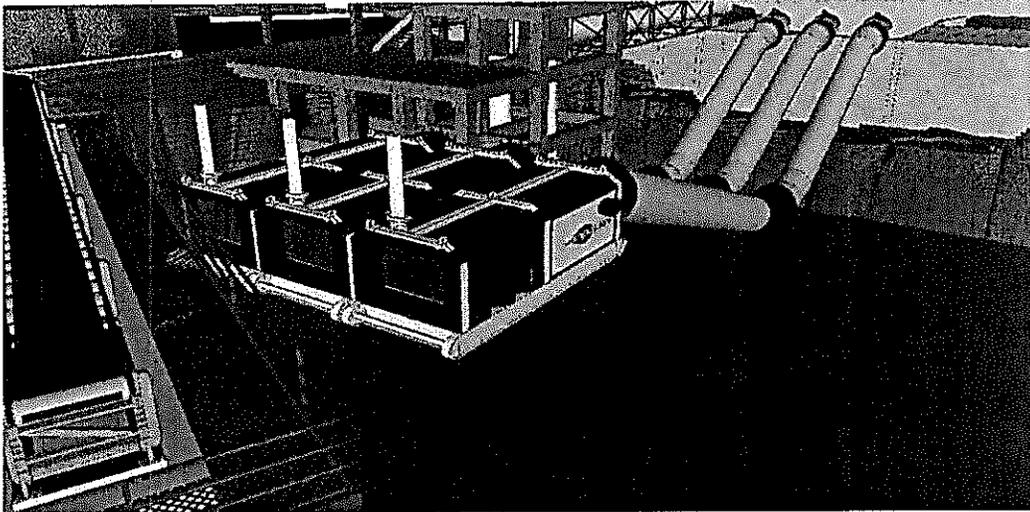
Cambios en la estación de bomba flotante y su distancia frente al canal de aproximación.
