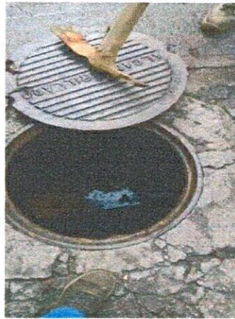
Imagen 2. Inspeccion de camaras existentes en el centro Poblado de Arauca, Municipio de Palestina
