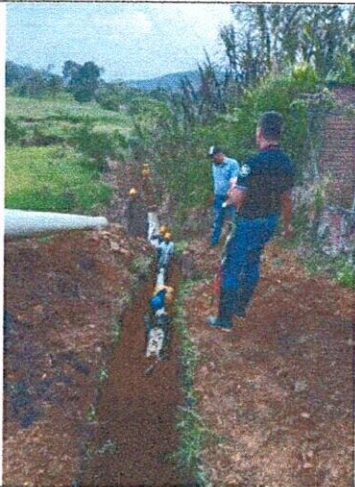
Imagen 5. Instalación de tubería en la brecha
