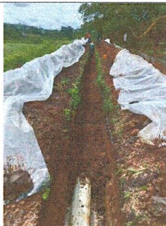
Imagen 2. Lleno de brecha con material proveniente de la excavación
