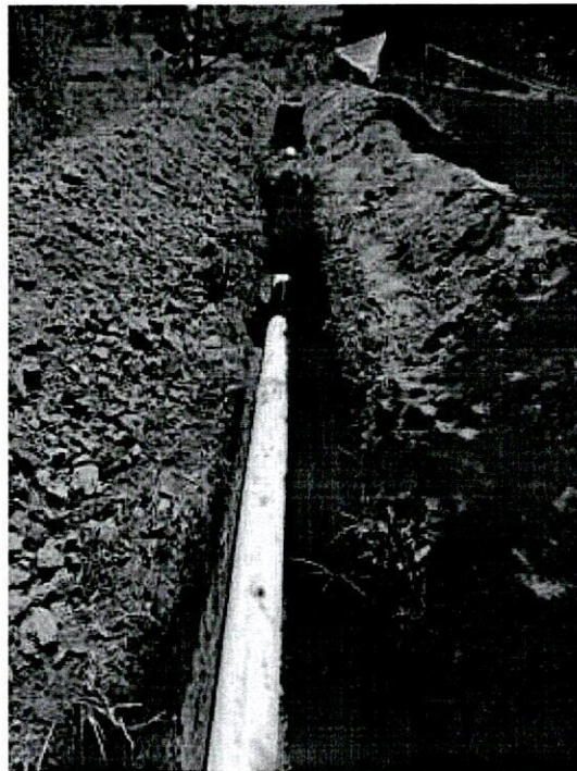
IMAGEN 4. TUBERÍA INSTALADA
