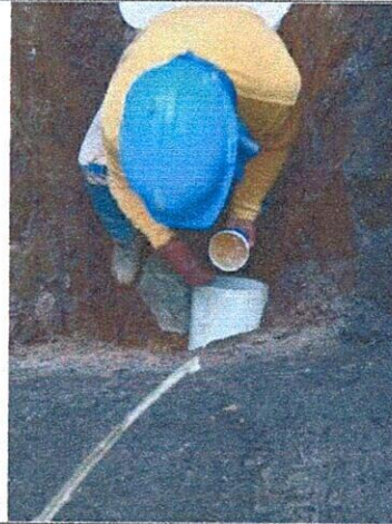
Imagen 4. Instalacion de lubricante para garantizar la unión mecánica de la tubería
