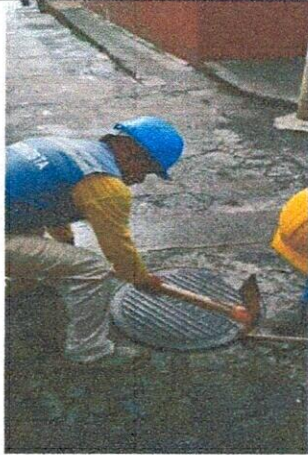
Imagen 1. Inspeccion de camaras existentes en el centro Poblado de Arauca, Municipio de Palestina
