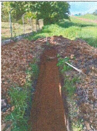
Imagen 1. Realizacion de brecha para instalacion de acueducto
