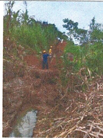
Imagen 6. Instalacion de tubería en la brecha
