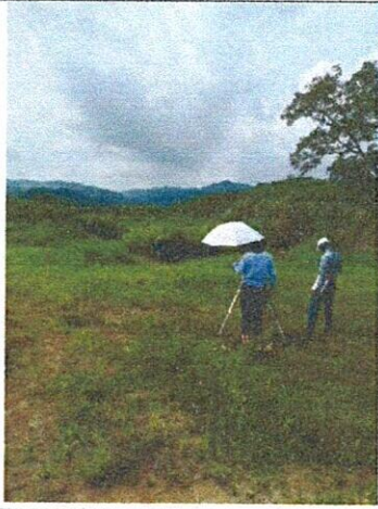
Imagen 3. Realización de localización y replanteo para ubicación de la línea
