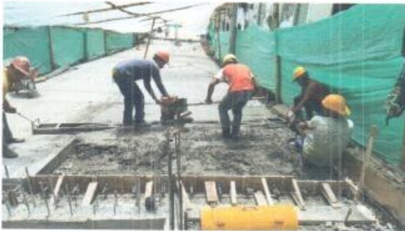
Foto 27. Vaciado de concreto losa No. 42.
