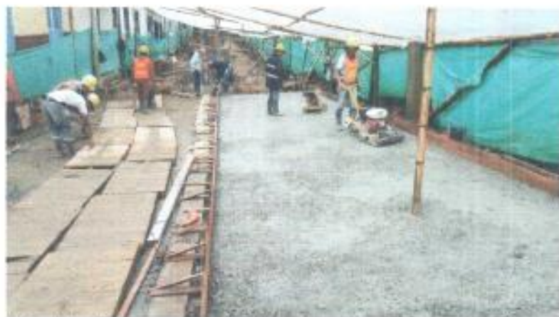
Foto 9. Instalación y compactación de subbase, carrera 3 entre calles 10 y 9A.
