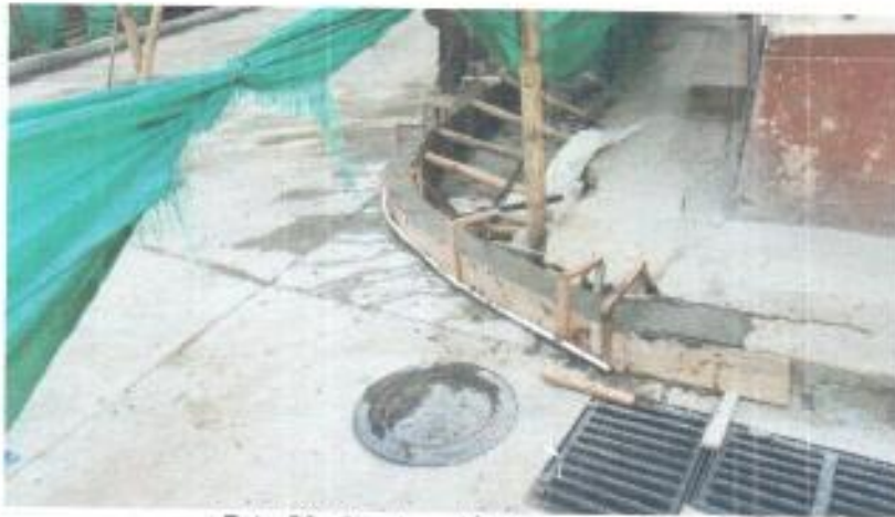
Foto 29. Construcción de sardineles.
