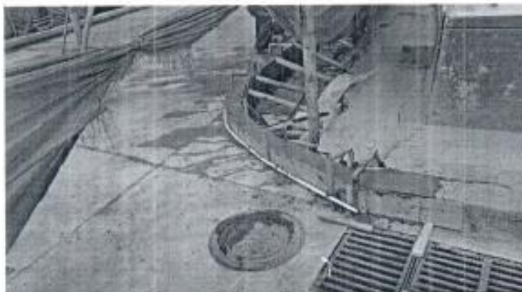
Foto 10. Construcción de sardineles.
