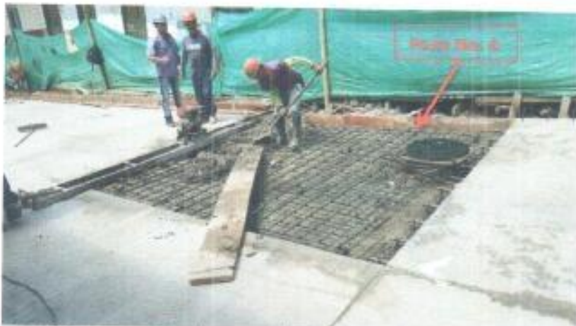
Foto 21. Acero de refuerzo y vaciado de concreto losa No. 37, sobre el pozo de alcantarillado No. 4 (alcantarillado lado Izquierdo Aguas arriba).
