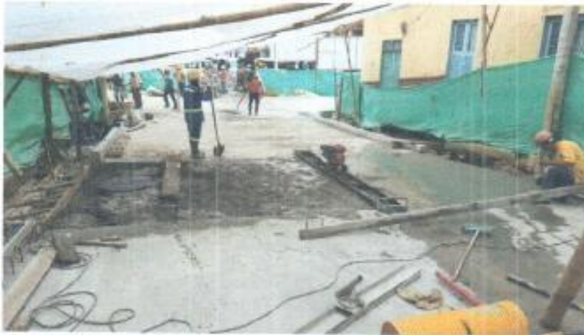
Foto 26. Acero de refuerzo y vaciado de concreto losa No. 22, sobre la cámara No. 4A del Box Couvert y el pozo de alcantarillado No. 2 (alcantarillado lado Derecho Aguas arriba).
