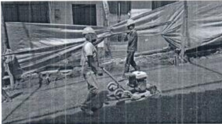
Foto 4. Compactación de subbase.
