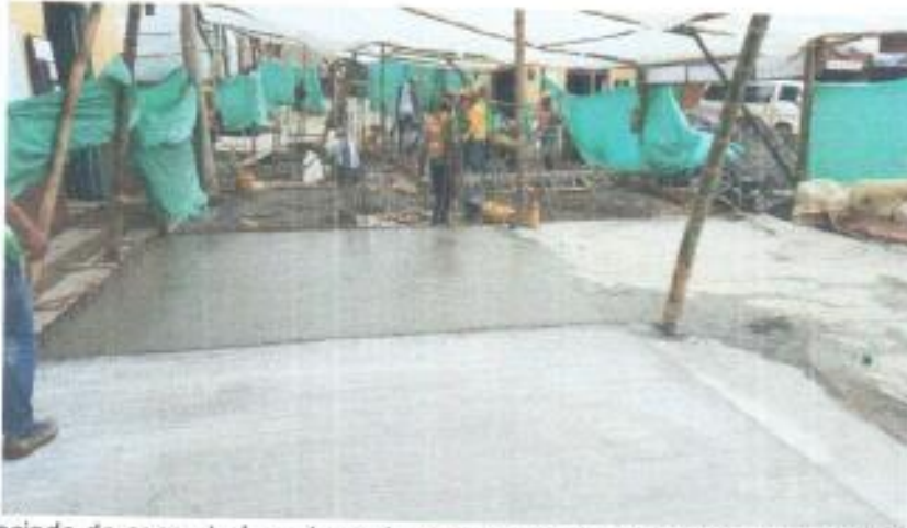
Foto 20. Vaciado de concreto losa de pavimento No. 04. Salida Calle 10 a esquina Carrera 3 y variante.
