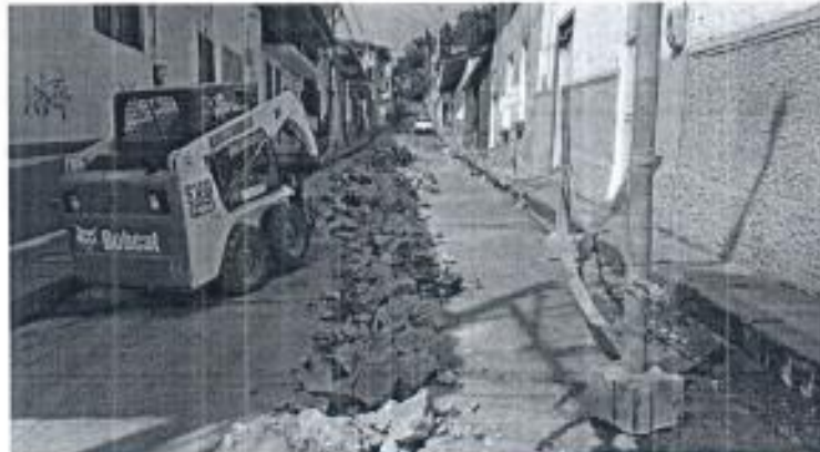
Foto 17. Demolición de franja de pavimento entre las calles 9A y 8.
