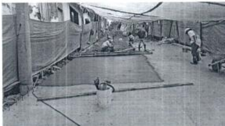
Foto 5. Vaciado de concreto losas No. 40 y 41.
