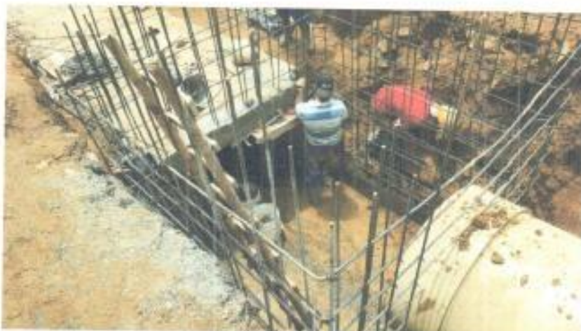
Foto 3. Armado acero de refuerzo último tramo de box culvert y cámara No. 4.
