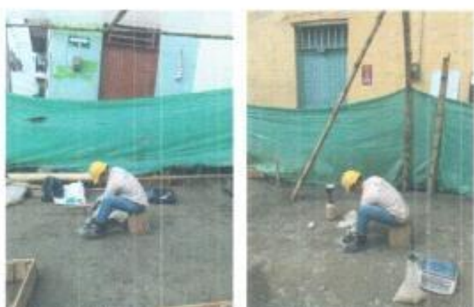
Foto 10. Instalación y compactación de subbase, Toma de densidades.
