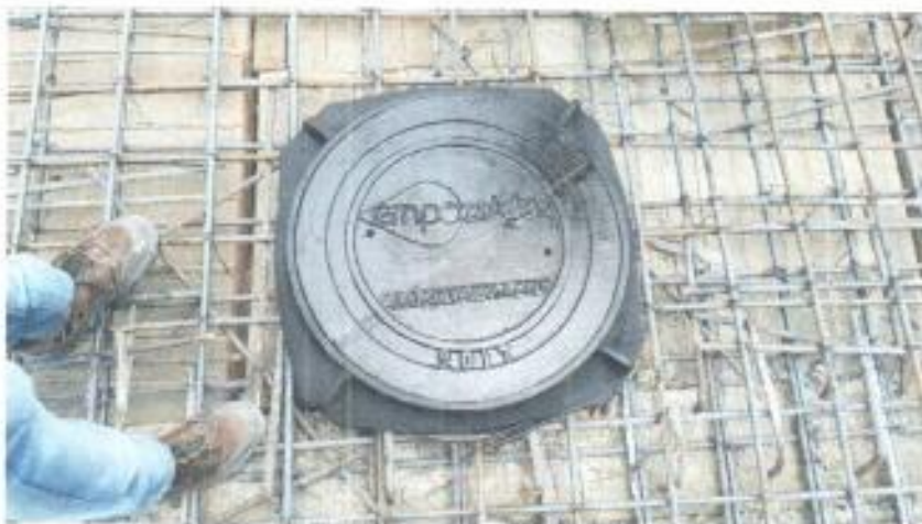
Foto 28. Instalación de tapas HF para cámaras y pozos.
