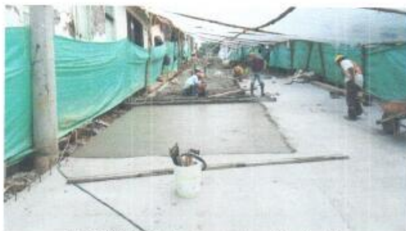
Foto 24. Vaciado de concreto losas No. 40 y 41.
