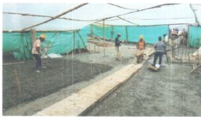
Foto 8. Instalación y compactación de subbase, carrera 3 entre calles 10 y 9A.
