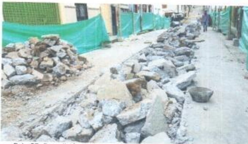
Foto 35. Demolición de franja de pavimento entre las calles 9A y 8.
