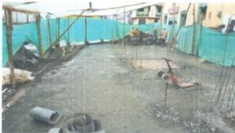
Foto 7. Instalación y compactación de subbase, salida calle 10 a carrera 3 y variante.
