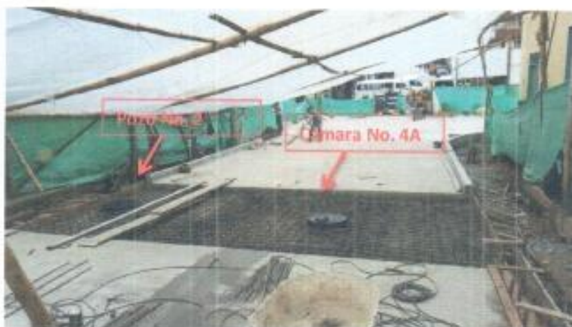
Foto 25. Acero de refuerzo y vaciado de concreto losa No. 22, sobre la cámara No. 4A del Box Coulvert y el pozo de alcantarillado No. 2 (alcantarillado lado Derecho Aguas arriba).
