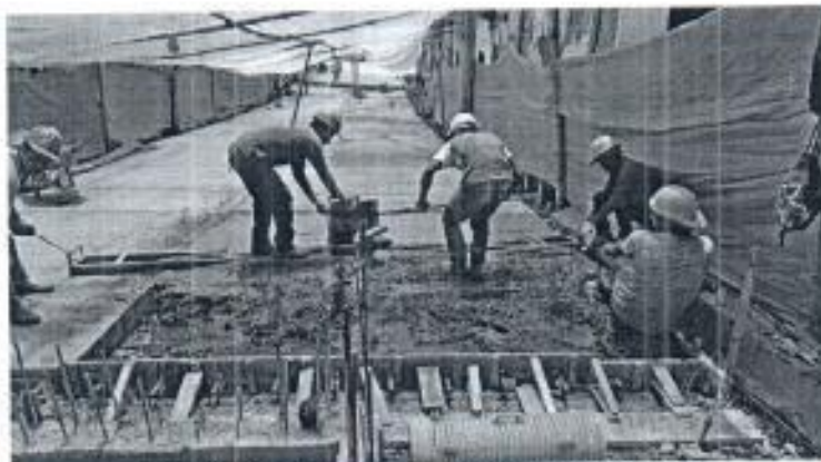
Foto 8. Vaciado de concreto losa No. 42.
