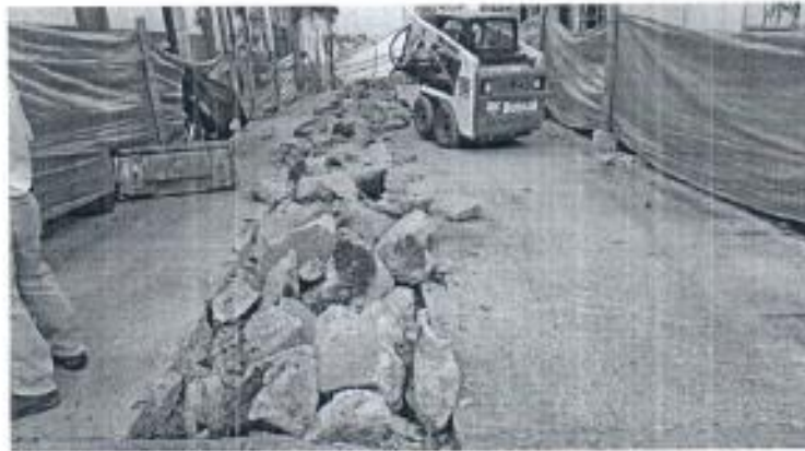
Foto 15. Demolición de franja de pavimento entre las calles 9A y 8.
