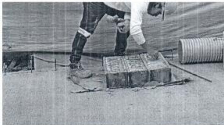
Foto 13. Toma de muestras Vaciado de concreto losa No. 42.
