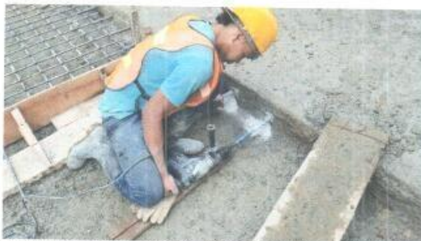
Foto 16. Perforaciones para dovelas pavimento viejo, empalme pavimento nuevo losas No. 14 y 15
