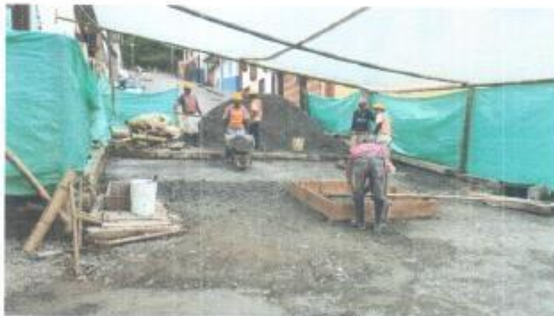
Foto 6. Instalación y compactación de subbase, salida calle 10 a carrera 3.
