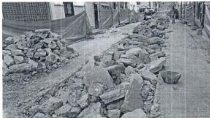
Foto 16. Demolición de franja de pavimento entre las calles 9A y 8.
