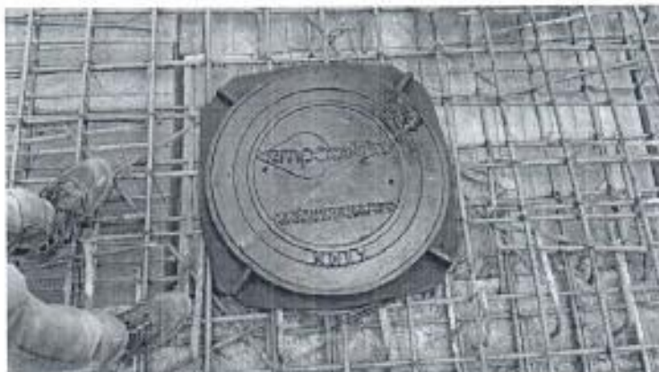
Foto 9. Instalación de tapas HF para cámaras y pozos.
