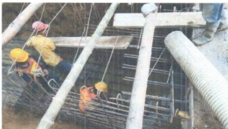
Foto 2. Armado acero de refuerzo último tramo de box coulvert y cámara No. 4.
