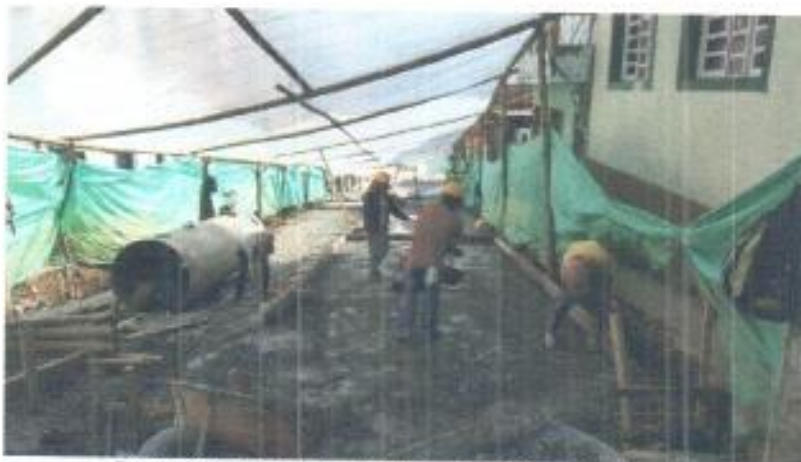
Foto 30. Vaciado de concreto losas No. 50, 51 y 52
