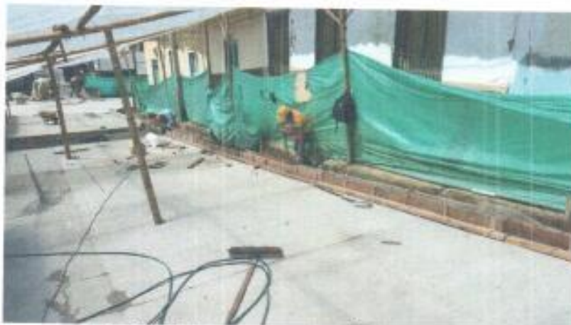
Foto 22. Trabajos en construcción de sardineles.
