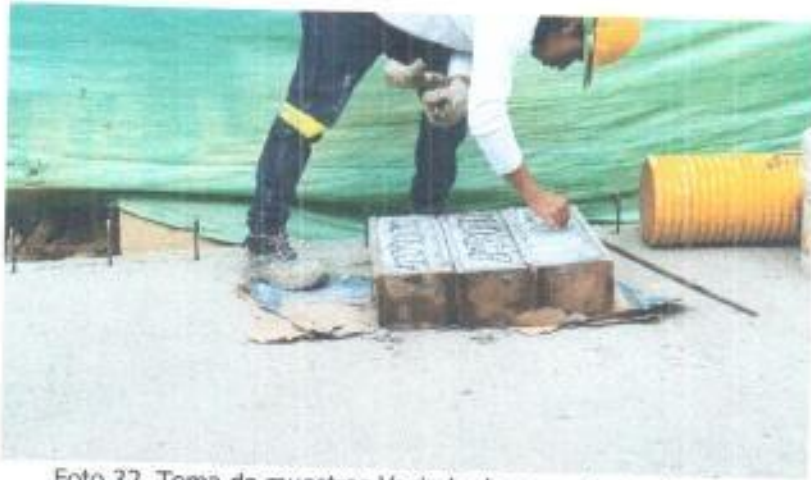
Foto 32. Toma de muestras Vaciado de concreto losa No. 42.
