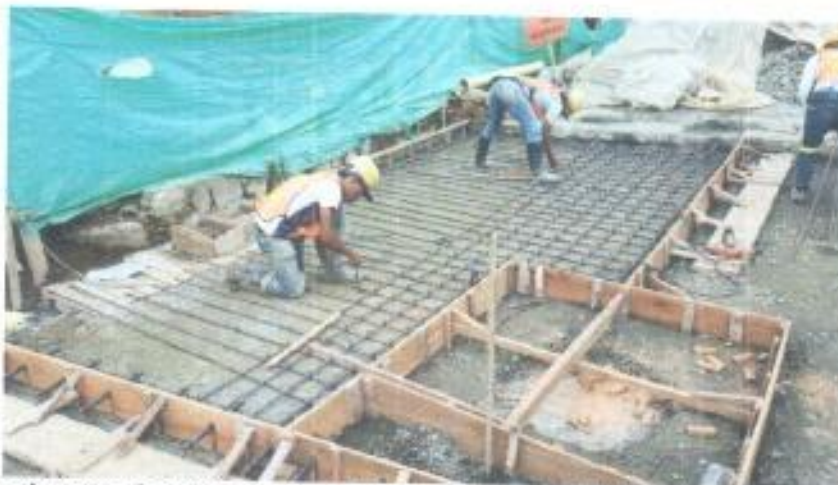
Foto 14. Armado acero de refuerzo losa de pavimento No. 15. Salida Calle 10 a esquina Carrera 3.
