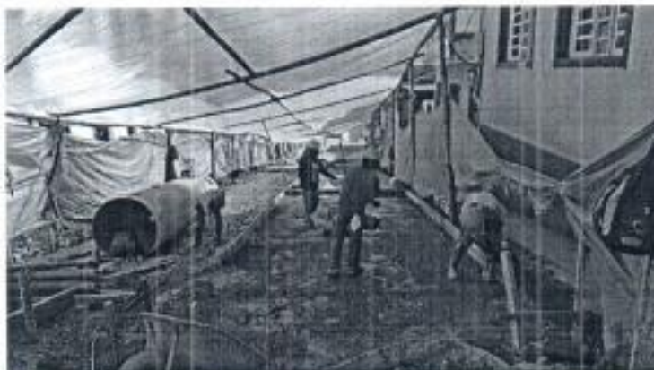
Foto 11. Vaciado de concreto losas No. 50, 51 y 52
