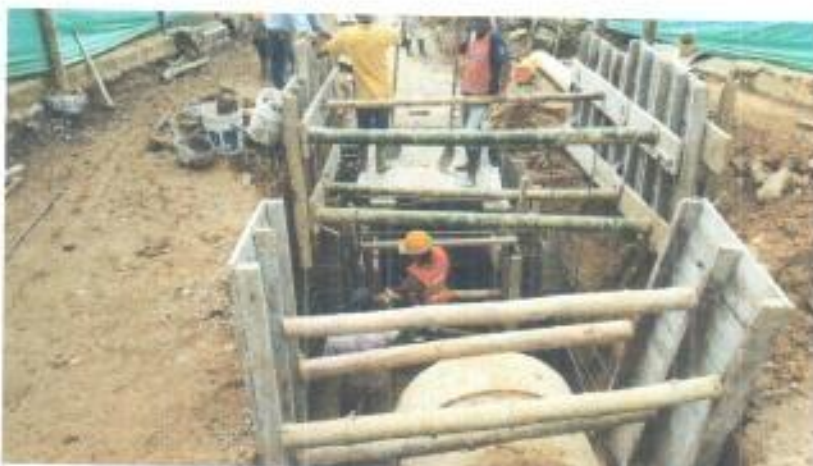
Foto 4. Vaciado de concreto último tramo de box culvert y cámara No. 4.
