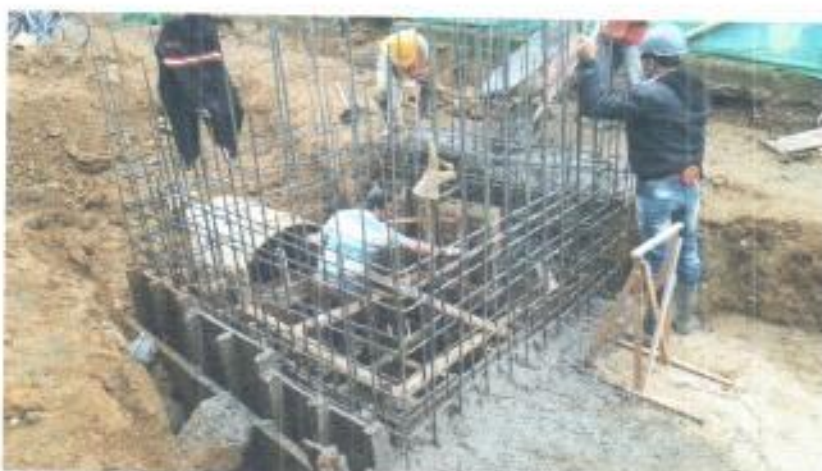
Foto 5. Vaciado de concreto último tramo de box culvert y cámara No. 4.
