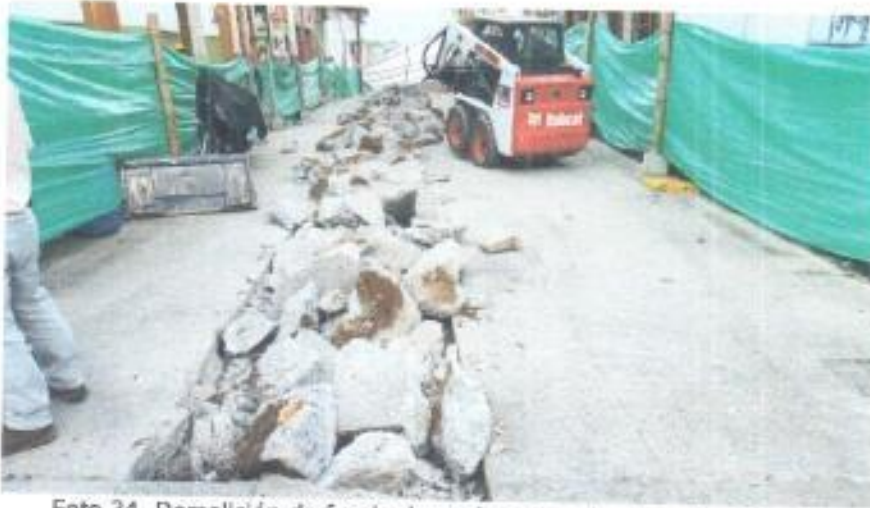
Foto 34. Demolición de franja de pavimento entre las calles 9A y 8.
