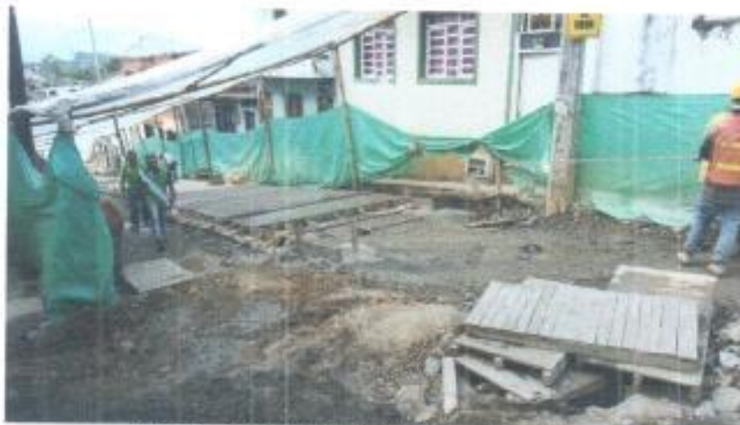
Foto 31. Vaciado de concreto losas No. 53 y 54.
