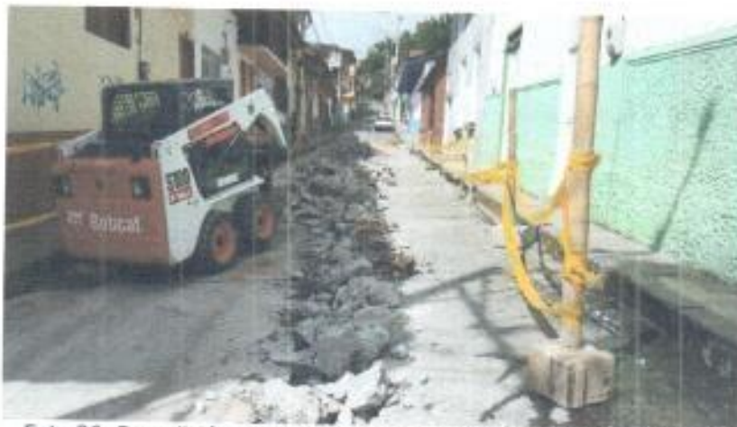
Foto 36. Demolición de franja de pavimento entre las calles 9A y 8.
