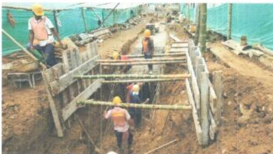
Foto 1. Excavaciones último tramo de box coulvert y cámara No. 4.
