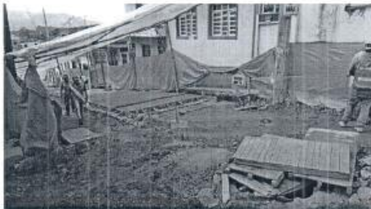
Foto 12. Vaciado de concreto losas No. 53 y 54.
