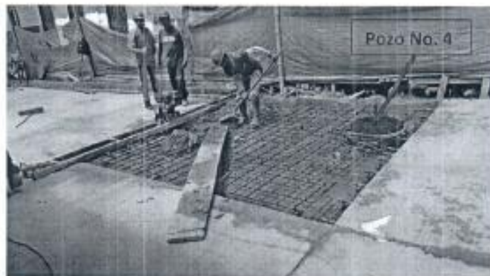
Foto 2. Acero de refuerzo y vaciado de concreto losa No. 37, sobre el pozo de alcantarillado No. 4 (alcantarillado lado Izquierdo Aguas arriba).
