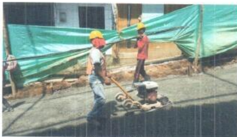
Foto 23. Compactación de subbase.
