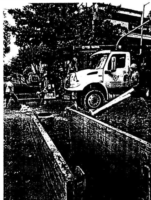
**Foto 6:** Apoyo con el Vactor para Destaponamiento de las redes domiciliarias colapsadas
