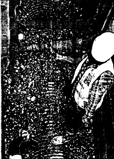
**Foto 5:** relleno de fondo y lateral a la tubería en grava para dar soporte ante las presiones hidráulicas existentes
