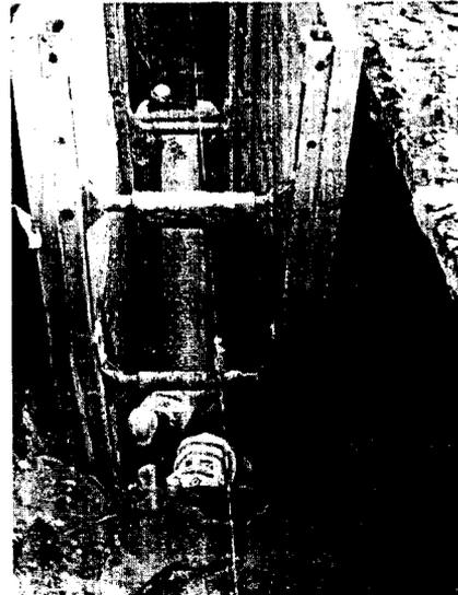
Foto 4: Instalación de tubería Novafort de 18 pulgadas empleando formaleta metálica
