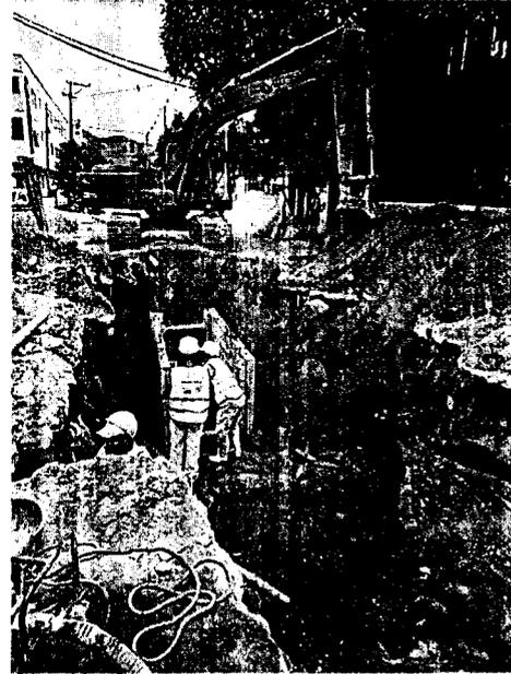
**Foto 10:** Colapso paredes laterales de la zanja para instalación de la tubería de 18 novafort
