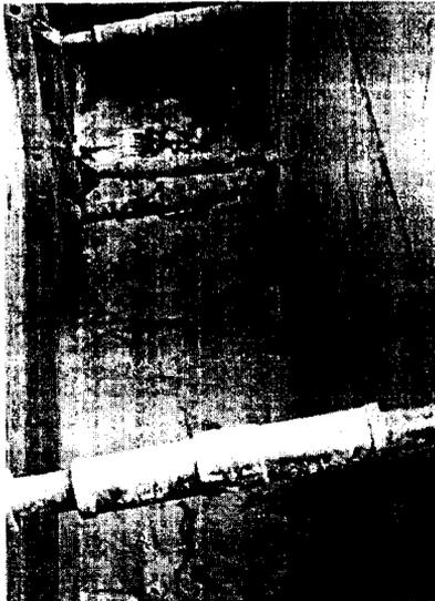
Foto 3: Detalle de la formaleta metálica instalada para excavaciones a gran profundidad
