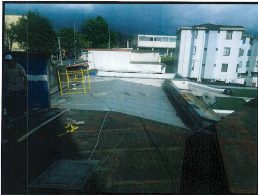
FOTO N°2: IMPERMEABILIZACION CUBIERTA CON SIKAFILL
