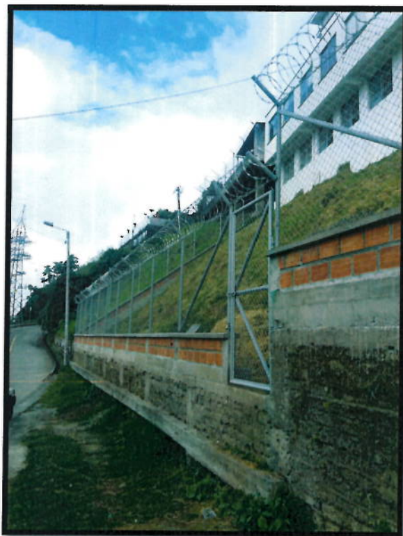
FOTO N°9: CONSTRUCCION CERRAMIENTO EN MALLA ESLABONADA PARTE POSTERIOR
