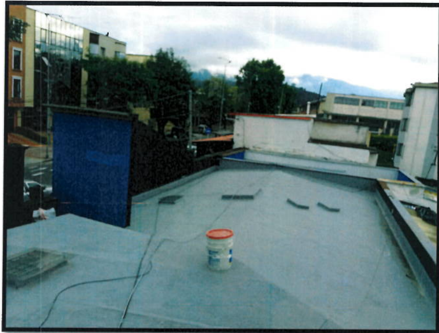
FOTO N°7: CUBIERTA IMPEMERABILIZADA CON SIKAFILL
