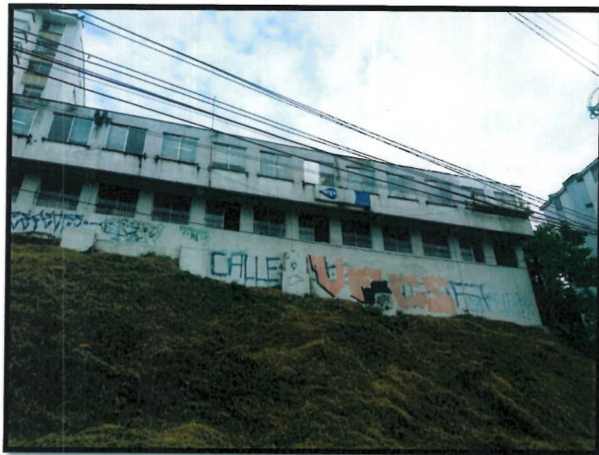
FOTO N°7: FACHADA POSTERIOR ANTES SER INTERVENIDA
