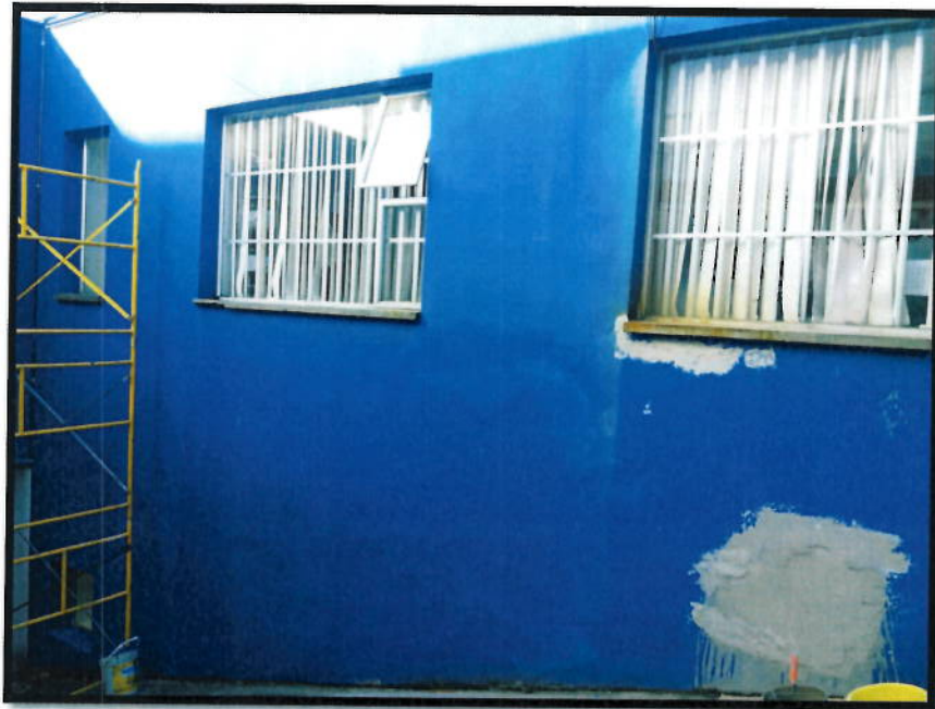
FOTO N°14: PINTURA Y MANTENIMIENTO FACHADA EXTERIOR
