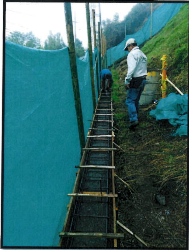
FOTO N°8: CONSTRUCCION CIEMENTACION CERRAMIENTO EN MALLA ESLABONADA
