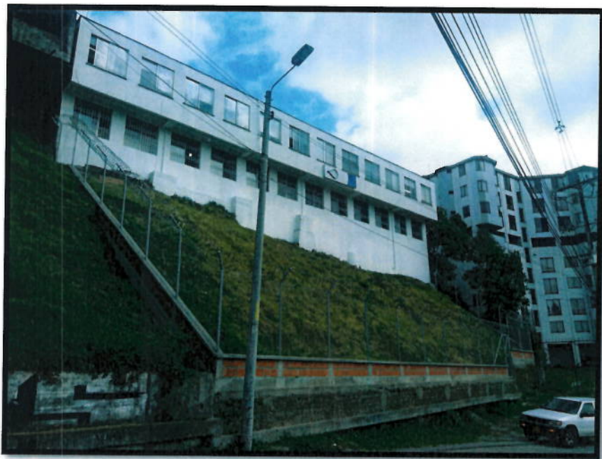
FOTO N°8: CONSTRUCCION CERRAMIENTO EN MALLA ESLABONADA PARTE POSTERIOR
