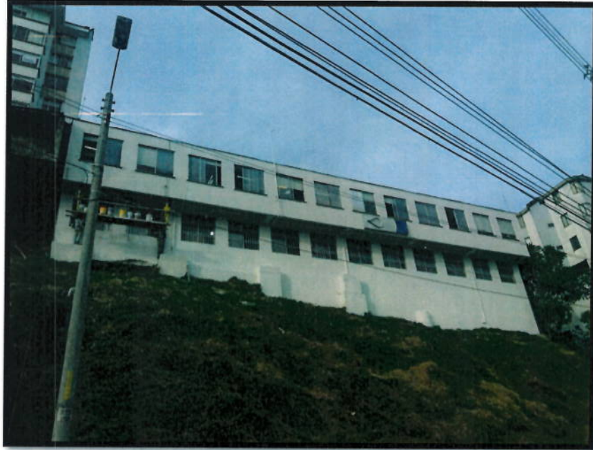
FOTO N°8: PARTE POSTERIOR PARA CERRAMIENTO EN MALLA ESLABONADA
