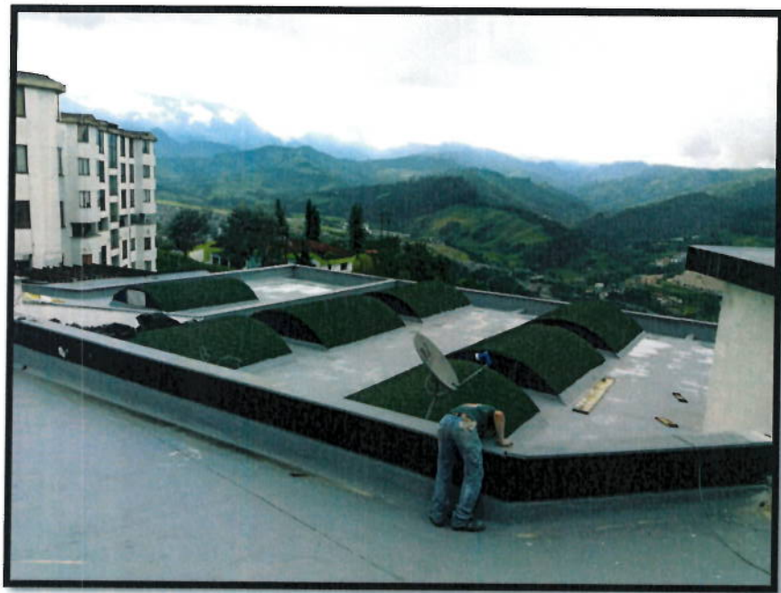
FOTO N°6: CUBIERTA IMPEMERABILIZADA CON SIKAFILL
