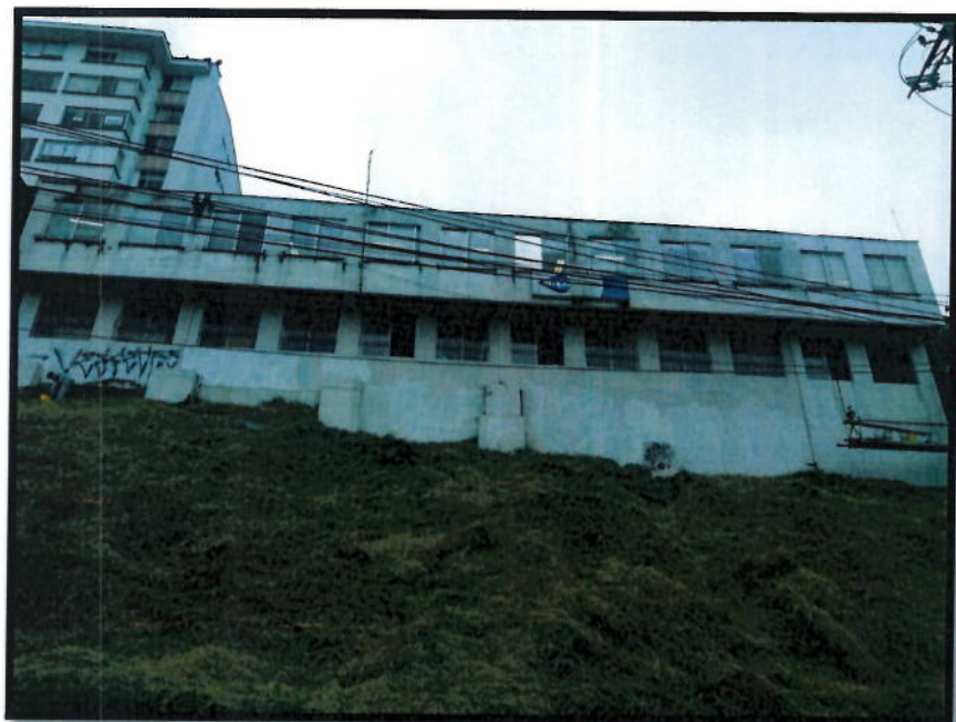
FOTO N°10: FACHADA EXTERIOR PARA MANTENIMIENTO
