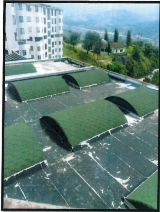
FOTO N°5: ESTADO CUBIERTA DURANTE LA INTERVENCION
