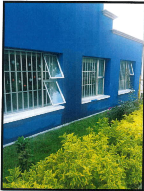
FOTO N°13: PINTURA Y MANTENIMIENTO FACHADA EXTERIOR
