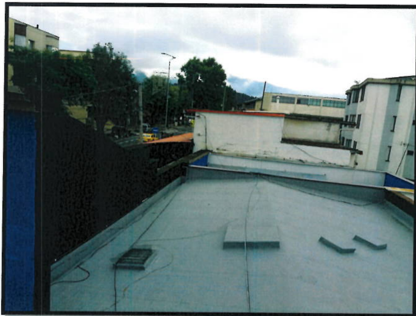
FOTO N°4: IMPERMEABILIZACIÓN CUBIERTA Y DEMAS ELEMENTOS
