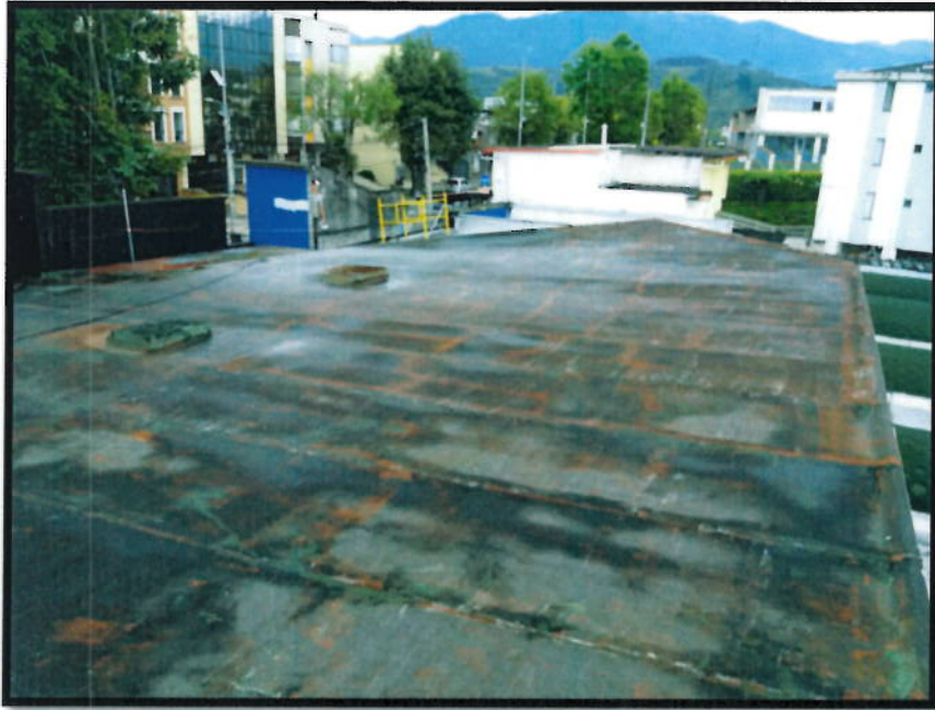
FOTO N°1: CUBIERTA EN CONCRETO PARA IMPERMEABILIZAR
