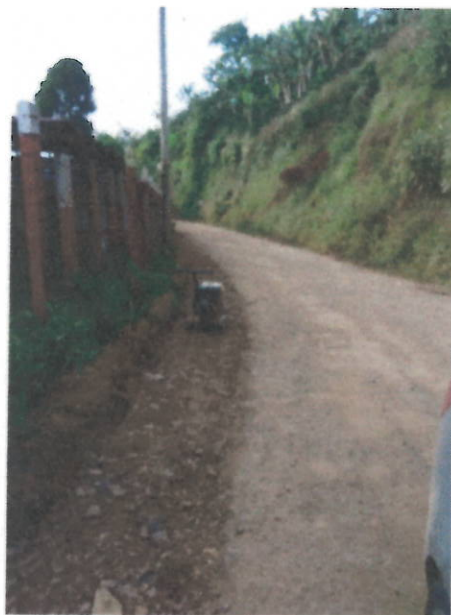
Afirmado siendo compactado con rana.
