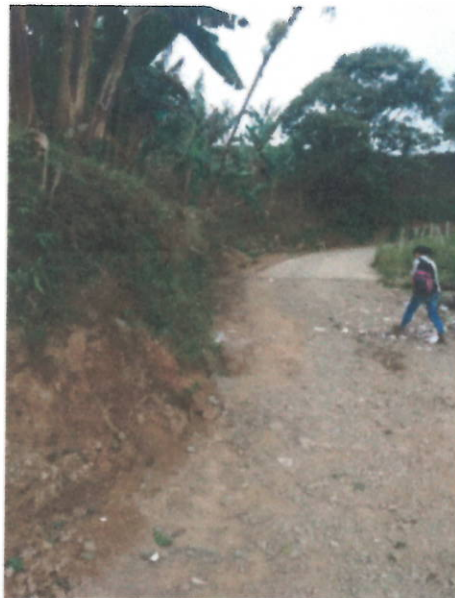
Zona de instalación de tubería PVC de diámetro 1"
