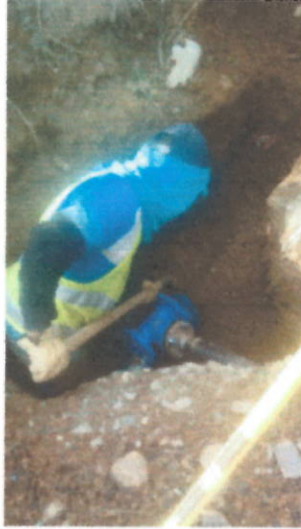
Zona de empalme e instalación de tee.
