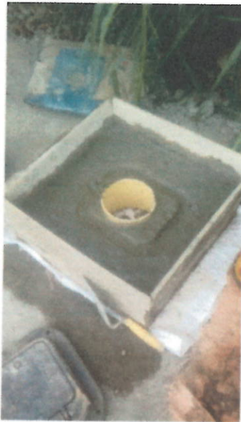
Instalación de tapa tipo chorote
