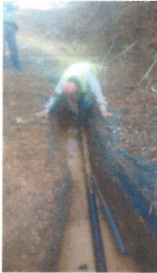
Arreglo de tubería por daños causados en la vía
