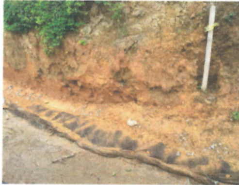
Instalación de tubería de 1" detrás de filtro. Sector Risaralda
