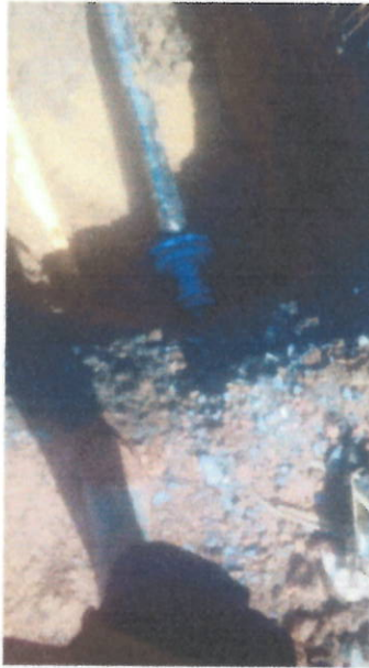
Instalación de reducción y adaptador bridado
