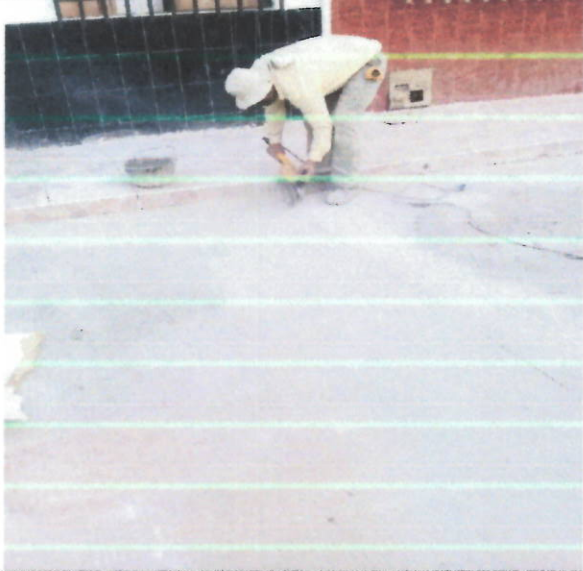
Descripción: Corte para dilatación de pavimento
