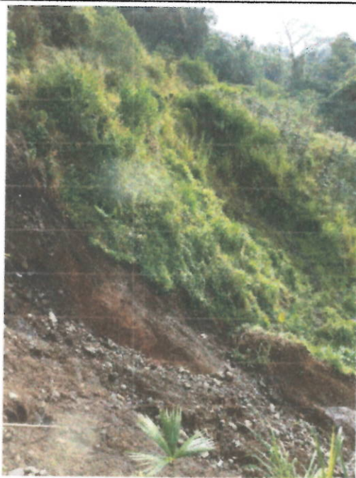
Fotografía 2. La ladera inferior de la banca del ferrocarril es de pendientes más fuertes. Sufre deslizamientos de suelos superficiales. La fotografía muestra los escarpes de deslizamientos: uno antiguo y otro más reciente.
