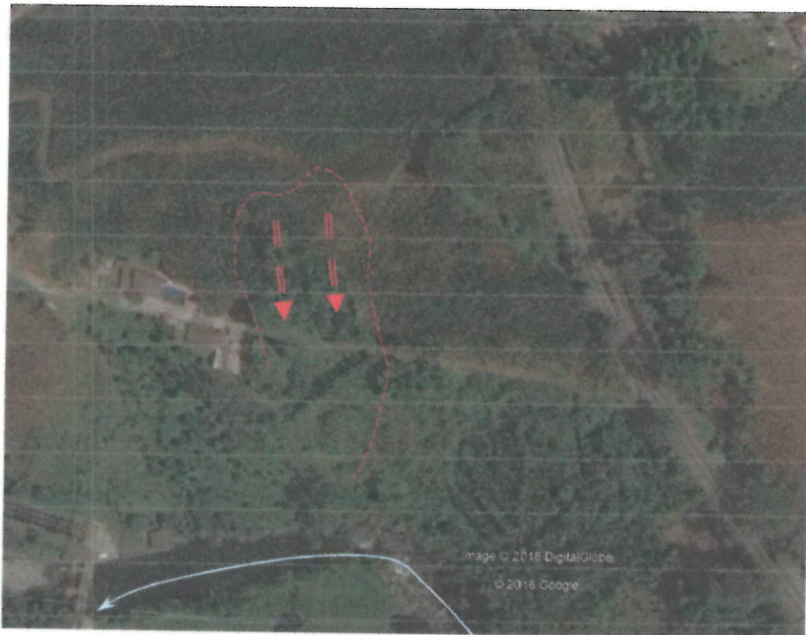
Fotografía 1. Vista aérea de la zona de influencia del movimiento en masa antiguo. La línea roja punteada sigue la trayectoria del contorno de una masa de suelo que sufrió movimiento. Las flechas rojas marcan la dirección dominante del movimiento; la flecha azul la dirección de la corriente.
