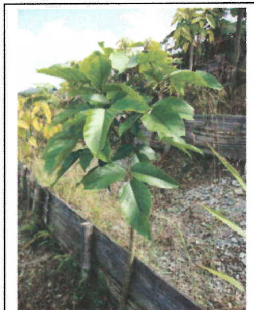
Fotografía 3 Tratamiento con trinchos en esterilla de guadua y estacas vivas.
