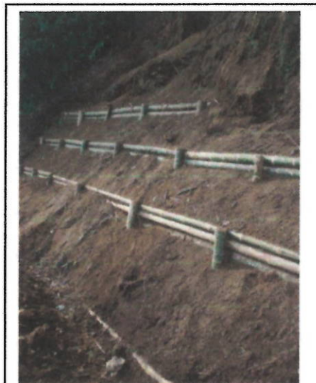
Fotografía 4. Trinchos en madera. Los trinchos mejoran la estabilidad del talud y permiten las pendientes del suelo para el arraigo de la vegetación. (Carlos E Escobar P)
