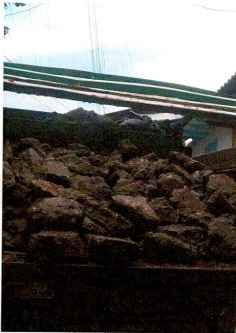
FOTO 3. Retiro de escombros en volqueta.
