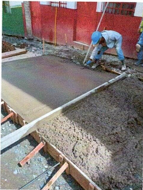
FOTO 19. Nivelado del concreto
