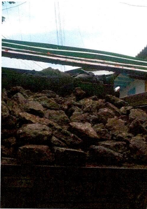
FOTO 3. Retiro de escombros en volqueta.
