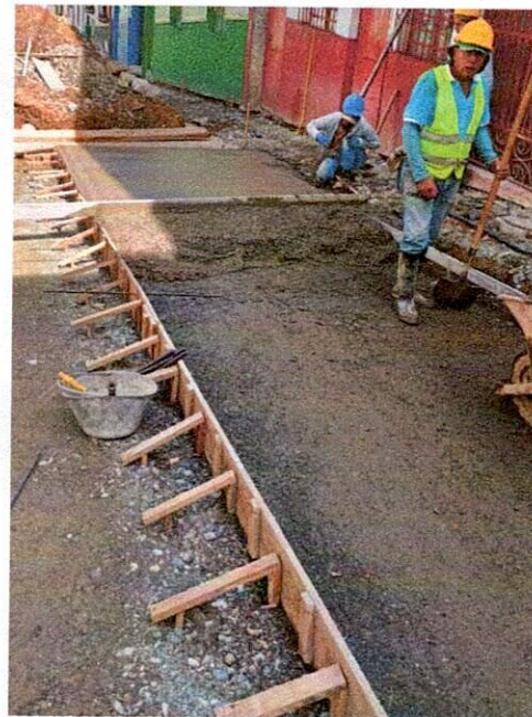
FOTO 12. Instalación de formaleta.
