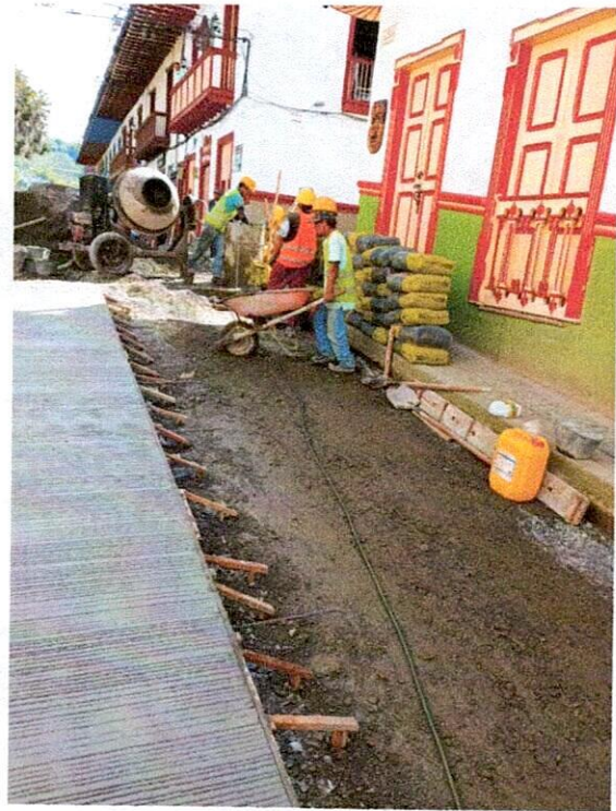
FOTO 18. Vaciado de concreto.
