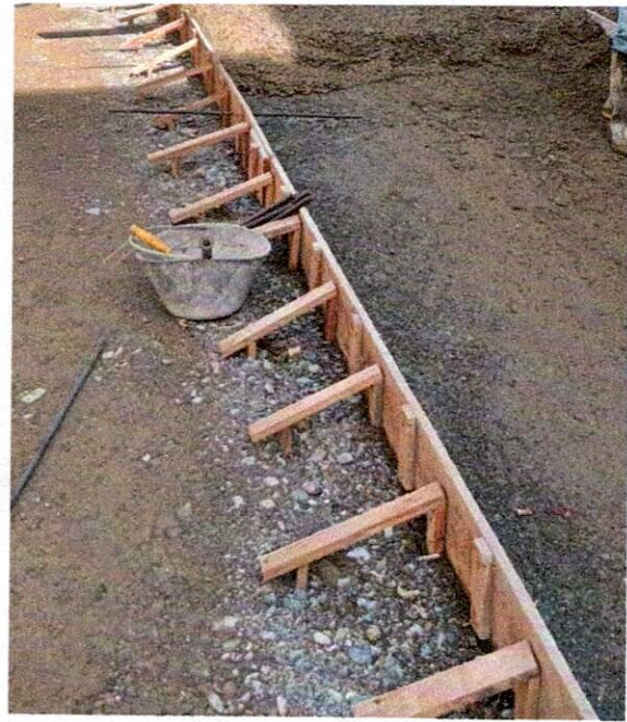
FOTO 14. Instalación de formaleta.
