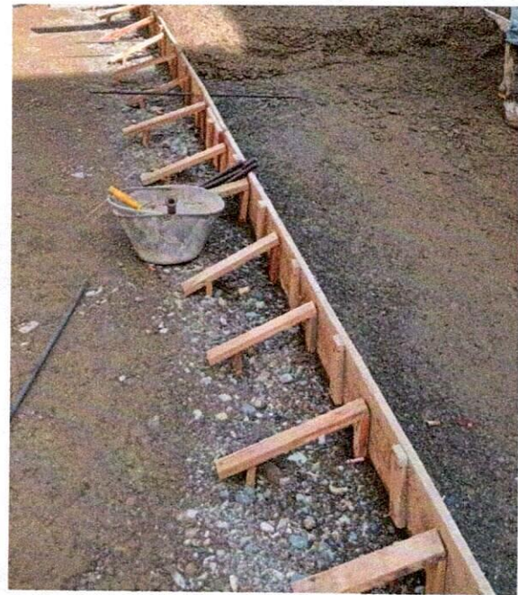
FOTO 14. Instalación de formaleta.
