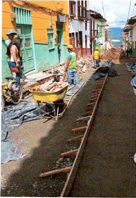
FOTO 13. Instalación de formaleta.
