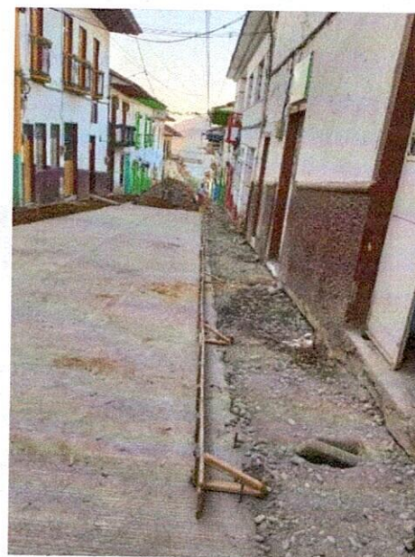
FOTO 20. Instalación de subbase andenes
