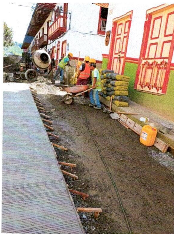
FOTO 18. Vaciado de concreto.
