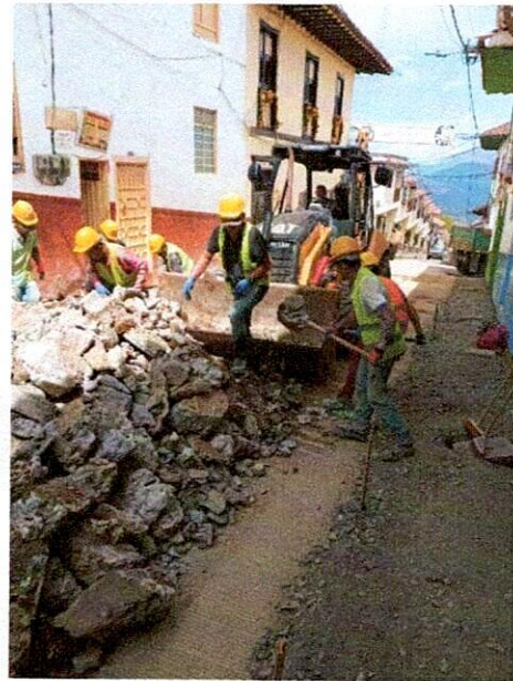
FOTO 2. Evacuación de escombros
