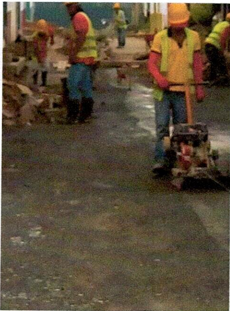
FOTO 11. Compactación de subbase.
