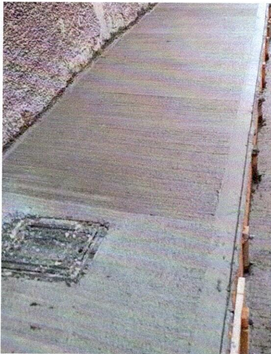
FOTO 23. instalación de tapas de acueducto.
