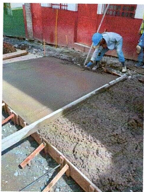
FOTO 19. Nivelado del concreto
