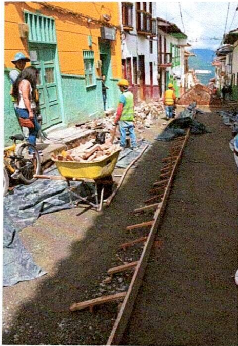
FOTO 13. Instalación de formaleta.
