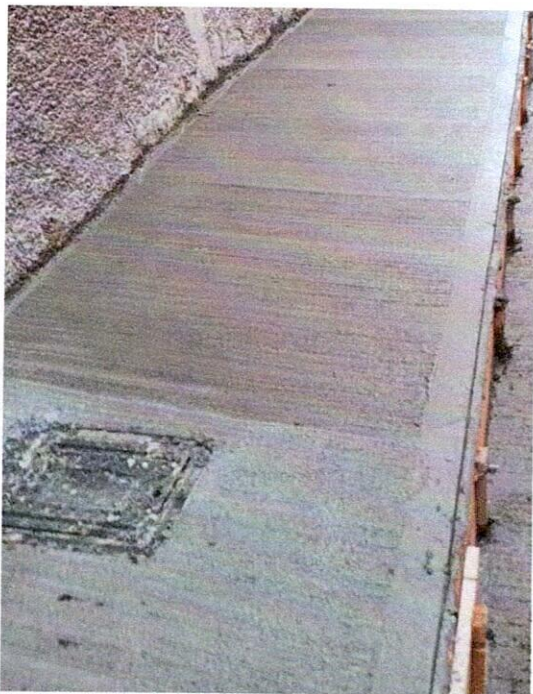
FOTO 23. instalación de tapas de acueducto.
