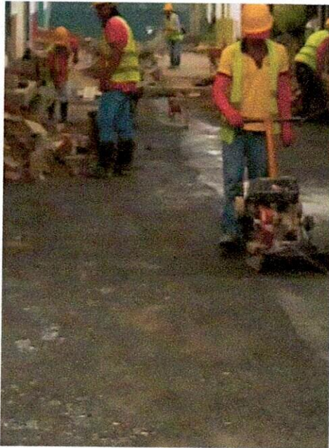
FOTO 11. Compactación de subbase.
