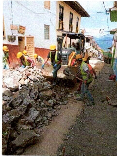
FOTO 2. Evacuación de escombros
