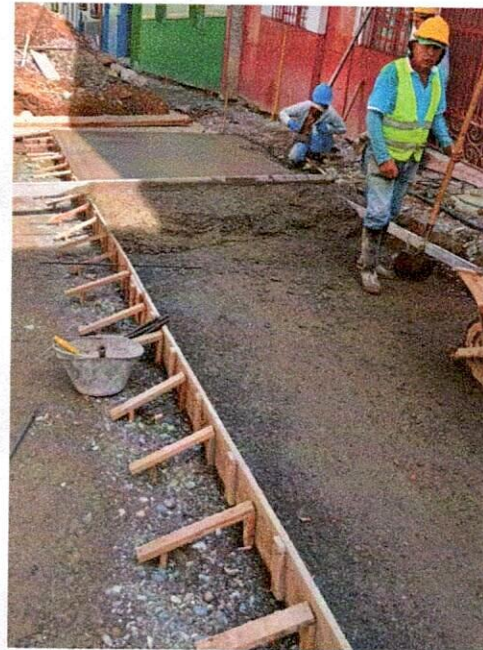
FOTO 12. Instalación de formaleta.
