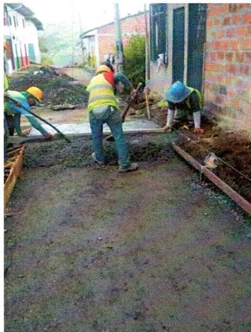
**FOTO 14. Vaciado de pavimento.**
