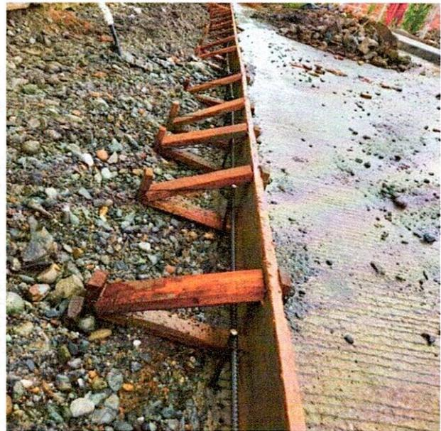
**FOTO 20. Instalación de subbase andenes**
