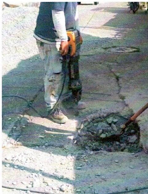
**FOTO 1. Demolición con equipo manual**
