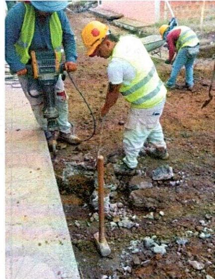
FOTO 2. Demolición con equipo manual.
