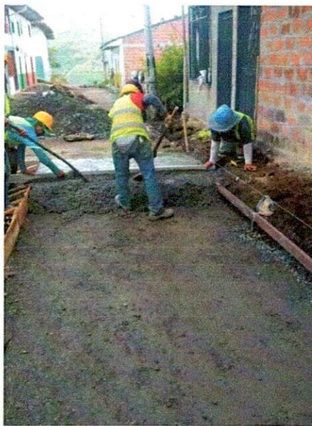
**FOTO 14. Vaciado de pavimento.**
