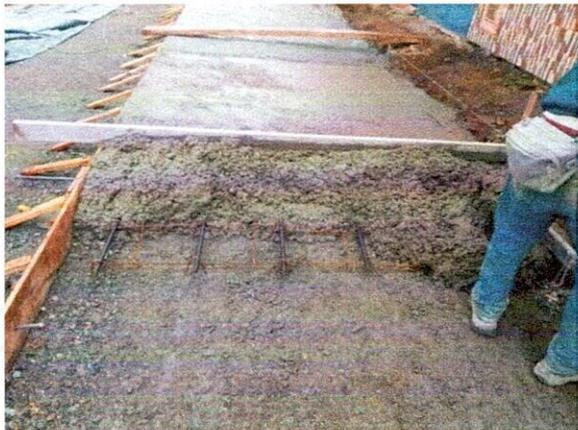
**FOTO 19. Nivelado del concreto**
