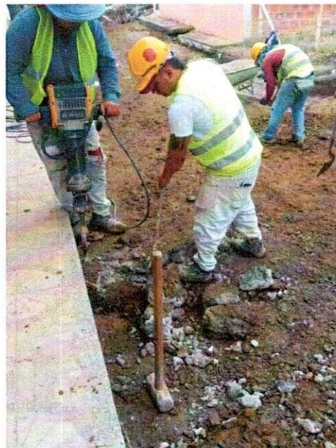
**FOTO 2. Demolición con equipo manual.**
