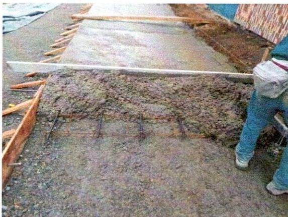
**FOTO 19. Nivelado del concreto**
