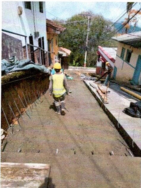
FOTO 11. Instalación de formaleta y pasadores (Cr 8 CI 2 y 3).
