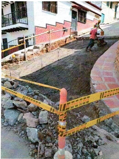
FOTO 9. Compactación de subbase (Cr 8 CI 2 y 3).
