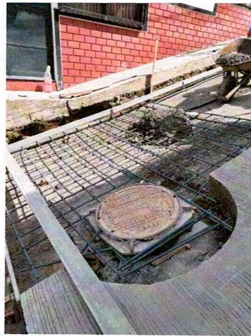
FOTO 10. Acero de refuerzo y tapa alcantarillado (Cr 8 CI 2 y 3).
