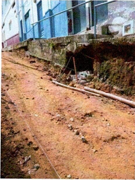
FOTO 5. Excavaciones (Cr 8 CI 2 y 3).
