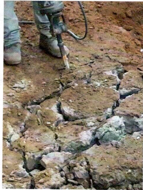
FOTO 2. Demolición con equipo manual (Cr 8 CI 2 y 3).
