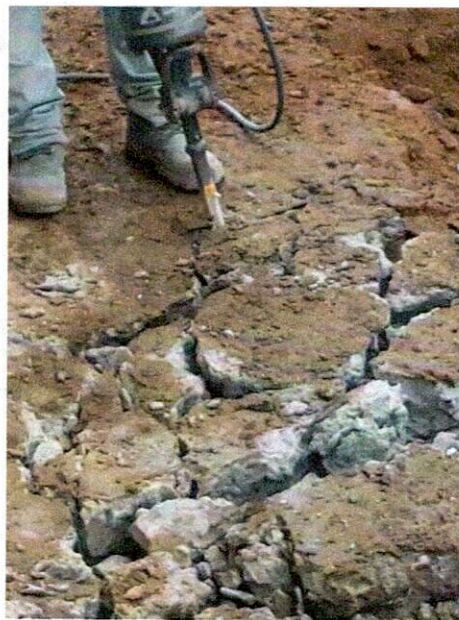
FOTO 2. Demolición con equipo manual (Cr 8 CI 2 y 3).
