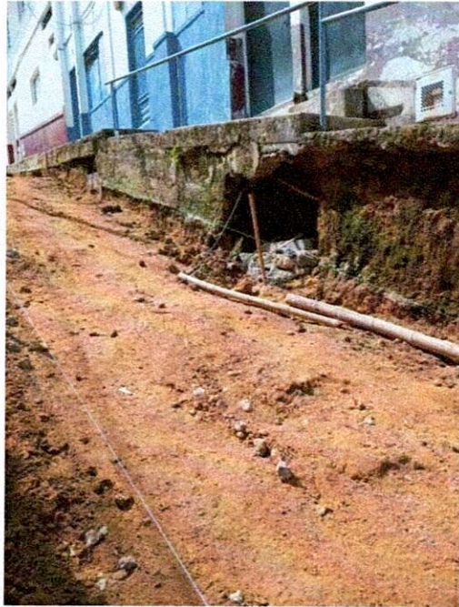
FOTO 5. Excavaciones (Cr 8 CI 2 y 3).
