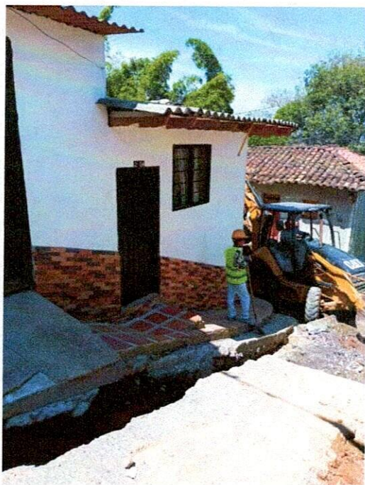
FOTO 3. Demolición (Cr 8 CI 2 y 3).
