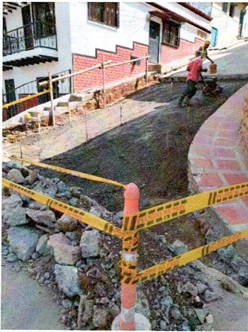
FOTO 9. Compactación de subbase (Cr 8 CI 2 y 3).
