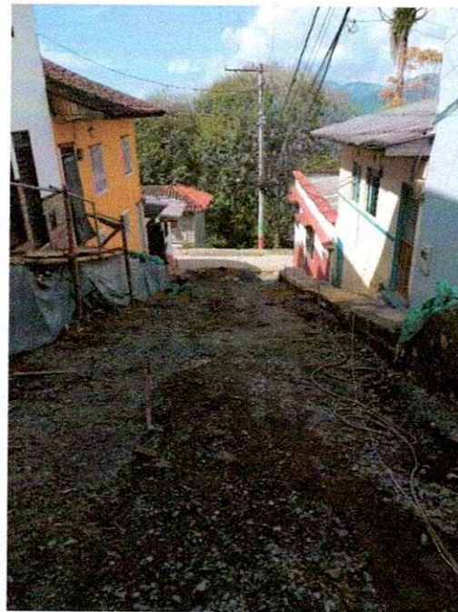
FOTO 4. Evacuación de escombros (Cr 8 CI 2 y 3).
