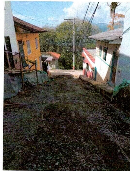
FOTO 4. Evacuación de escombros (Cr 8 CI 2 y 3).
