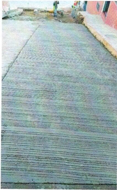
FOTO 13. Texturado de concreto (Cr 8 CI 2 y 3).
