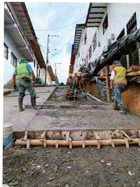
FOTO 12. Vaciado de concreto (Cr 8 CI 2 y 3).
