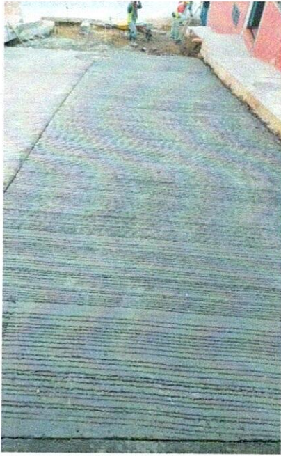
FOTO 13. Texturado de concreto (Cr 8 CI 2 y 3).
