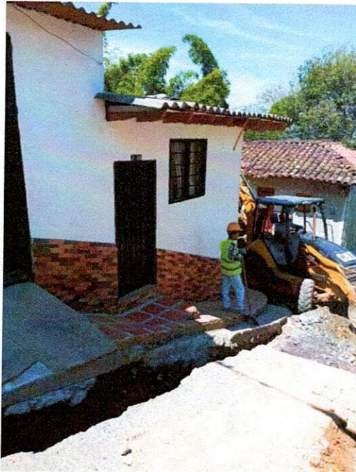
FOTO 3. Demolición (Cr 8 CI 2 y 3).
