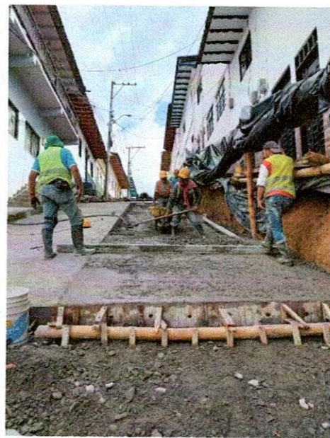
FOTO 12. Vaciado de concreto (Cr 8 CI 2 y 3).
