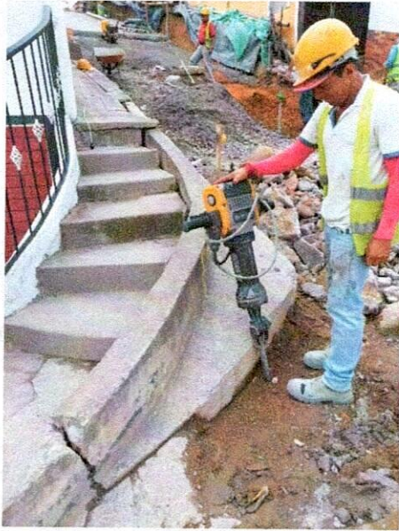
FOTO 1. Demolición con equipo manual (Cr 8 CI 2 y 3)
