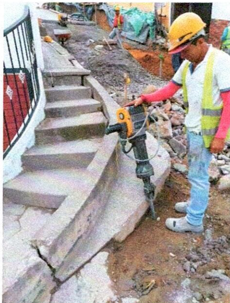
FOTO 1. Demolición con equipo manual (Cr 8 CI 2 y 3)
