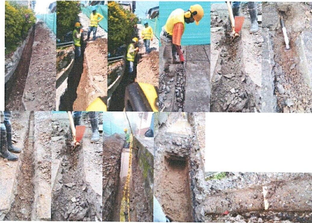
**INSTALACIÓN DE TUBERÍA BIAJIAL PVC 3" (76.2 MM), Y RED DE ACUEDUCTO DOMICILIARIOS DE PVC A MANGUERA PF DE 1/2, CON SUS COLLARINES Y ADAPTADORES.**
