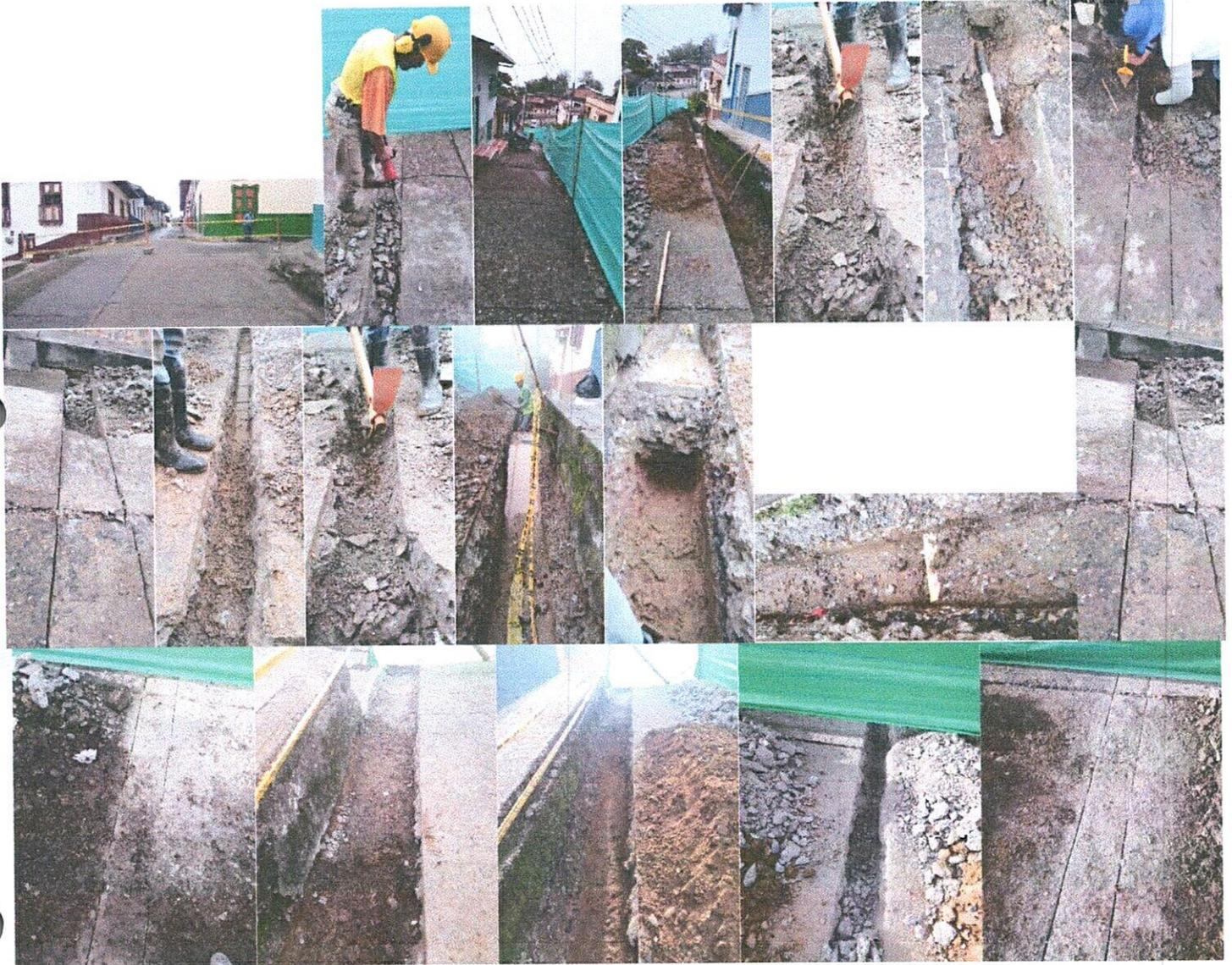
Instalación de Tubería Biaxial PVC 3" (76.2 mm), y red de acueducto domiciliarios de pvc a manguera pf de 1/2, con sus collarines y adaptadores.
