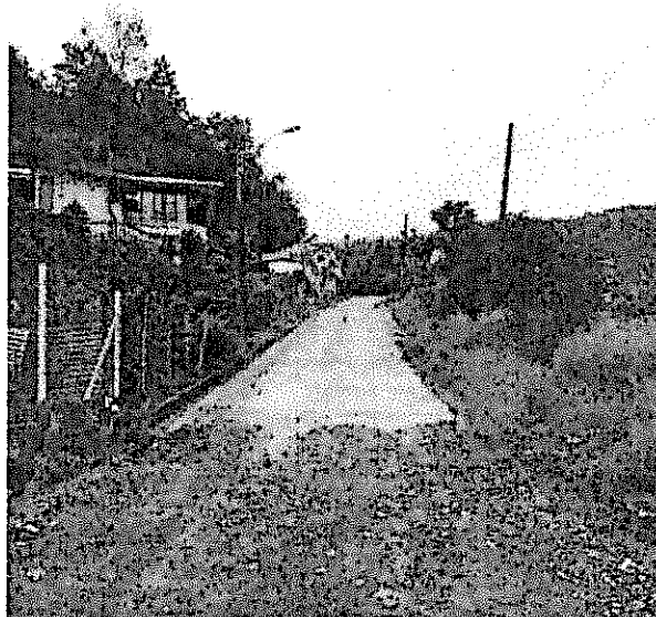
PLACA HUELLA EXISTENTE
