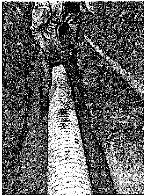
ARENA PARA ATRAQUE DE PROTECCION DE TUBERIA
