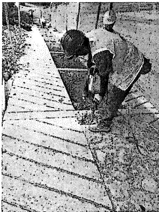
DEMOLICION DE PLACA HUELLA
