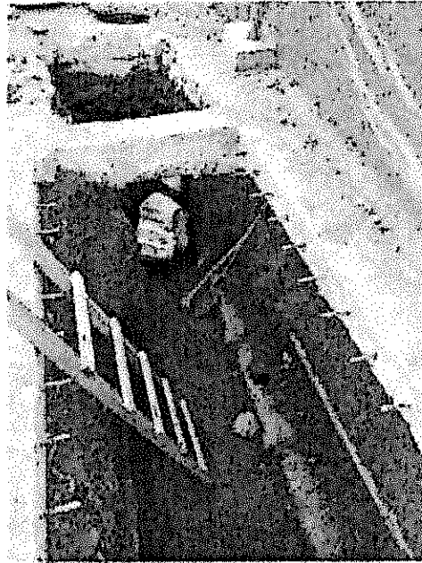
EXCAVACIONES A NIVEL DE TUBERIA EXISTENTE
