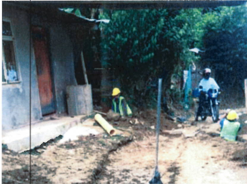
EMPALMES A DOMICILIARIAS
