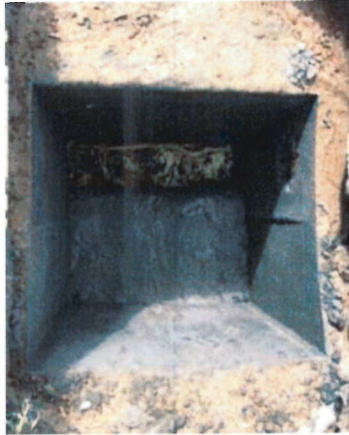
ELABORACION DE BASES Y CAÑUELAS
