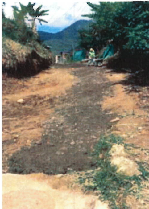
RELLENO DE MATERIAL DE SUB-BASE
