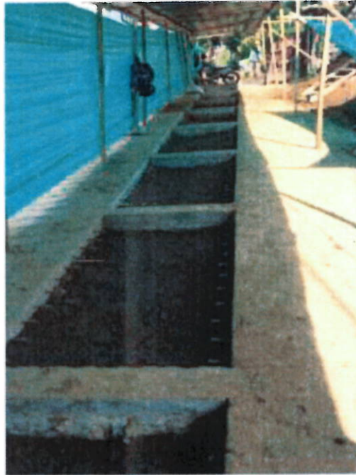
RELLENO CON MATERIAL DE EXCAVACION Y RELLENO CON SUB-BASE PARA PAVIMENTO
