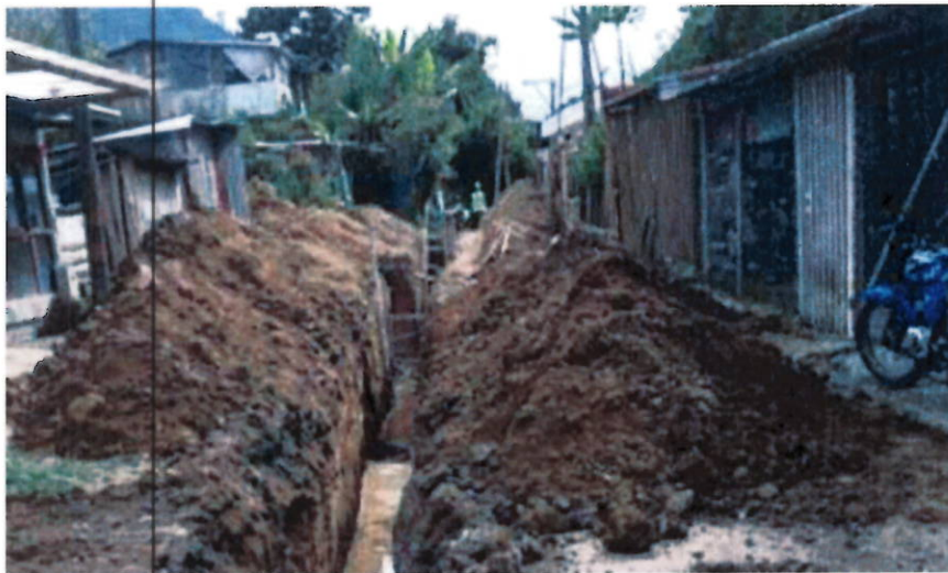
MATERIAL DE ACOPIO
