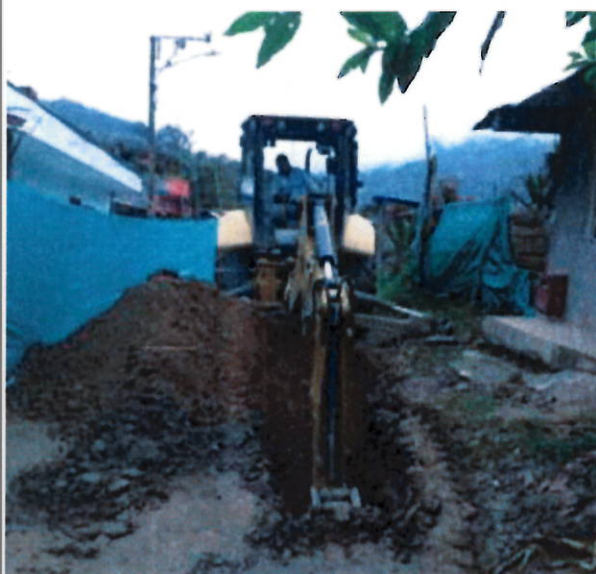
EXCAVACIONES DE 0 A 2 M
