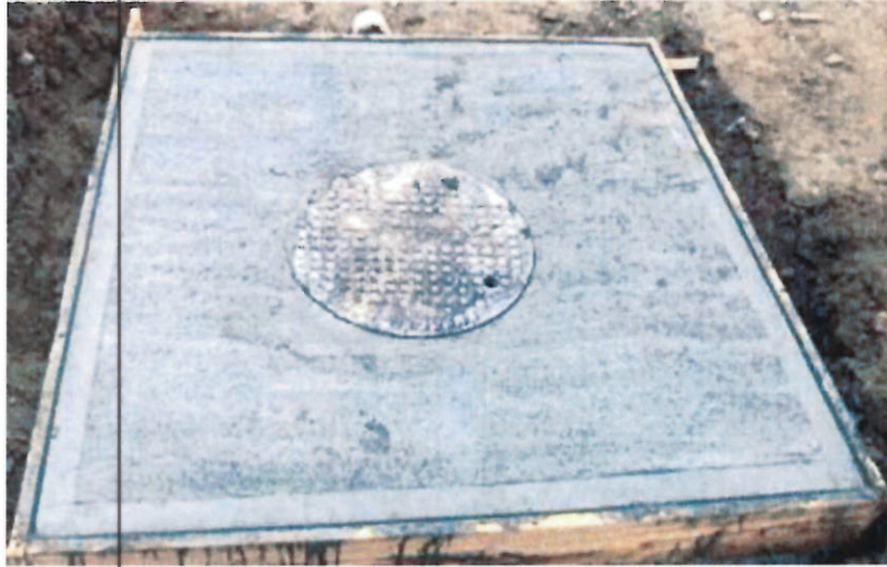
INSTALACION DE LOSA CON TAPAS PARA POZOS DE INSPECCION
