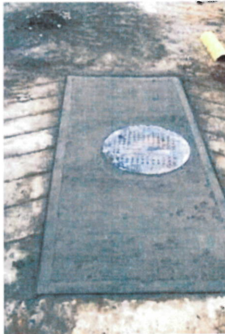
INSTALACION DE LOSA CON TAPAS PARA POZOS DE INSPECCION
