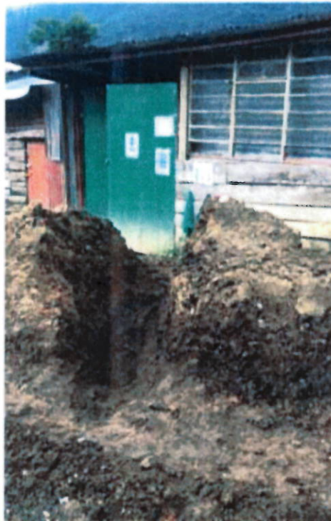
EXCAVACIONES PARA EMPALMES A DOMICILIARIAS
