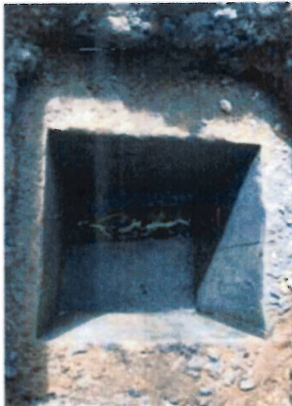
LIMPIEZA DE BASE Y CAÑUELAS
