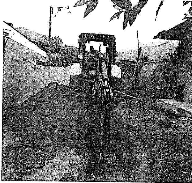
EXCAVACIONES DE 0 A 2 M
