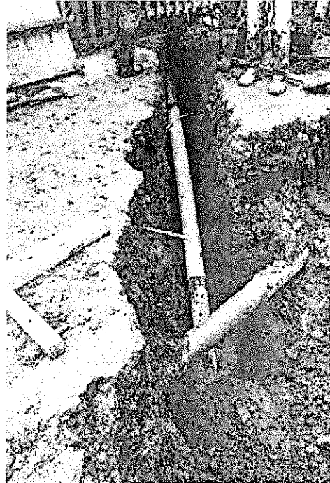
INSTALACION DE TUBERIA 6"
