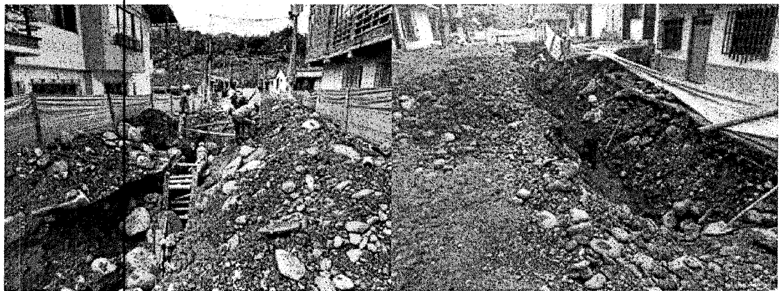
EXCAVACIONES EN MATERIAL ROCOSO
