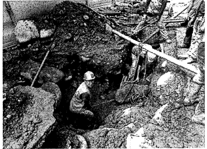
RETIRO DE ROCAS DE GRAN TAMAÑO MEDIANE LA UTILIZACIÓN DE ZOGAS Y TELERAS
