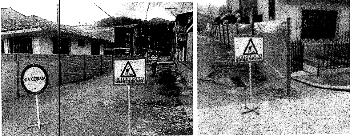
FOTOGRAFÍAS CERRAMIENTO Y SEÑALIZACIÓN DE LA VÍA
