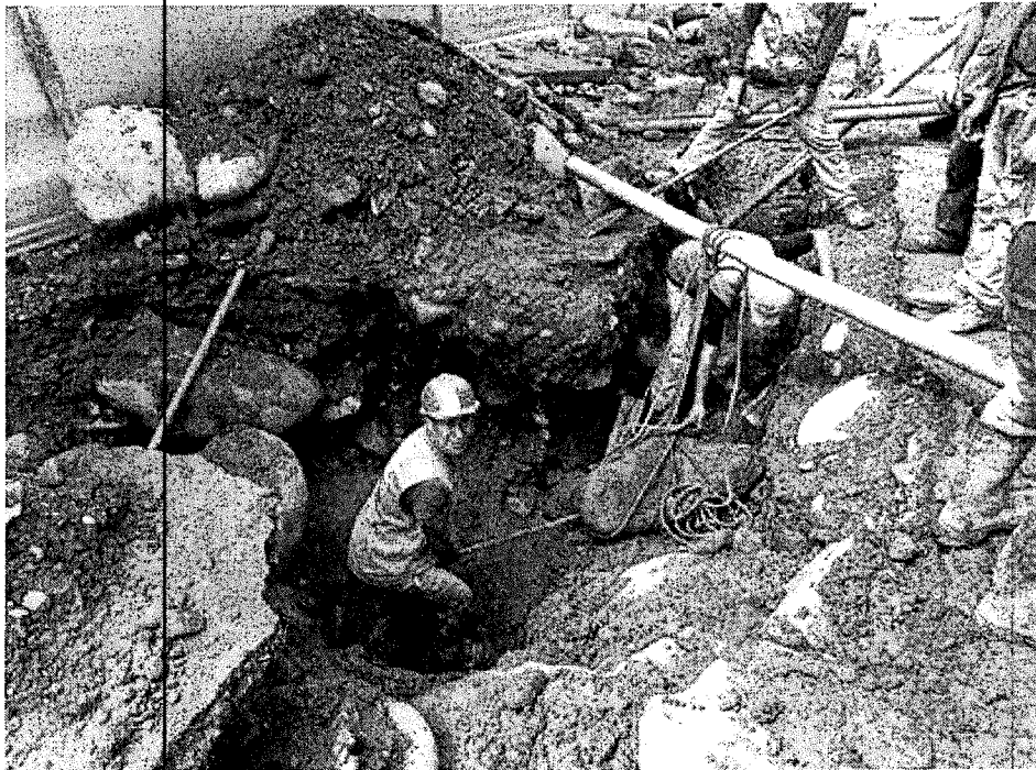
Retiro de rocas de gran tamaño mediante la utilización de zogas
