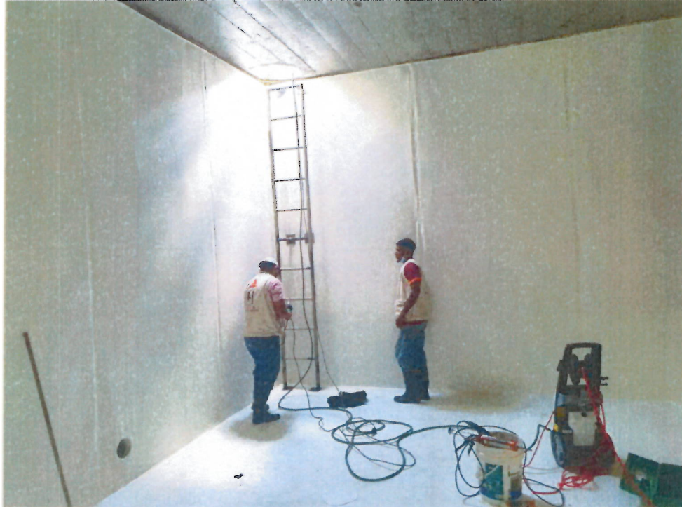
Suministro, transporte e instalacion escalera metalica
