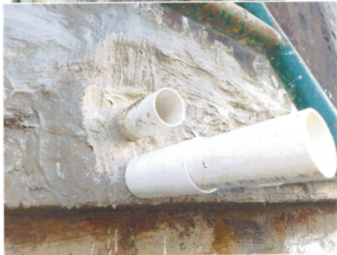
Demolición alrededor de tanque plazuelas
