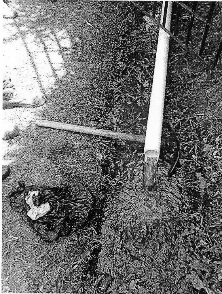
LAVADO TUBERIA Y PRUEBA CONDUCCION
