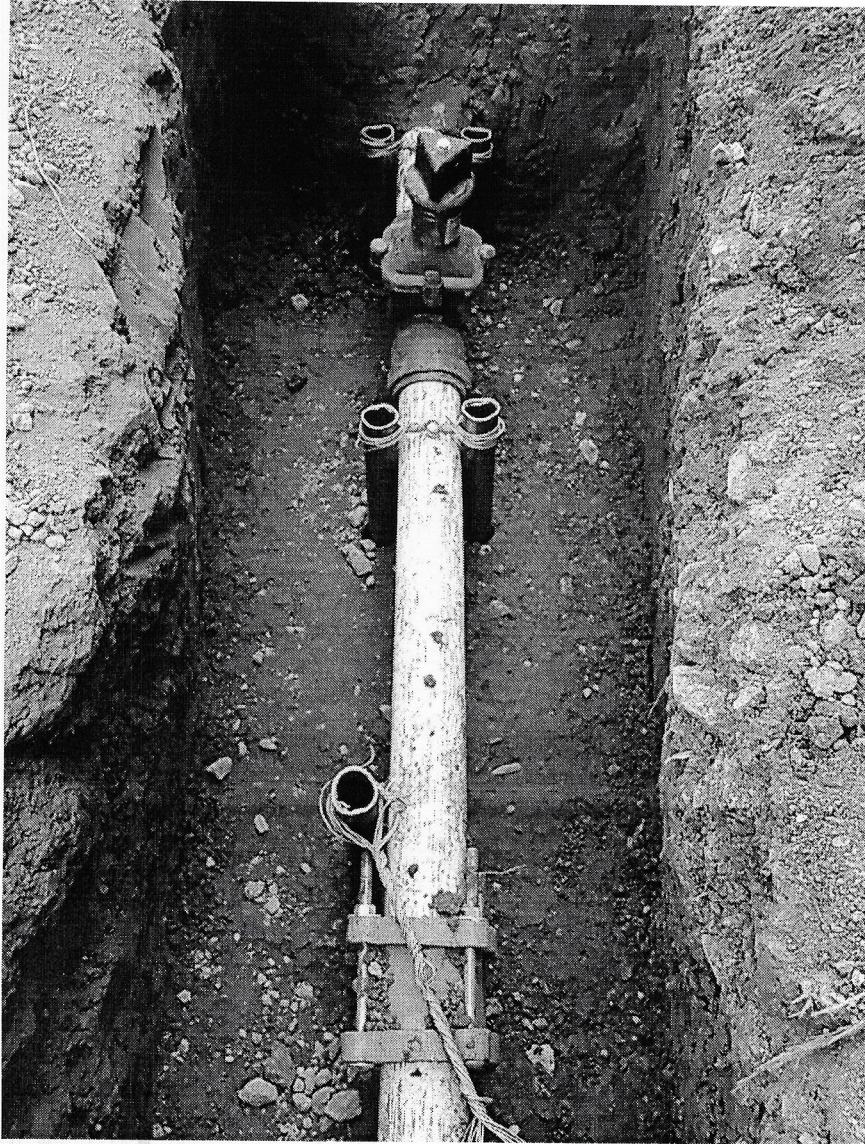
INSTALACION VALVULA Y ANCLAJES K 0 + 900
