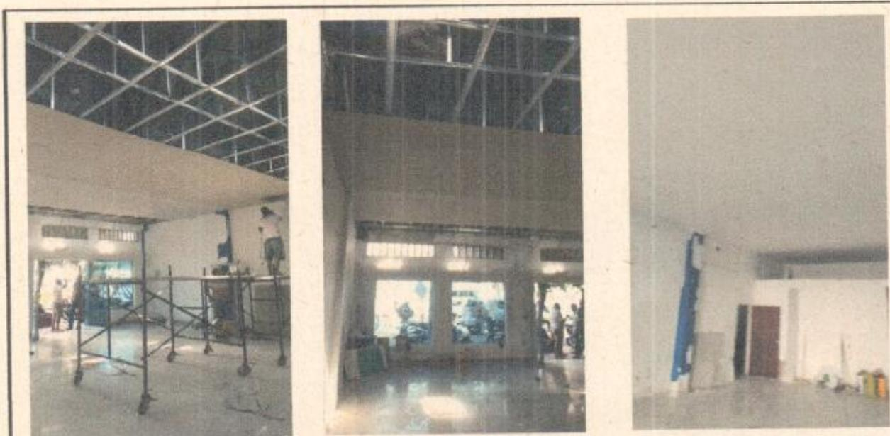
Diciembre 8 de 2017: Pintura Viniltex en muros tres manos, incluye resanes en estuco sintético. Se evidencian paredes desniveladas y con protuberancias a la vista, se procede a resane y respectiva pintura sin nivelar columnas ni paredes.
