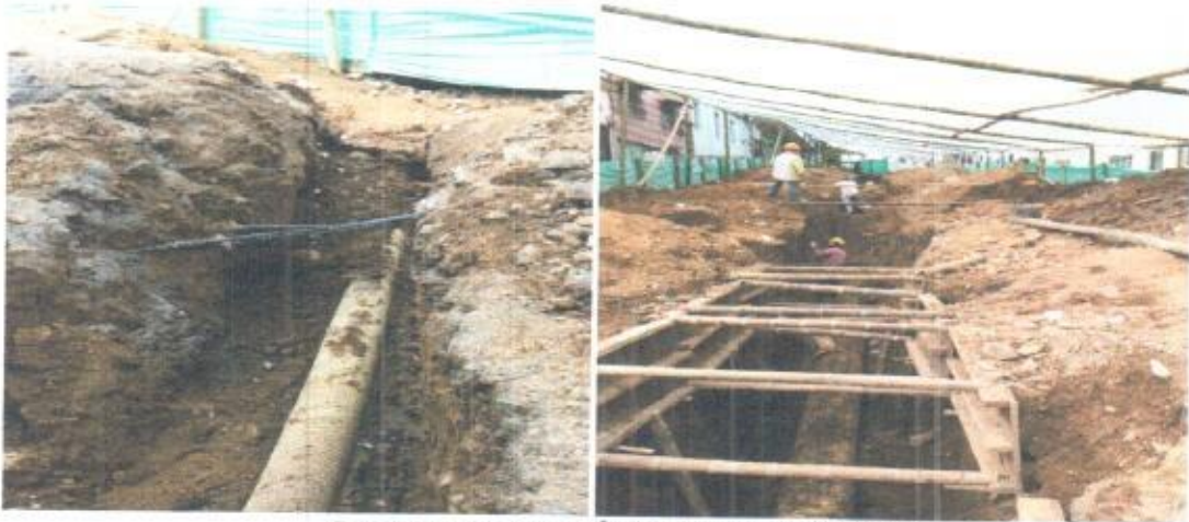
EXCAVACION TUBERÍA PRINCIPAL Y ENTIBADO
