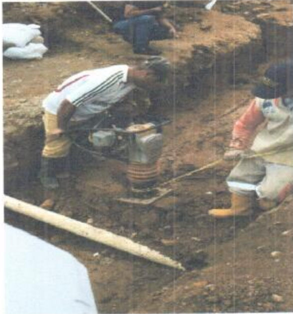
Foto 16 llenos con material del sitio y compactación.
