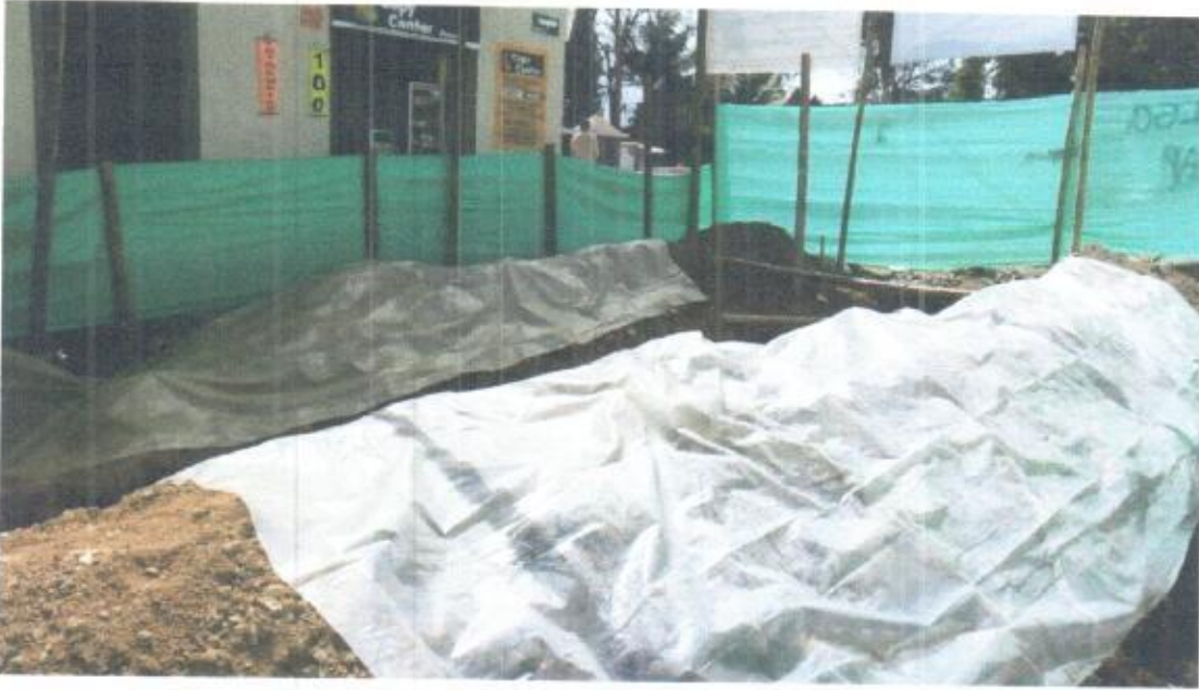
CUBRIMIENTO DE LA TIERRA EXCAVADA.
