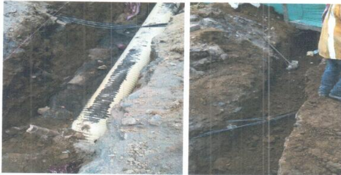
INSTALACIÓN DE TUBERÍA PRINCIPAL HASTA LA CÁMARA MEDIA. LLENOS CON MATERIAL DEL SITIO.
