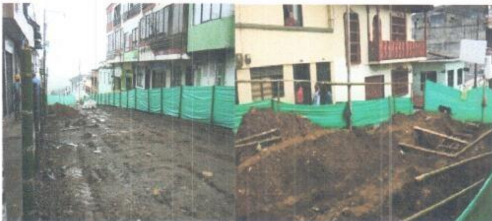
Foto 1. Comienzo de excavación
