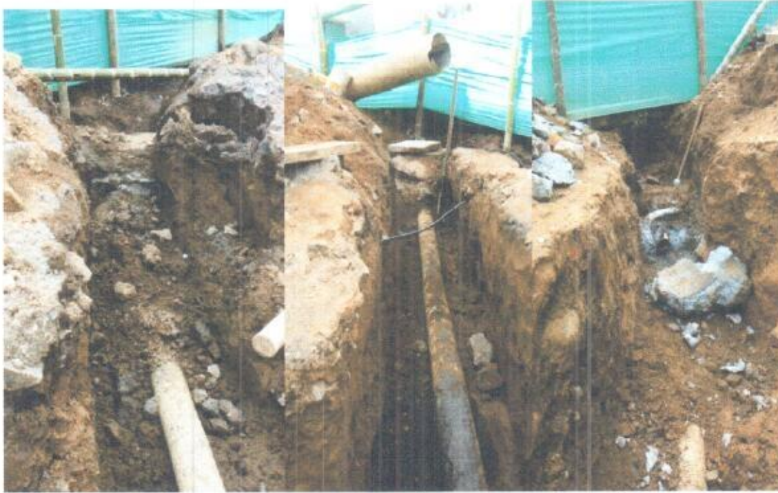
Foto 8. Excavación de domiciliarias y demolición de cajas de inspección existentes en el eje de la vía.
