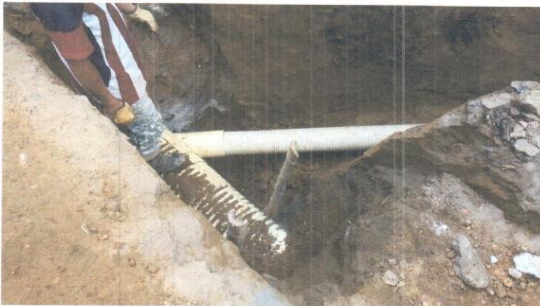
INSTALACION DE DOMICILIARIAS A RED PRINCIPAL.
