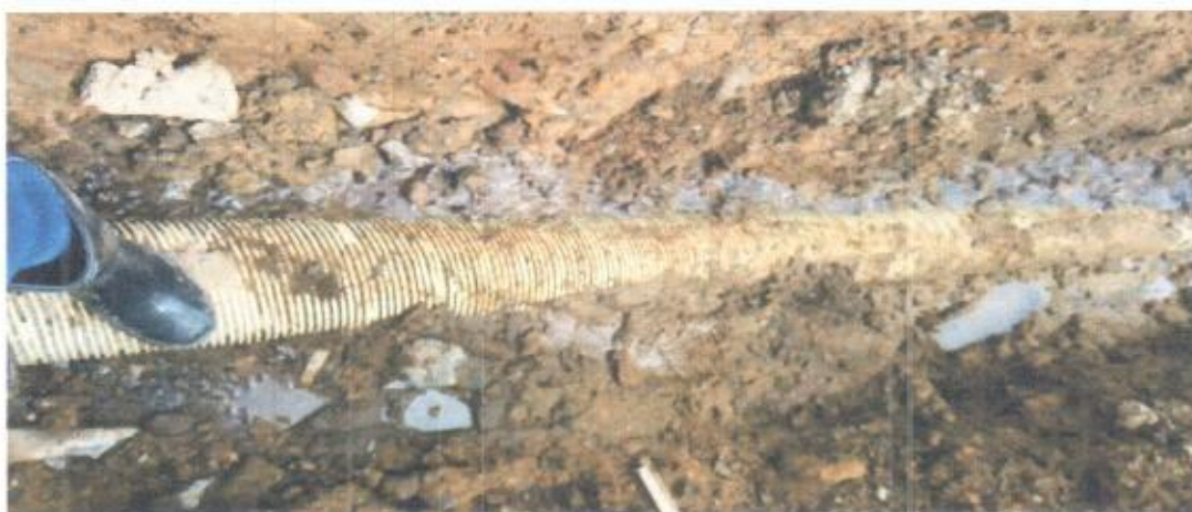
Foto 7 cama de arena e instalación de nueva tubería
