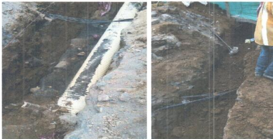
Foto 10 instalación de domiciliarias, llenos del sitio.
