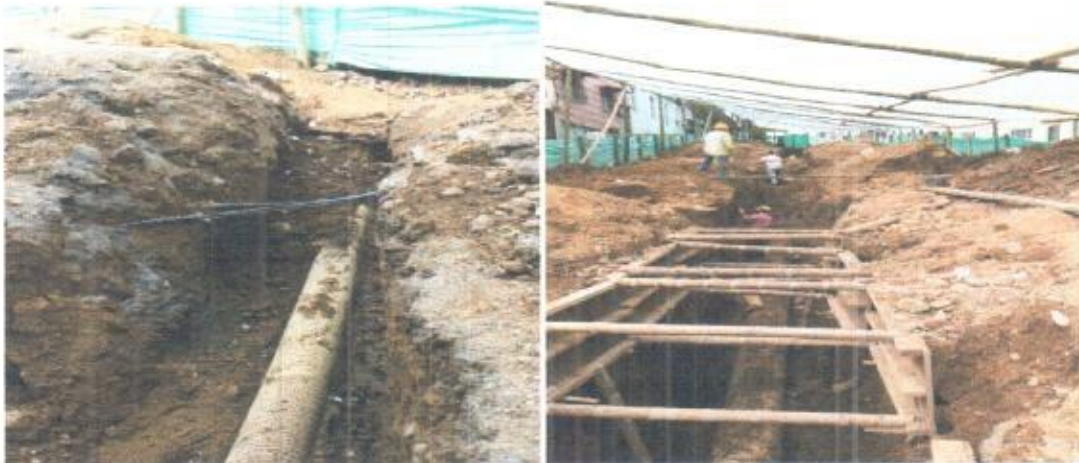
Foto 3. excavacion tubería principal y entibado
