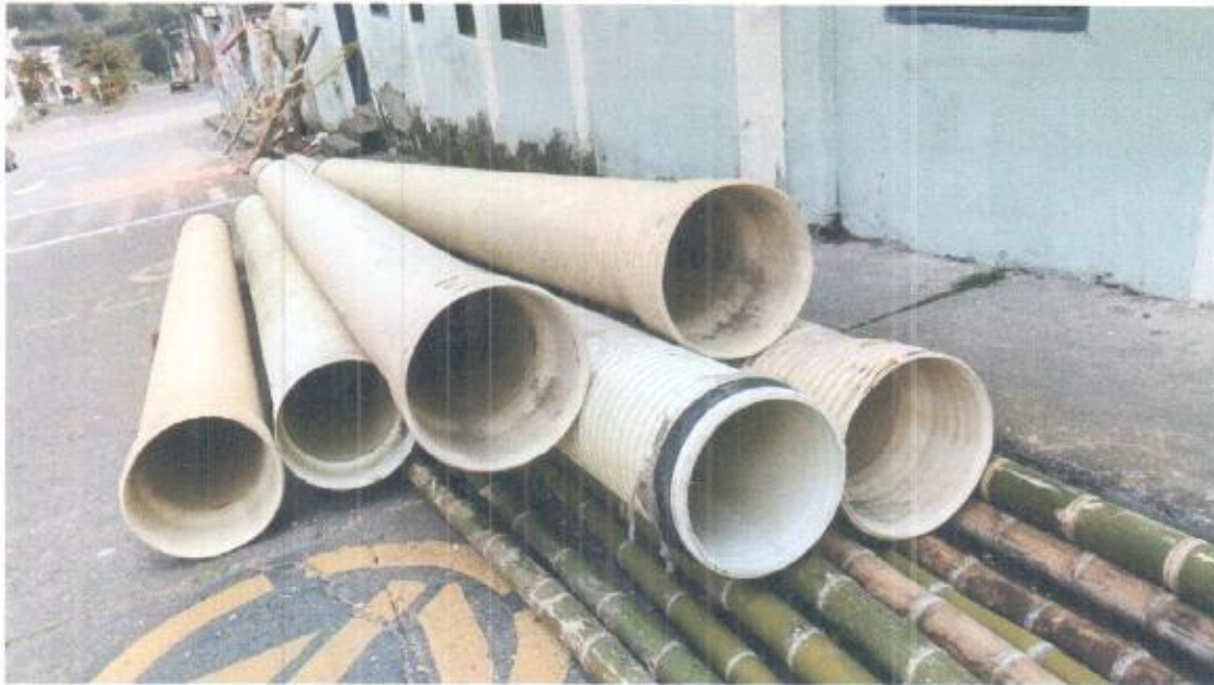
TUBERIA SUMINISTRADA POR EMPOCALDAS
