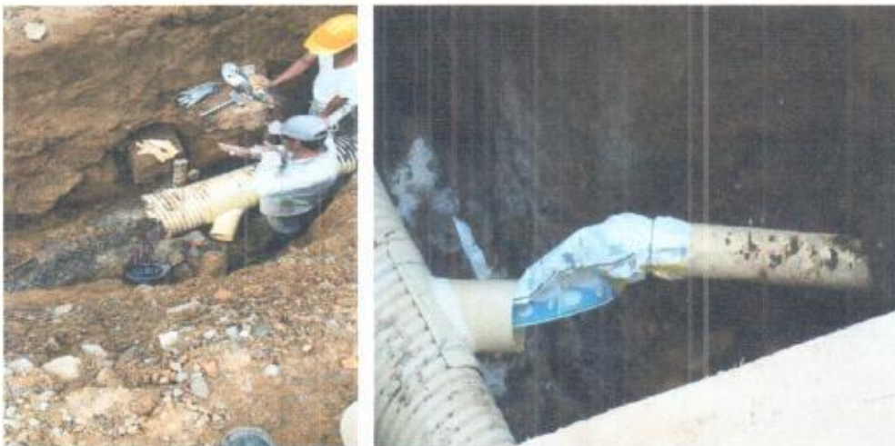
Foto 15 instalación de domiciliarias
