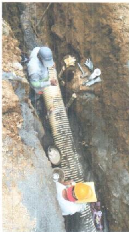
Foto 7 cama de arena e instalación de nueva tubería
