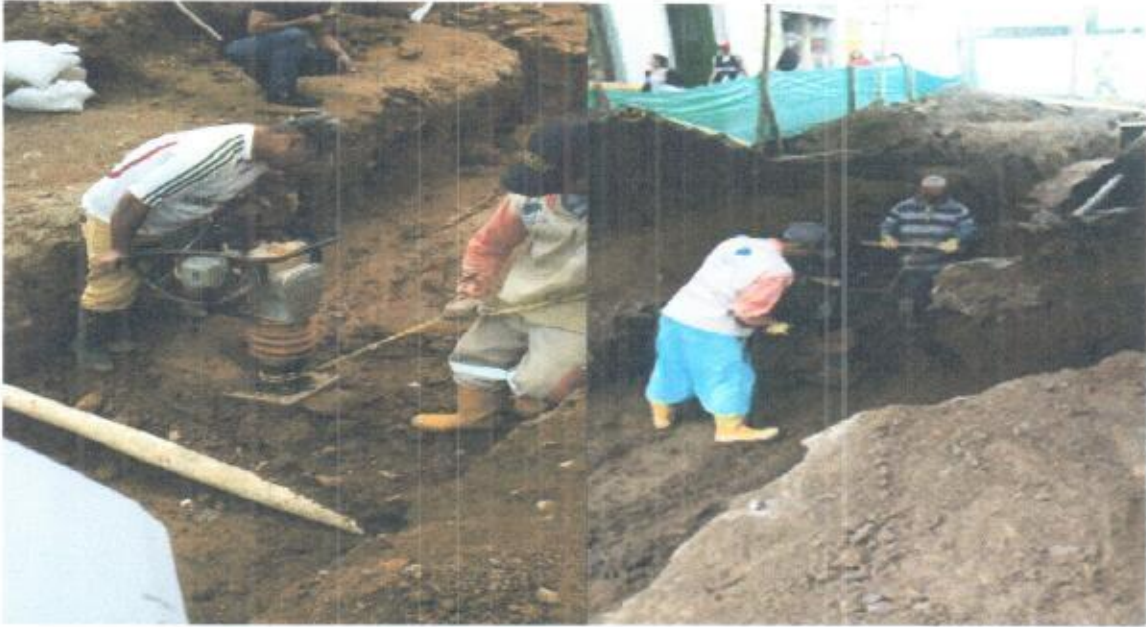
LLENOS CON MATERIAL DEL SITIO Y COMPACTACIÓN.
