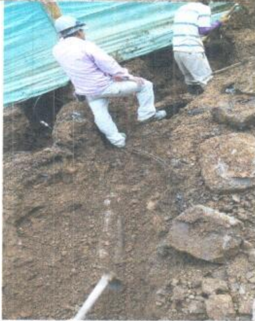
SE ENCUENTRAN DOMICILIARIAS CON MAS DE UNA TUBERIA ANEXA.
