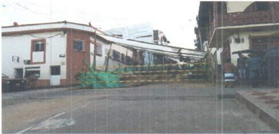
SEÑALIZACION DE LA OBRA.
