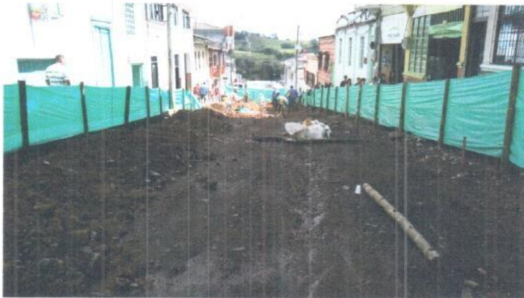
VERIFICACION DE EJE DE TUBERIA.
