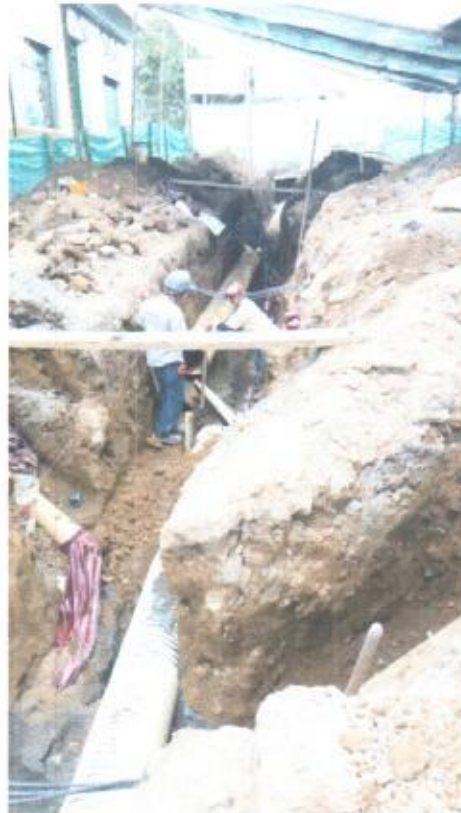
Foto 13 instalación de tubería ,cámara hacia arriba.
