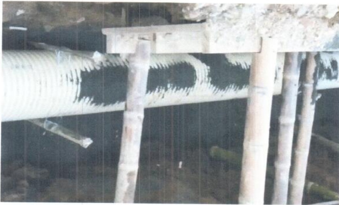
INSTALACION DE LA TUBERIA ,CON CAMA DE ARENA.
