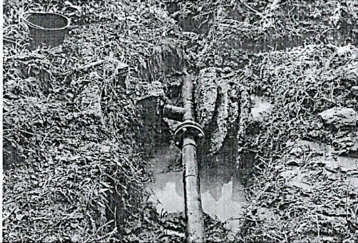
Imagen 1. UNION DE REPARACION TUBERÍA DE 3" – CONEXIÓN A POLIETILENO
