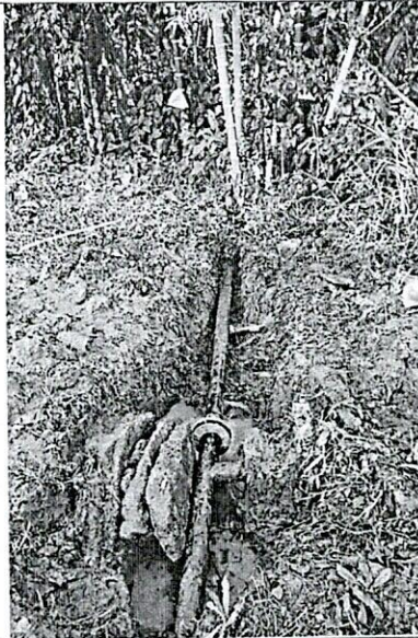
Imagen 3. Longitud del tramo reparado
