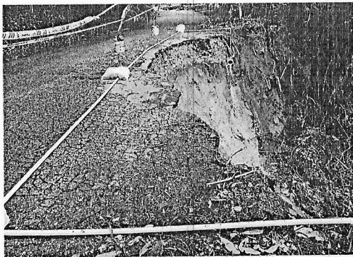
Fotos 1 y 2: Deslizamiento sobre la vía de acceso a Victoria, con afectación del interceptor PTAR y la conducción de acueducto.
