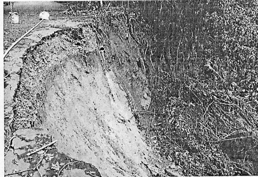
Fotos 1 y 2: Deslizamiento sobre la vía de acceso a Victoria, con afectación del interceptor PTAR y la conducción de acueducto.
