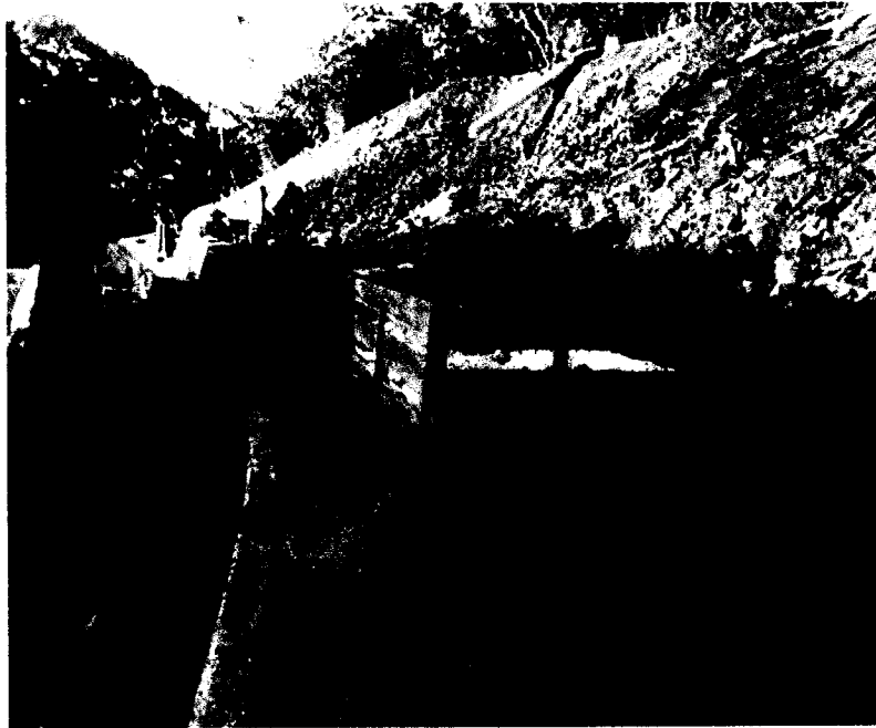
Construcción de gaviones en saco suelo cemento y recubrimiento en concreto de los mismos
