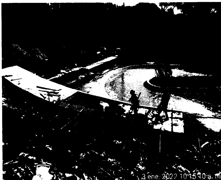
Construcción de gaviones en saco suelo cemento y recubrimiento en concreto de los mismos
