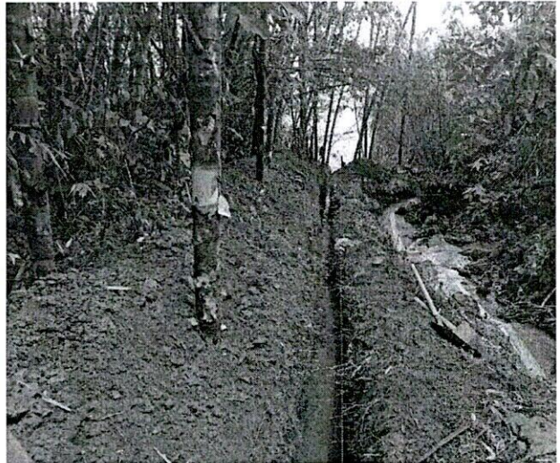
EXCAVACION EN ZANJA
