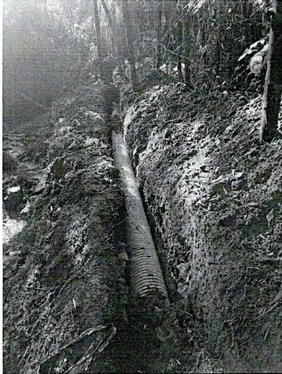
INSTALACION TUBERIA CORRUGADA DE 12" Y LLENO
