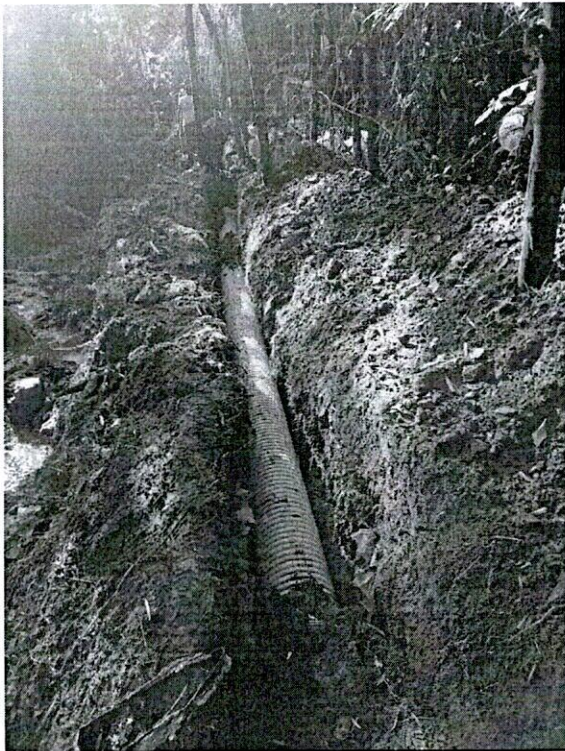
INSTALACION TUBERIA CORRUGADA DE 12" Y LLENO
