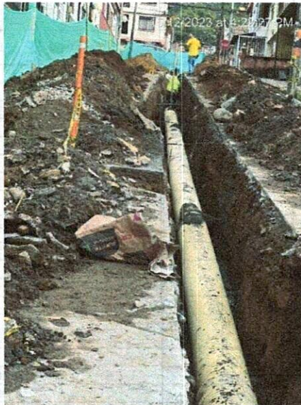
Fotografías No. 1, 2 Y 3 Excavaciones e instalación de tubería de 16"
