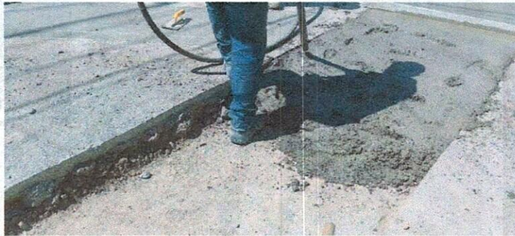
Fotografía No. 13 vibrado de pavimento
