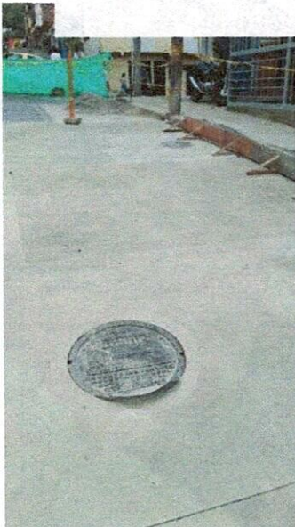
Fotografías No. 14,15 y 16 tapa de cámara de inspección terminada, vaciado de pavimento, base y cañuela cámara de inspección
