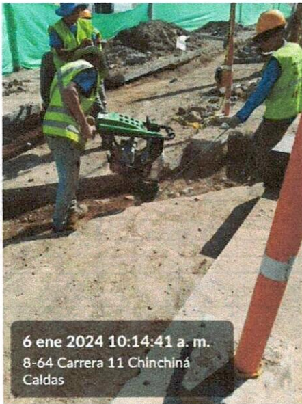
Fotografías No. 4, 5 Y 6 Llenos compactados mecánicamente, cámaras de inspección y retiros
