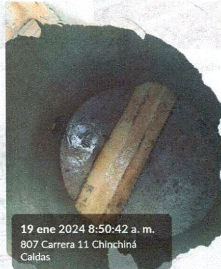
Fotografías No. 14,15 y 16 tapa de cámara de inspección terminada, vaciado de pavimento, base y cañuela cámara de inspección
