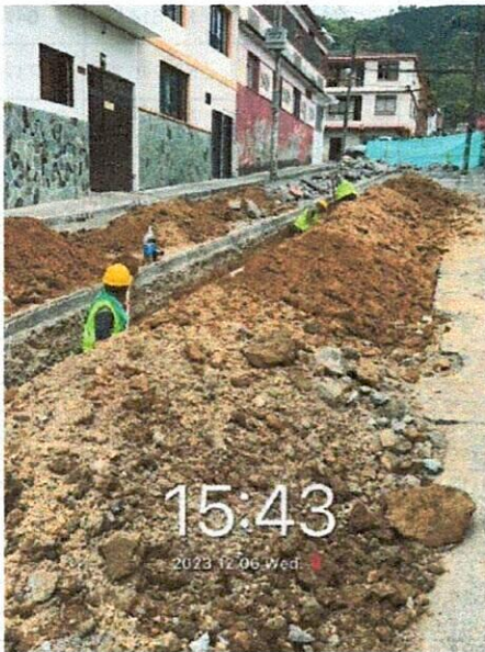
Fotografías No. 1, 2 Y 3 Excavaciones e instalación de tubería de 16"
