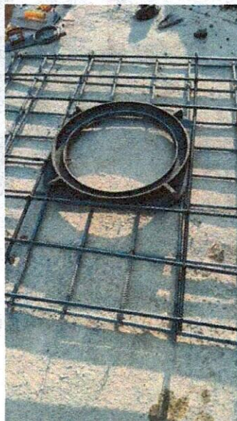
Fotografías No. 10, 11 Y 12 Toma de densidades de campo, refuerzo de cámaras de inspección, terminados de pavimento.
