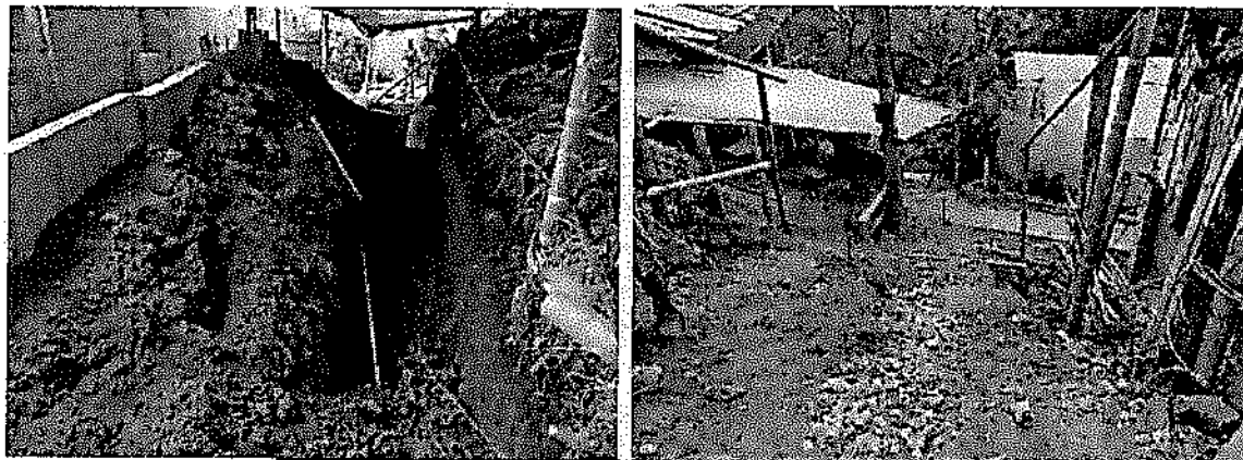
UTILIZACIÓN DE TABLEROS PARA CONTROL DEL MATERIAL DE EXCAVACIÓN
