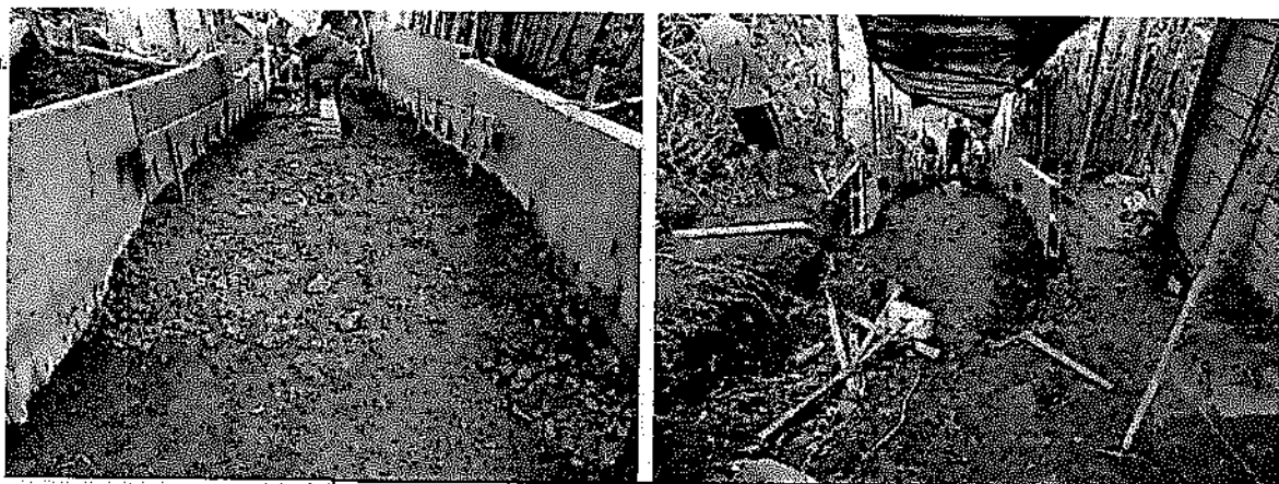
PROCESO CONSTRUCTIVO ESCALERAS
