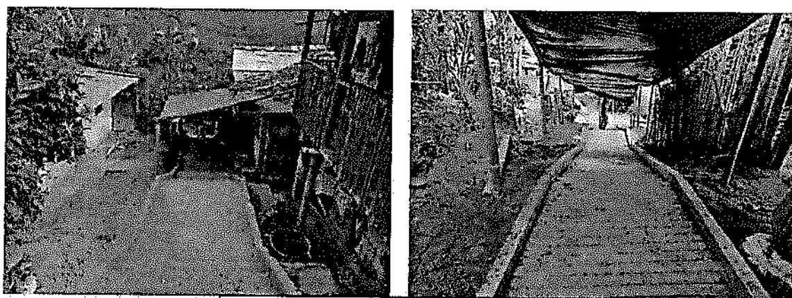
RECONSTRUCCIÓN DE ESCALERAS
