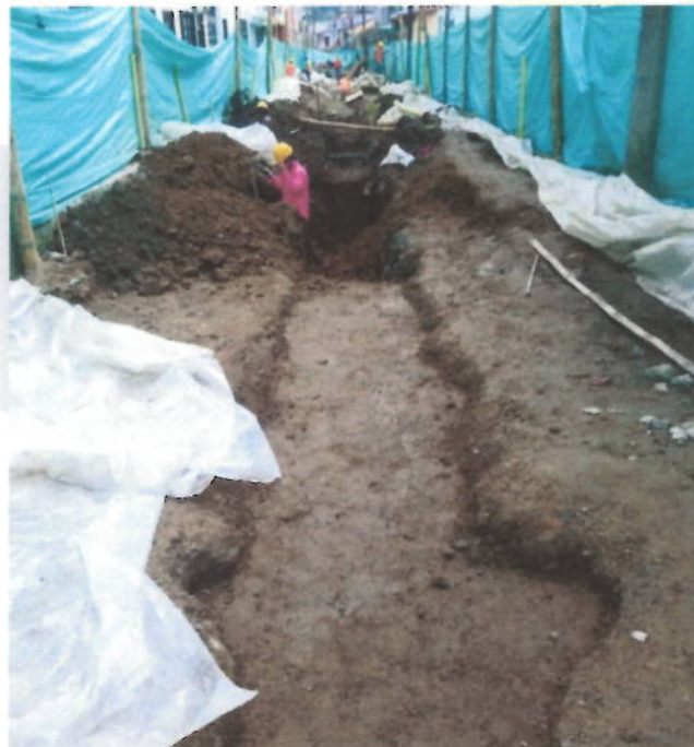
Instalación y llenos de la tubería
