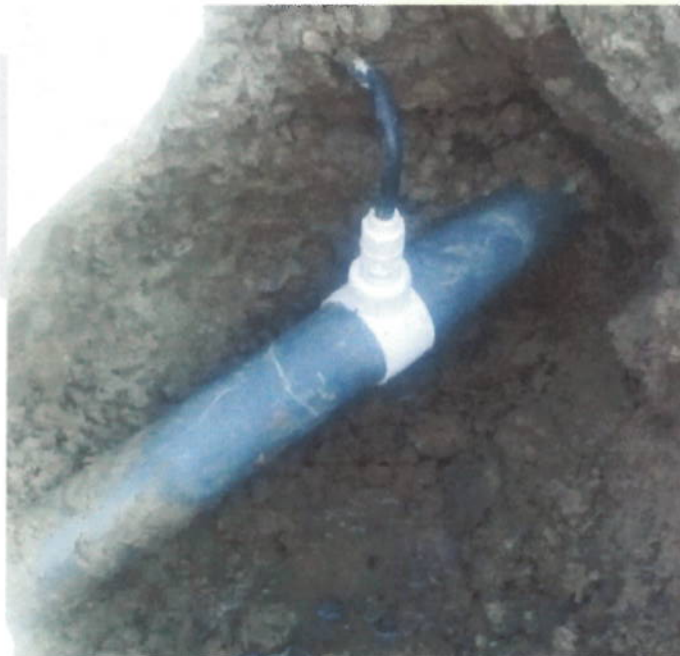
Instalación de Collarines domiciliarias
