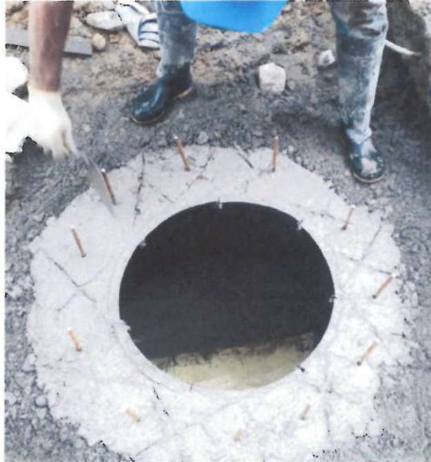
Cámaras de Inspección D= 1.20 -Concreto 21 Mpa
