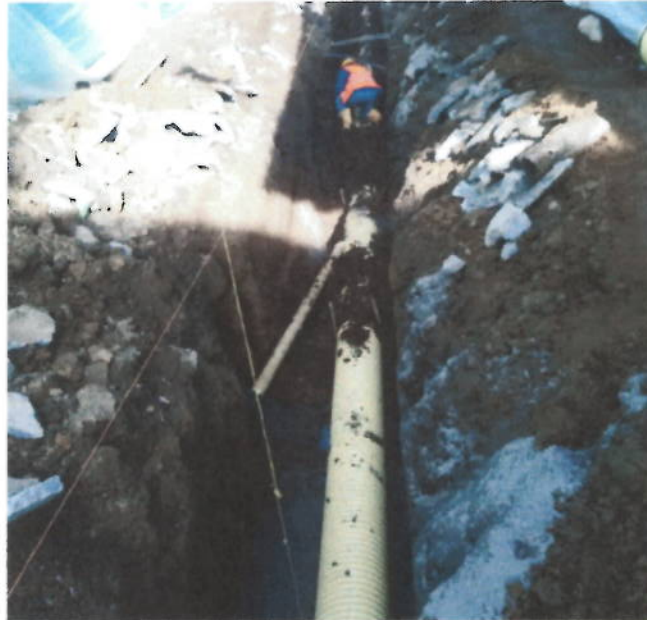
Instalación y llenos de la tubería
