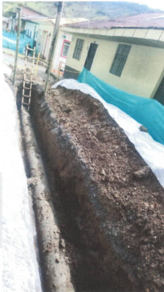
Excavaciones para tubería
