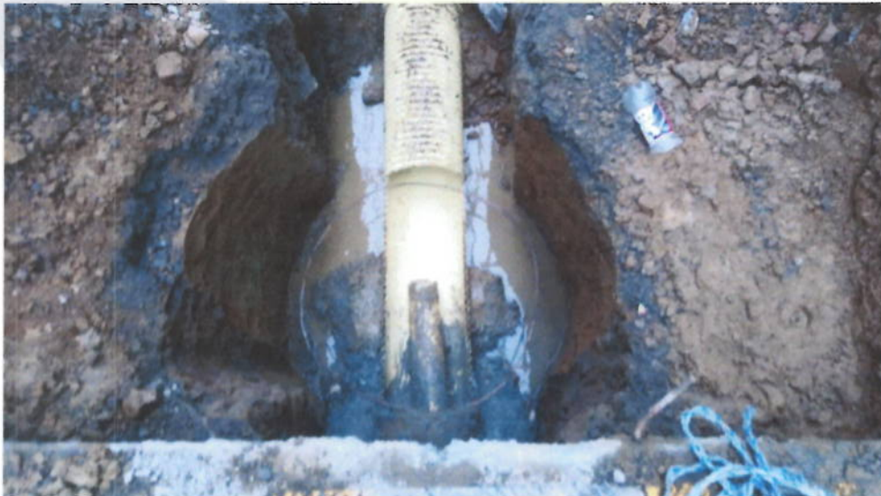
Sustitución en arena limpia para tuberías
