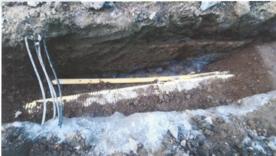
Lleno para tubería Principal
