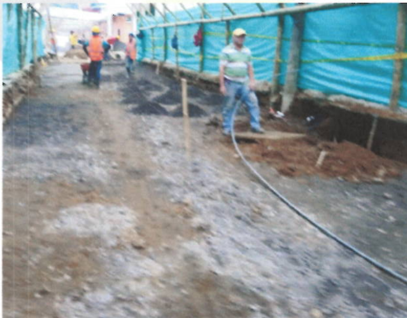
Rellenos compactos con material común de cantera préstamo
