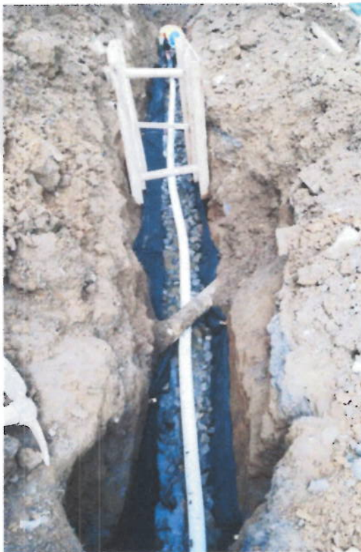
Suministro e instalación de filtros para manejo de aguas subterráneas
