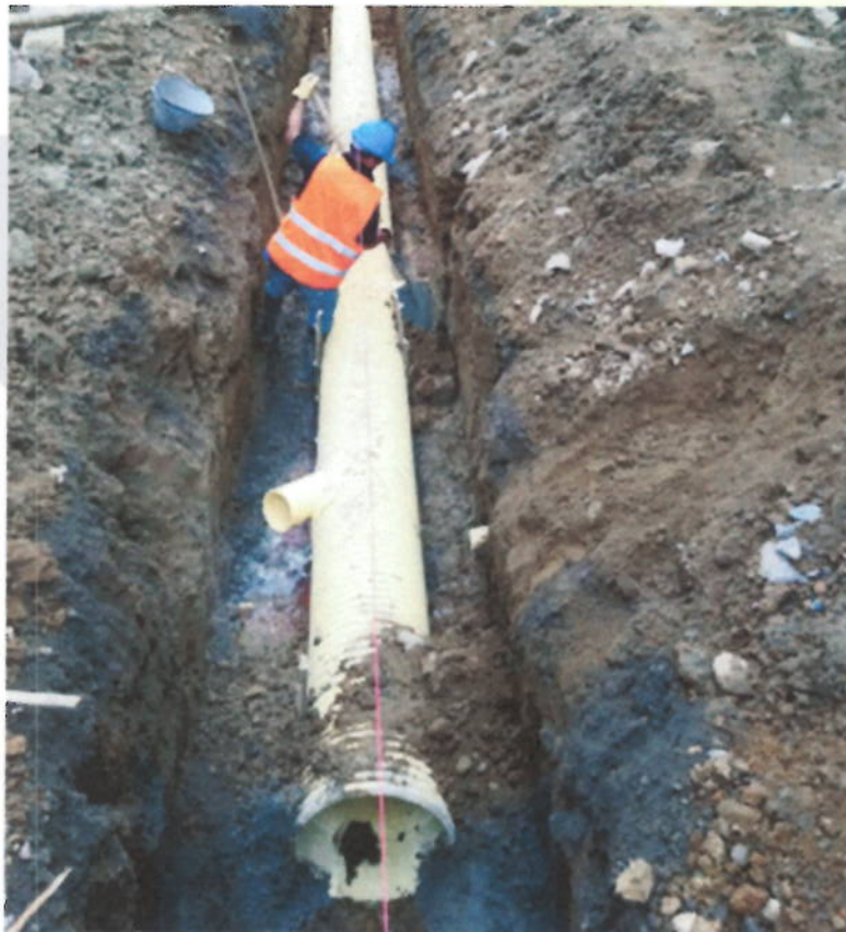
Instalacion de silla yee de 12 x 6", 10 x 6", 18 x 6"
