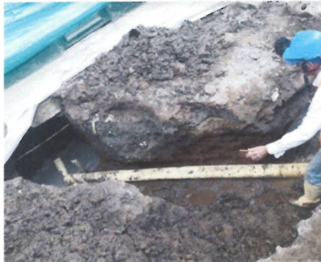
Empalmes a cajas de inspección
