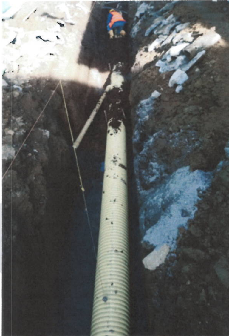
Sustitución en arena limpia para tuberías
