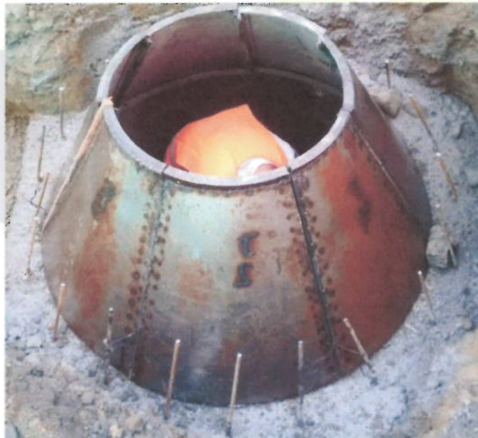
Cámaras de inspección D=1.20 m en concreto 21 Mpa
