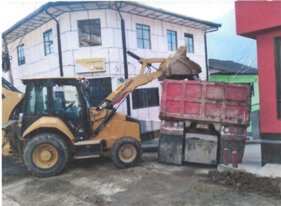
Retiro de sobrantes en vehículo automotor
