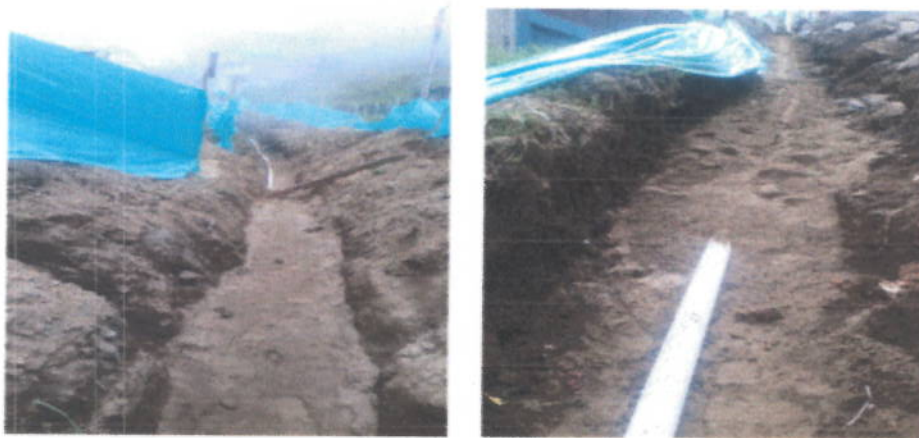
CAMA DE ARENA CUBRIENDO COMPLETAMENTE LA TUBERIA
