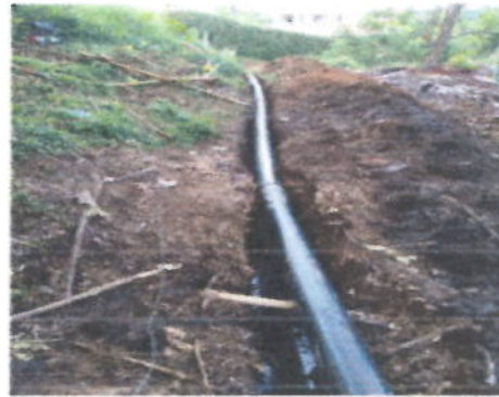
TERMOFUSION DE TUBERIA DE 8" POLIETILENO PN16
