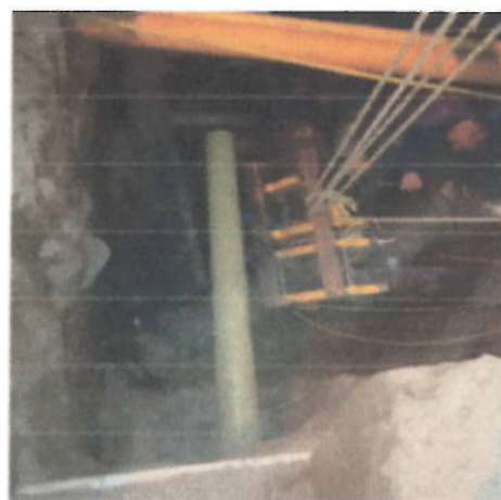
TERMOFUSIONES DE CODOS, ANCLAJES Y TUBOS INSTALADOS BAJO LA VIA NACIONAL CON EL SISTEMA DE PERFORACION HORIZONTAL DIRIGIDA
