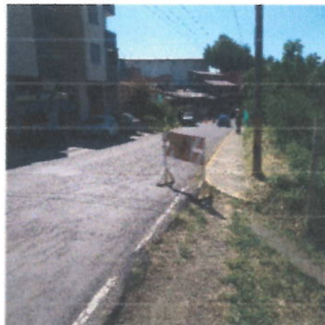
SEÑALIZACION EN OBRA
