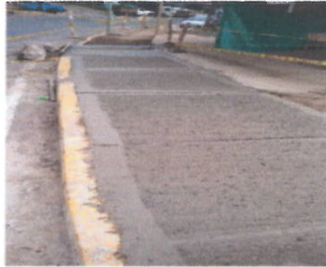
RECUPERACION DE ANDENES
