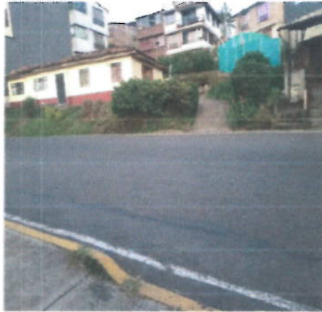
ESTADO INICIAL DE LA VIA
