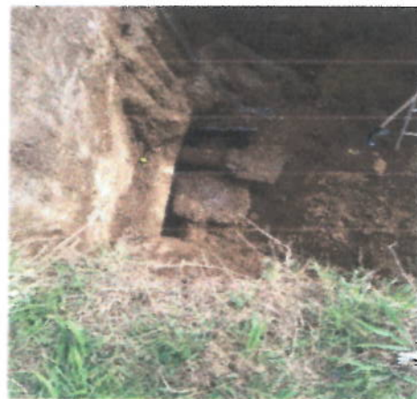
EXCAVACION REALIZADA CON RETROEXCAVADORA PARA CAMBIO DE VALVULAS
