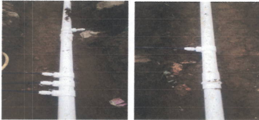
INSTALACION DE ACOMETIDAS DE \frac{1}{2} EN PF CON COLLARIN DE 3 * \frac{1}{2} "
