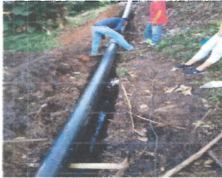
TERMOFUSION DE TUBERIA DE 8" POLIETILENO PN16
