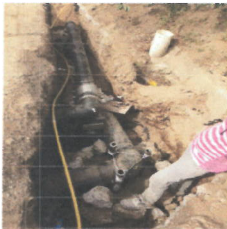
TERMOFUSIONES DE CODOS, ANCLAJES Y TUBOS INSTALADOS BAJO LA VIA NACIONAL CON EL SISTEMA DE PERFORACION HORIZONTAL DIRIGIDA
