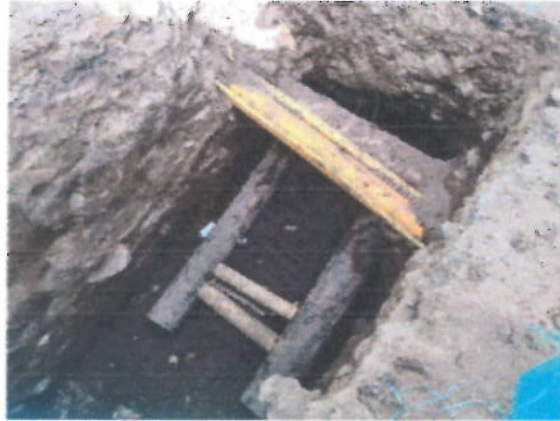
CRUCE DE TUBERIA DE 8" Y 10" DE POLIETILENO – CRUCE YA REALIZADO
