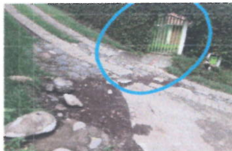
ESTADO INICIAL DE LA VIA
