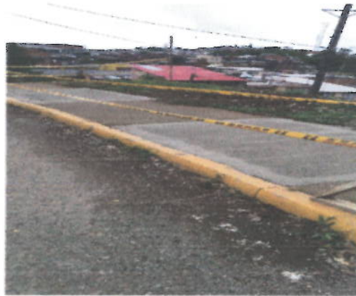
RECUPERACION DE TRAMOS DE ANEDEN DONDE SE REALIZARON LOS APIQUES PARA BUSCAR TUBERIAS
