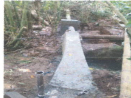
ANCLAJE REALIZADOS CON TUBERIA GALVANIZADA
