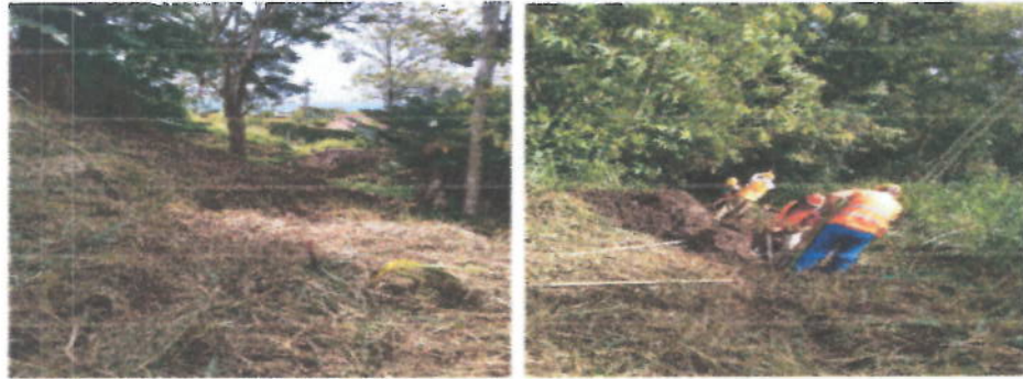
ROCERIA Y EXCAVACION
