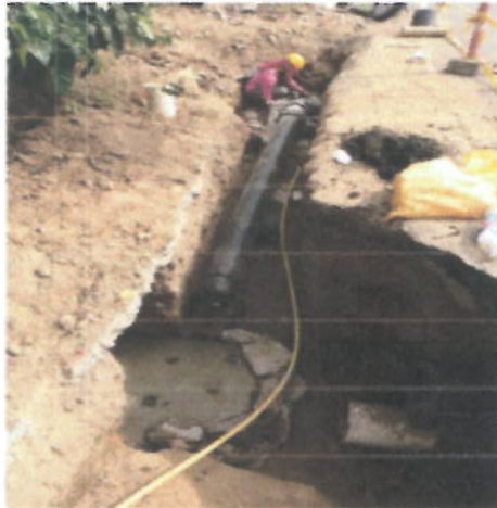
TUBERIA PF TERMOFUNDIDA DE 8"
