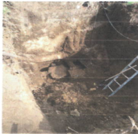
EXCAVACION REALIZADA CON RETROEXCAVADORA PARA CAMBIO DE VALVULAS
