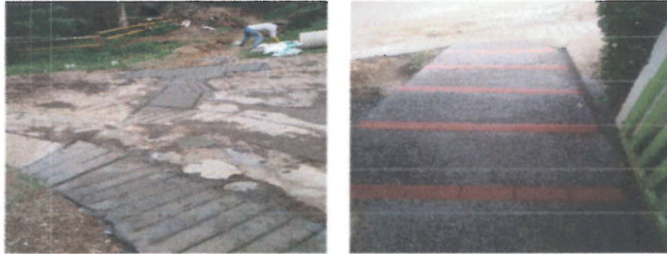
RECUPERACION DE ZONAS DURAS
