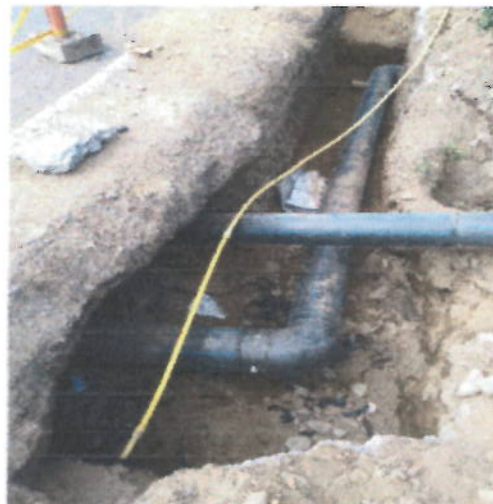
TERMOFUSION DE ACCESORIOS Y EMPALMES REALIZADOS
