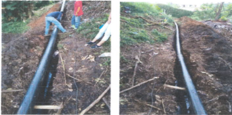
TERMOFUSION Y TRANSPORTE DE LA TUBERIA DE POLIETILENO EN TODA SU LONGITUD
