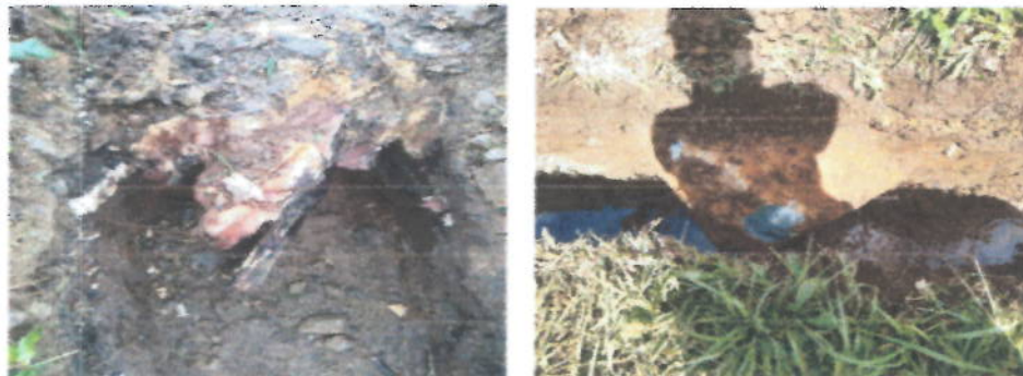
RAICESY ROCAS ENCONTRADAS EN LA EXCAVACION
