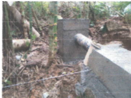
ANCLAJE REALIZADOS CON TUBERIA GALVANIZADA
