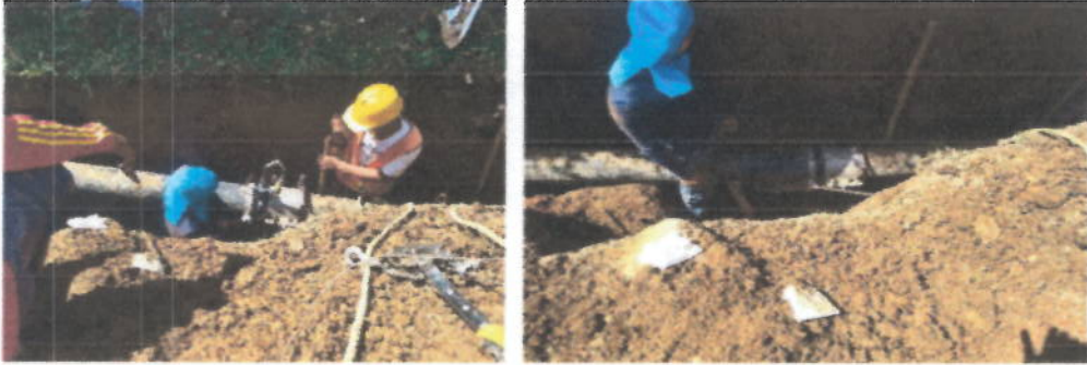
TERMOFUSION TUBERIA 8" DE POLIETILENO – EMPALME
