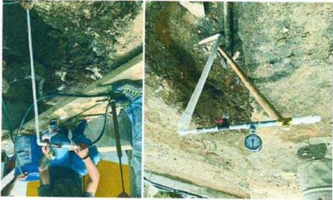
Ilustración 1. Instalación inicial. Ilustración 2. Instalación inicial.
