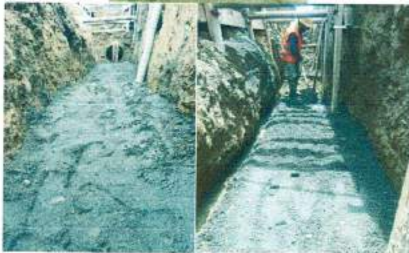
Instalación de cama en arena para proceder con la colocación de tubería principal de 20" como reposición de la red de alcantarillado.
