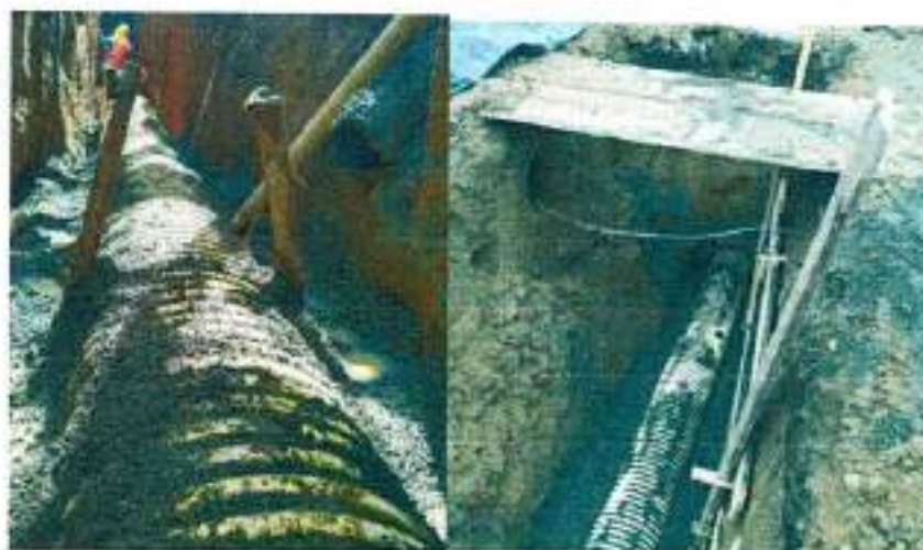
Instalación de cama en arena para proceder con la colocación de tubería principal de 20" como reposición de la red de alcantarillado.
