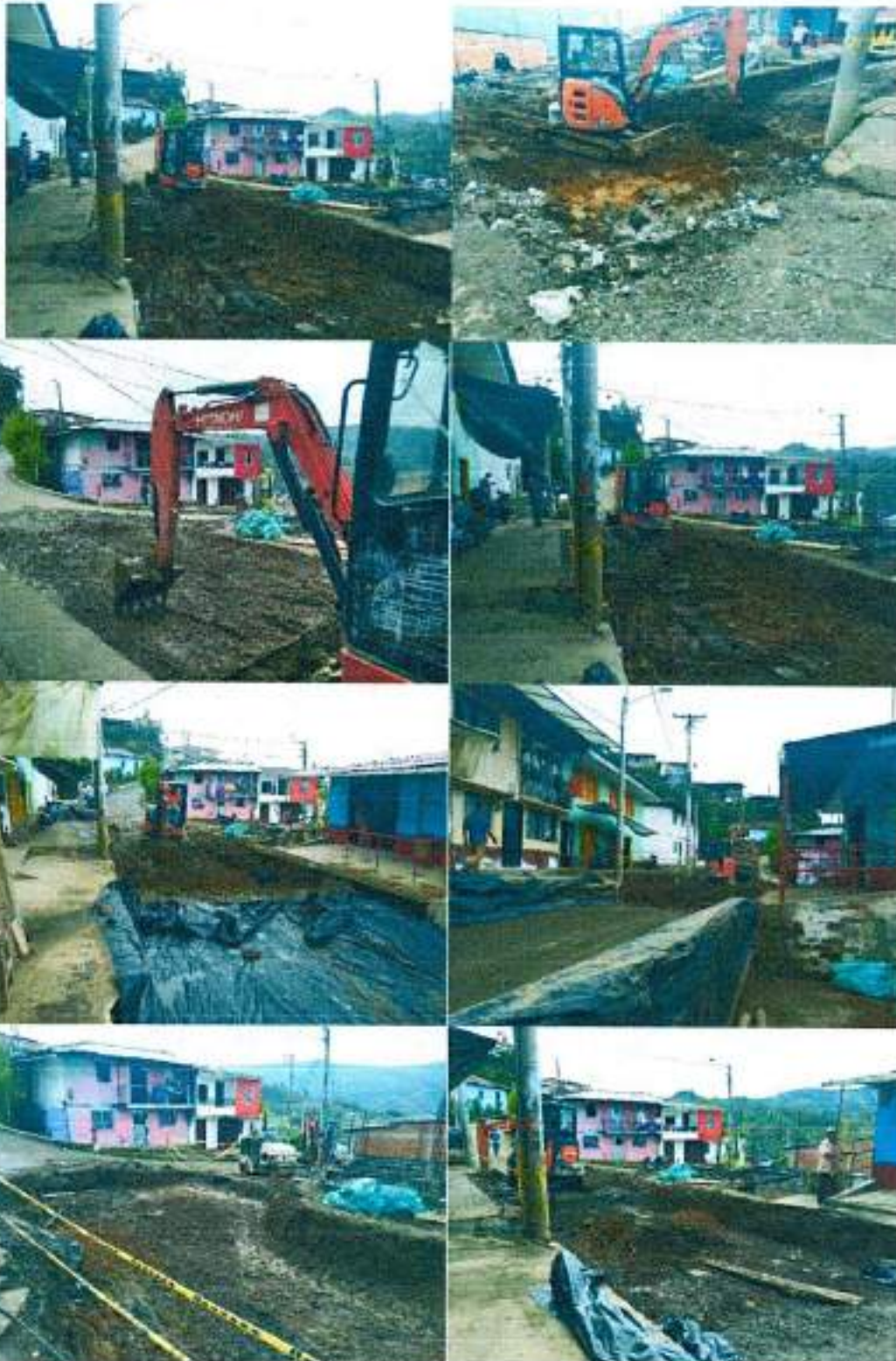
Excavación y movimiento de tierra, entre las abscisas K0+051 a K0+090, correspondiente al cajeo según la estructura de pavimento flexible y el mejoramiento del terreno en el tramo.
