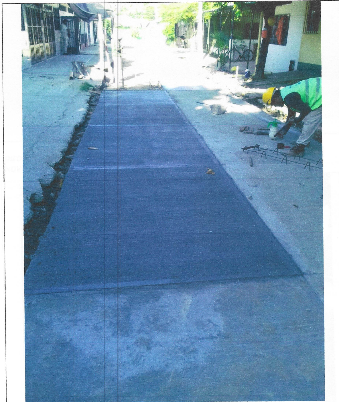
Imagen 6. Vista longitudinal pavimento de 3,5 metros de ancho.
