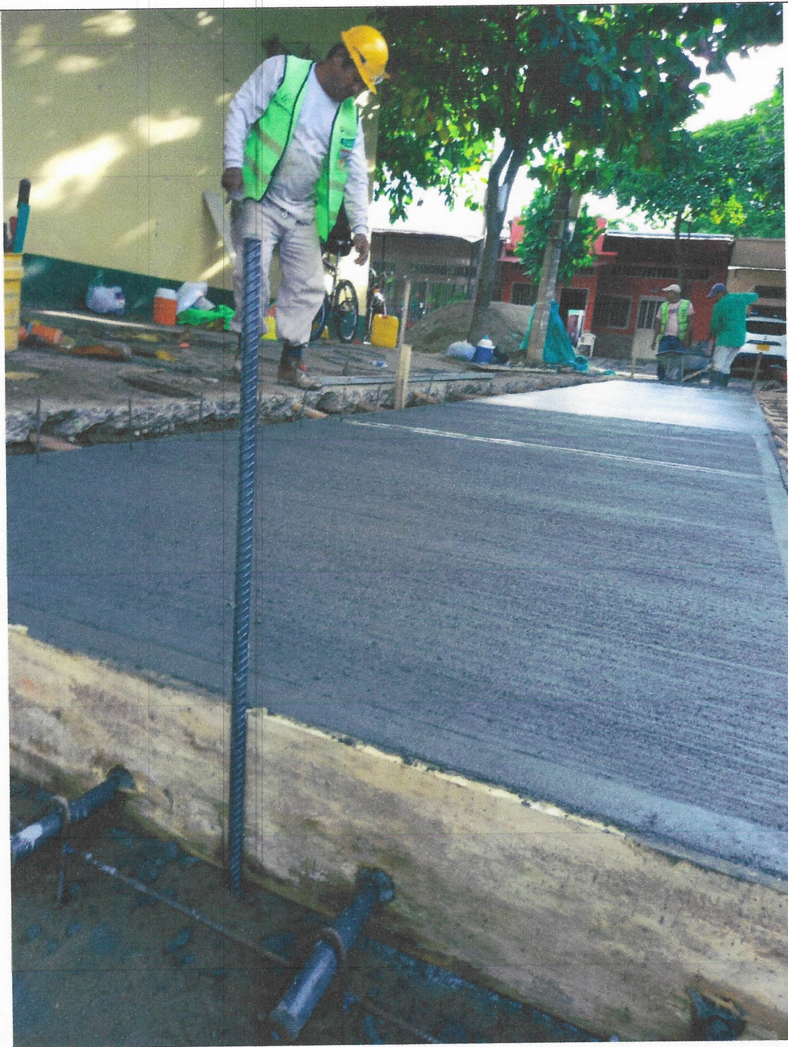
Imagen 3. Fundida de losas
