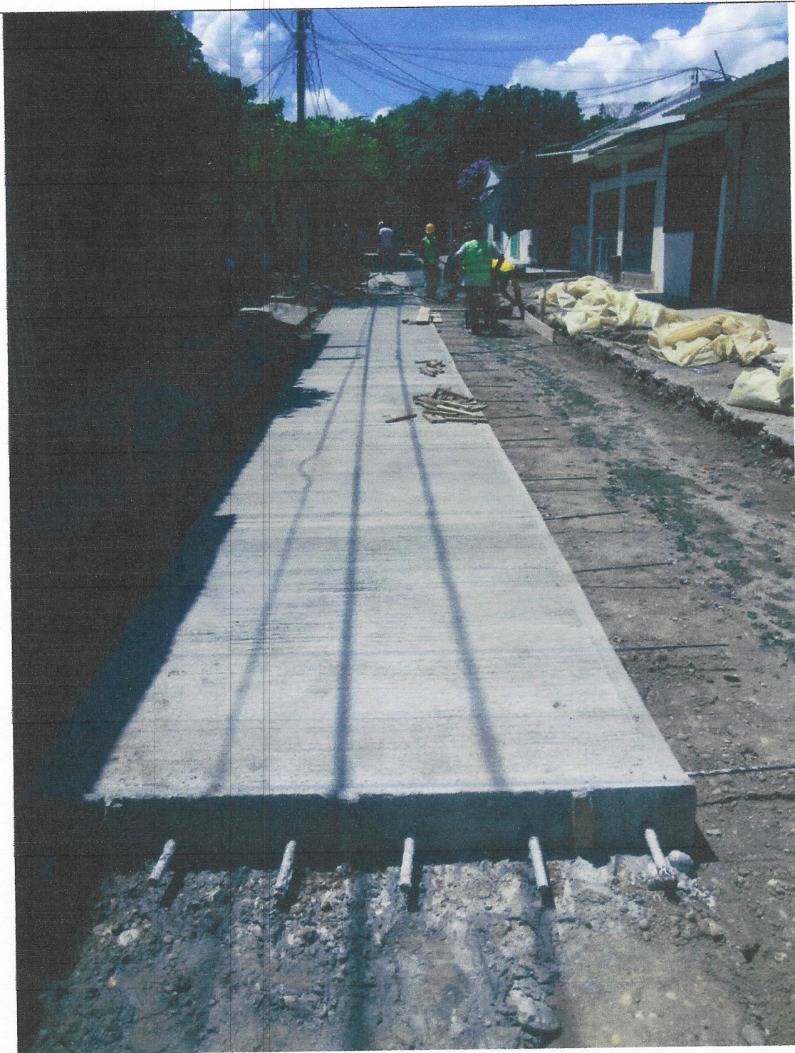
Imagen 5. Vista longitudinal pavimento, ancho de 1,75 metros.
