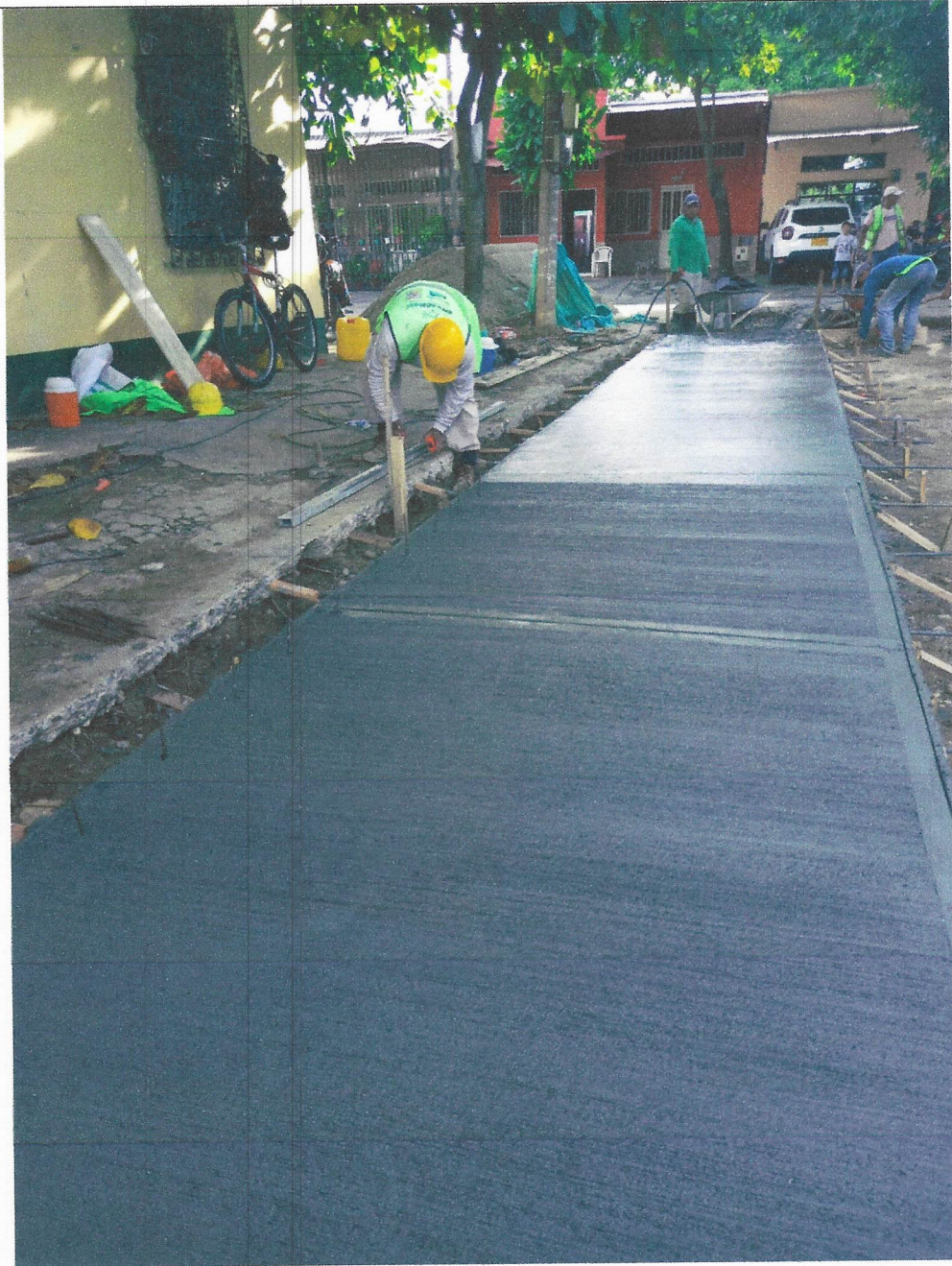
Imagen 2. Fundida de losas.
