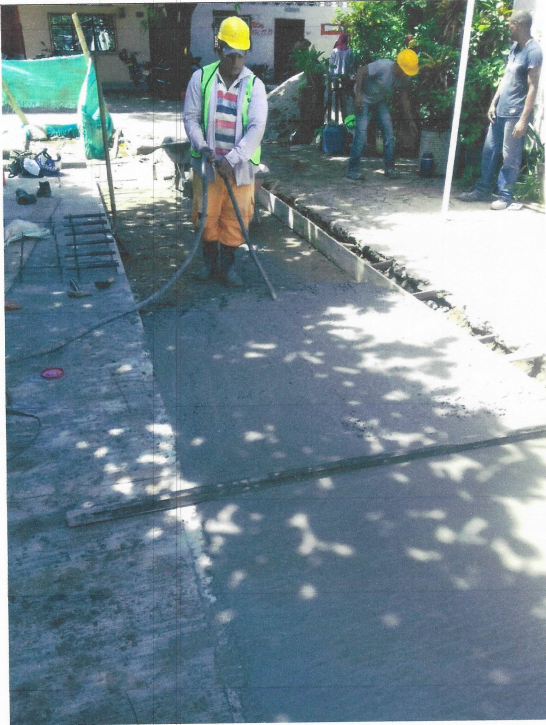
Imagen 4. Vibrado de concreto.
