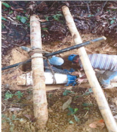
EMPALME A TUBERIA EXISTENTE Y ANCLAJE
