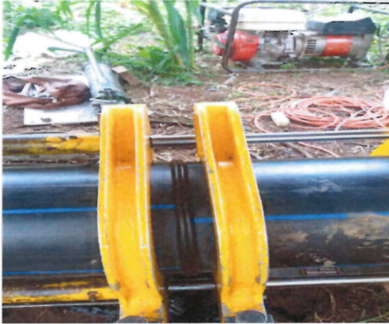
PROCESO DE TERMOFUSION TUBERIA
