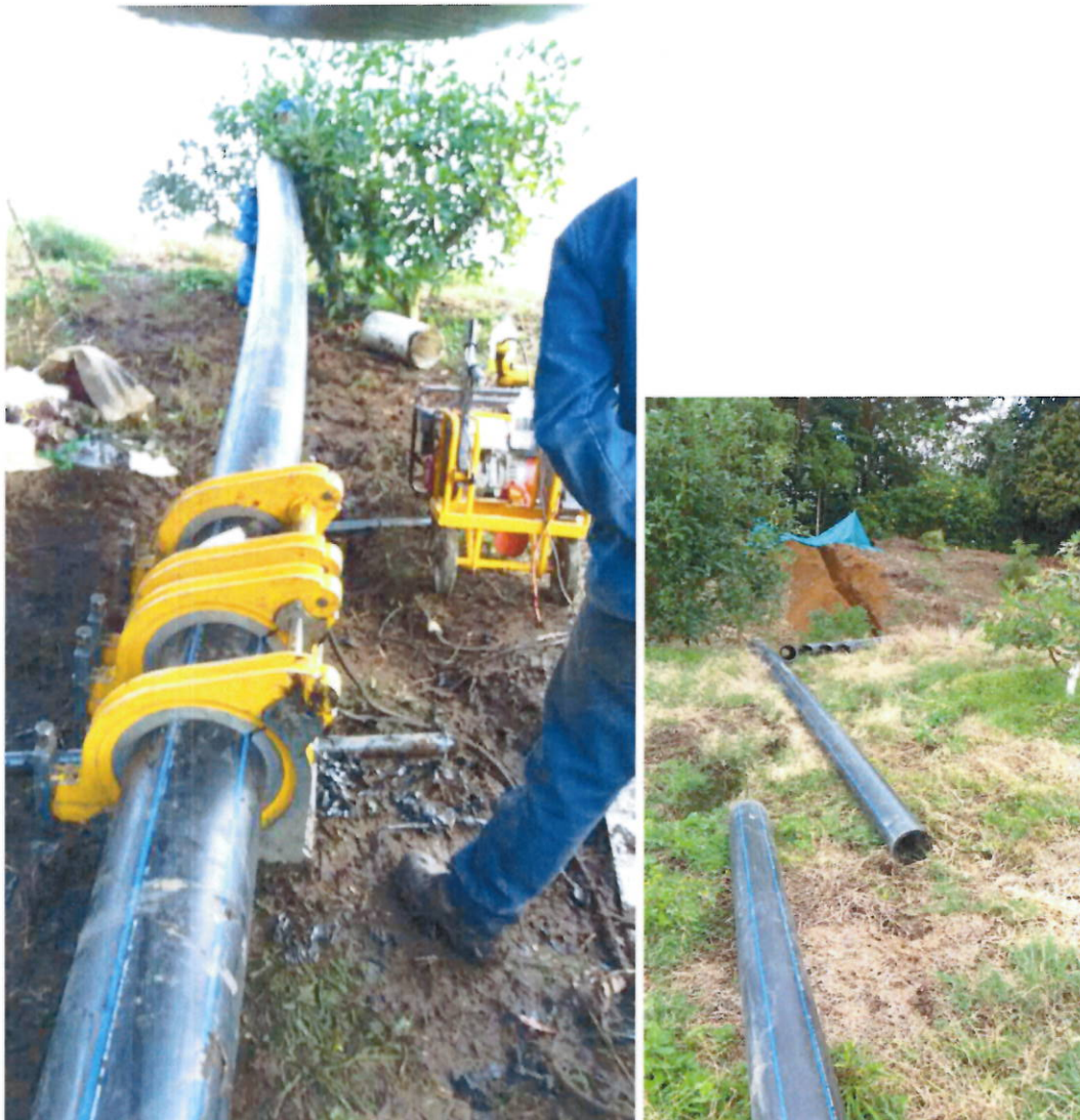
DISPOSICION Y COLOCACION TUBERIA POLIETILENO PARA SER TERMOFUNDIDA
