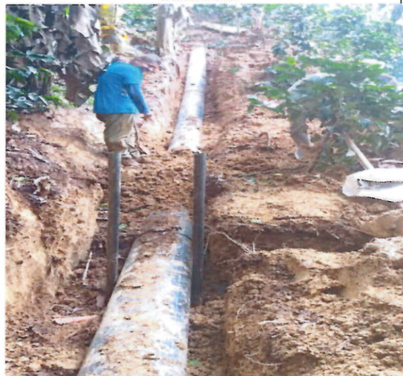
TUBERIA INSTALADA PROCESO LLENOS
