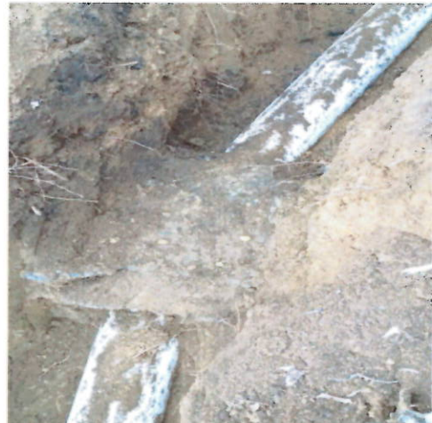
EXCAVACIONES Y ANCLAJES A DEM, OLER TUBERIA EXISTENTE
