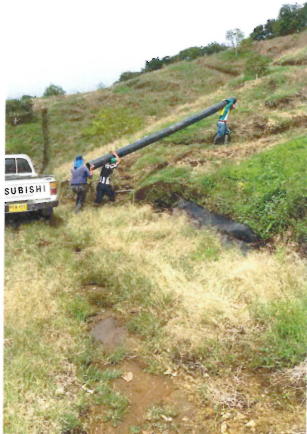
ACARREO DE TUBERIA AL HOMBRO FUERTE PENDIENTE
