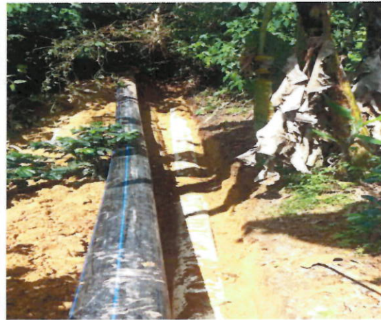
TUBERIA INSTALADA PROCESO LLENOS
