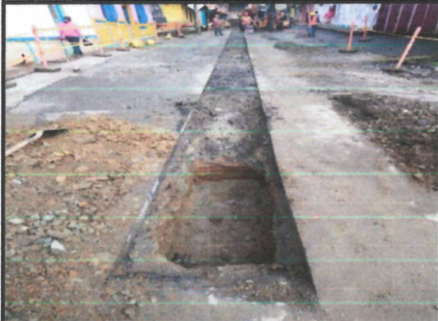
Descripción: Corte y demolición de Concreto Asfáltico
