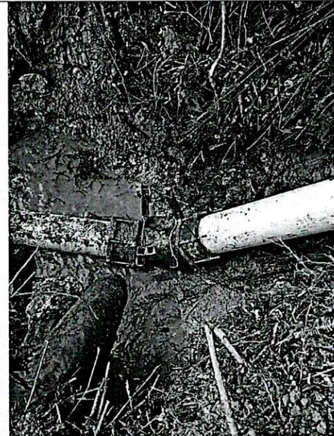
FOTO 8. Codo instalado y anclaje en tubería galvanizada y concreto.
