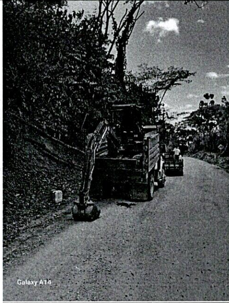
Foto 1: Arribo máquina para excavación en roca sector Peñas Azules
