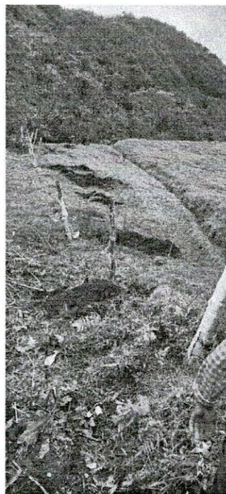
FOTO 6. Apiques para búsqueda de tubería"
