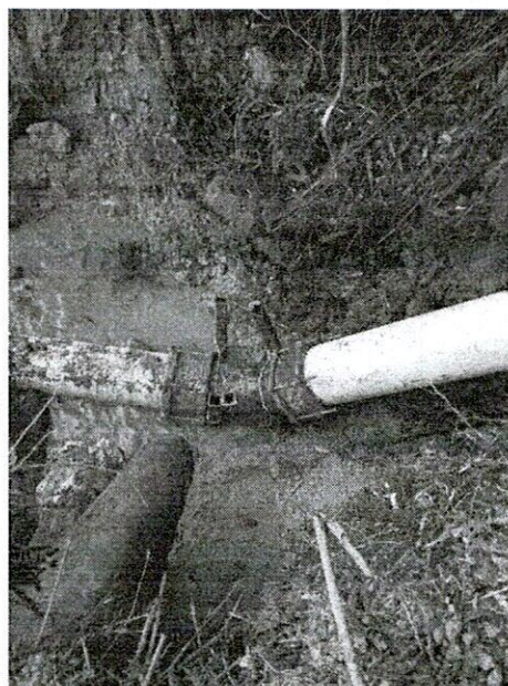
FOTO 10. Anclaje de accesorios.
