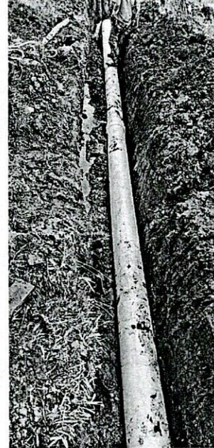
Foto 6: Instalación de tubería.
