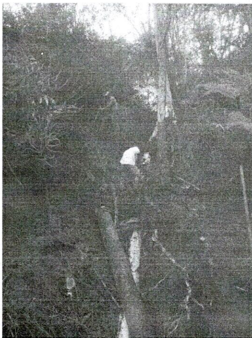
FOTO 5. Retiro de tubería vieja"
