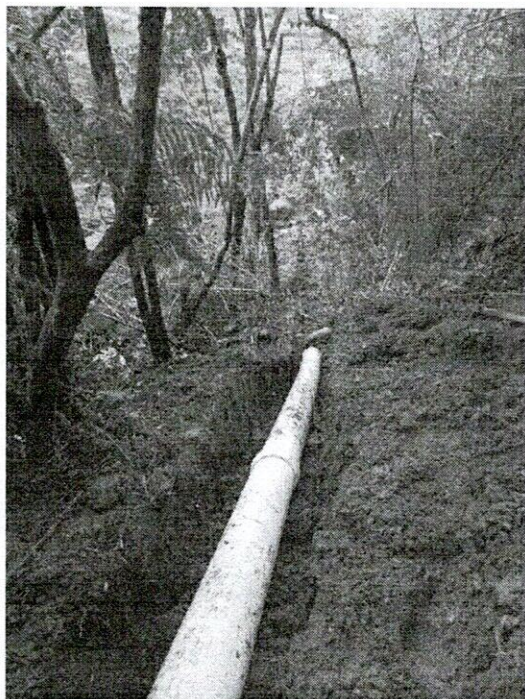
FOTO 7. Instalación de tubería.
