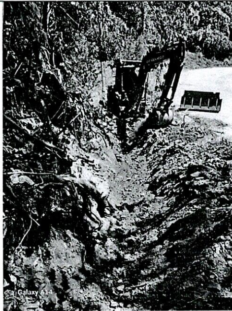
Foto 4: Excavación conglomerado tramo ladera hacia vía Peñas Azules
