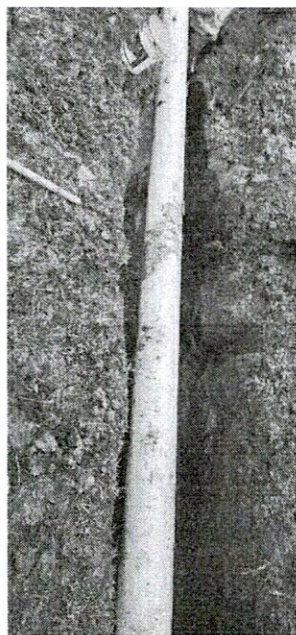
FOTO 3. Instalación de tubería.
