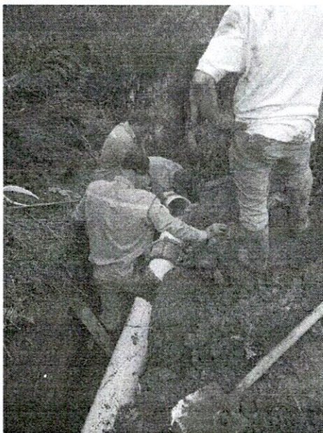
FOTO 9. Empalme a tubería nueva.
