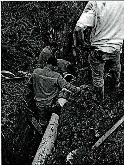
FOTO 7. Empalme con apoyo de funcionarios de la seccional Aguadas y Arma
