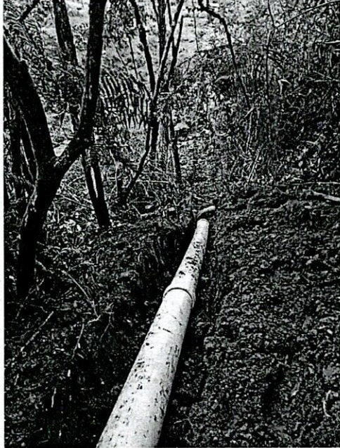
Foto 5: Instalación de tubería.
