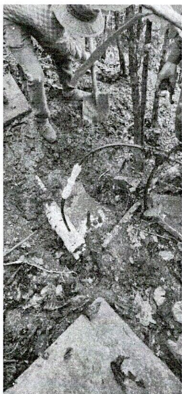
FOTO 17. Instalación de acometida.
