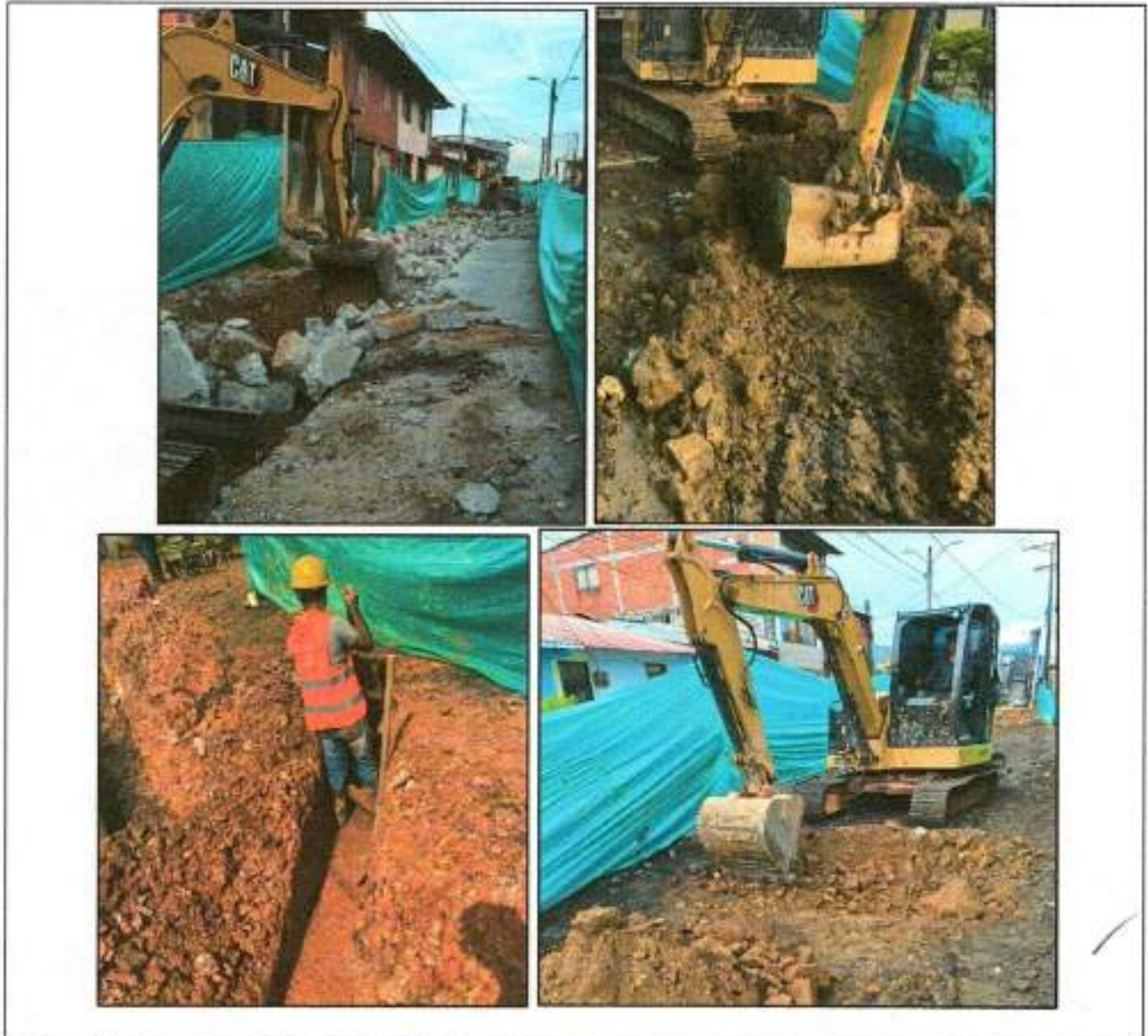
4.1. Rellenos compactos con material seleccionado de excavación
