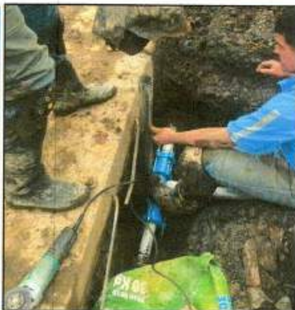
INP-03. Suministro, transporte e Instalacion tuberia PVC RD21 de 2"
