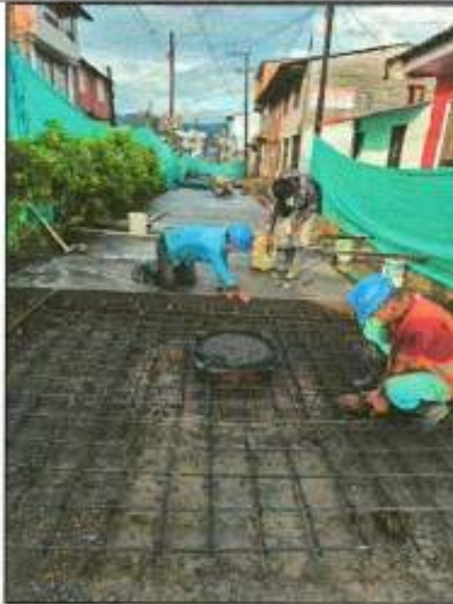
6.4. Base/ cañuela camara D=1.20 m en concreto 3000 psi
