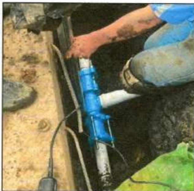
INP-03. Suministro, transporte e Instalacion tuberia PVC RD21 de 2"
