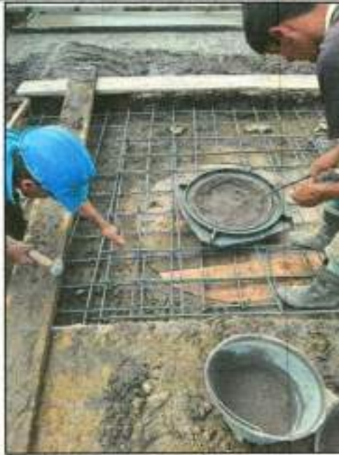
6.4. Base/ cañuela cámara D=1.20 m en concreto 3000 psi
