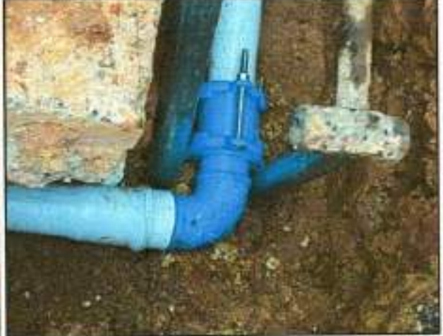
INP-03. Suministro, transporte e Instalacion tubería PVC RD21 de 2"
