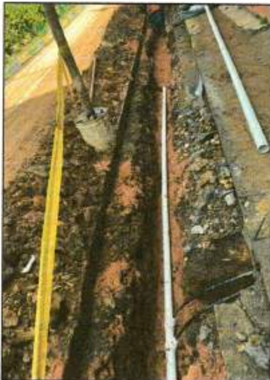
INP-03. Instalacion de hidrante (Tipo milan 3" extremo brida)
