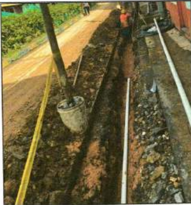
INP-03. Suministro, transporte e Instalacion tubería PVC RD21 de 2"
