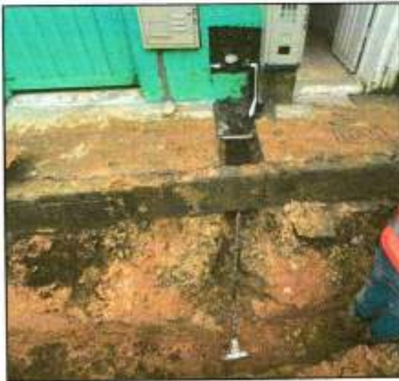
7.4. Suministro, transporte e Instalacion tubería pvc RD21 de 3"
