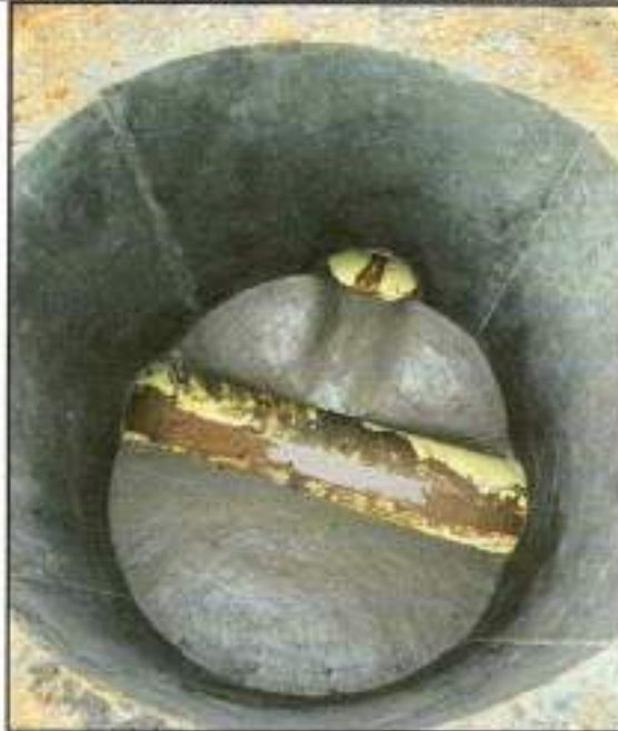
6.4. Base/ cañuela camara D=1.20 m en concreto 3000 psi
