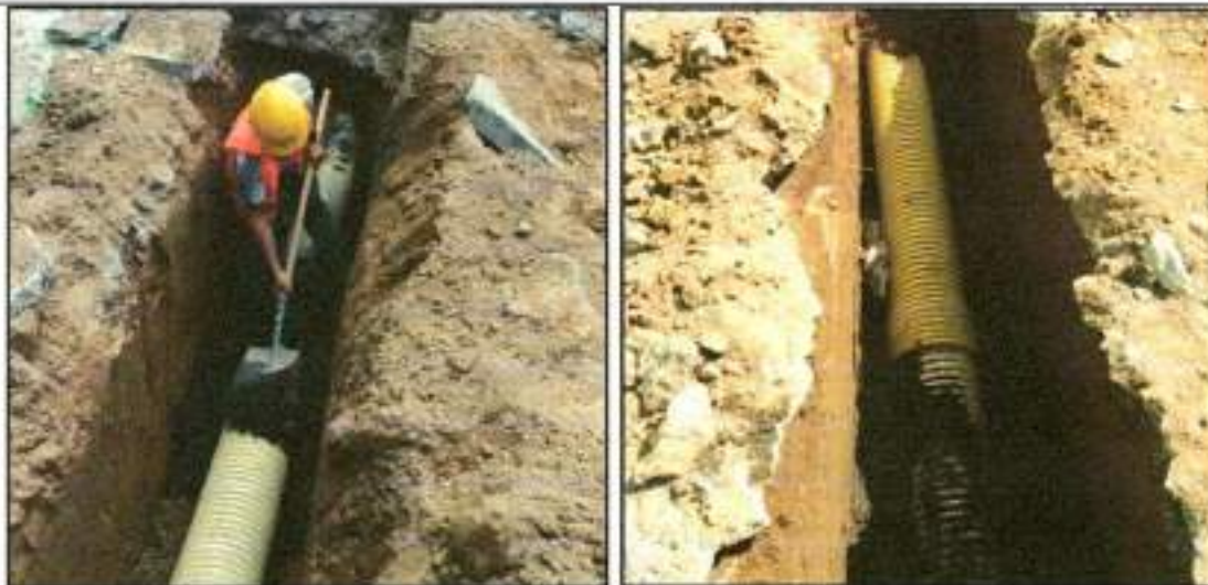
6.1. Suministro, Transporte e instalación de tubería PVC corrugada \Phi=160 mm (6") para alcantarillado
