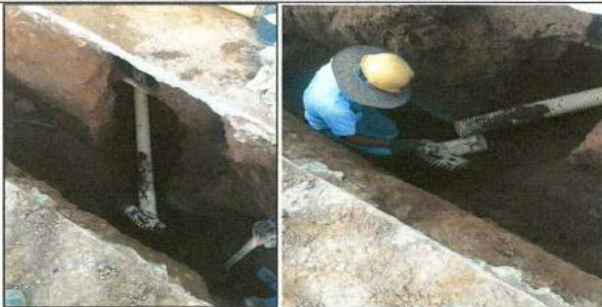
6.1. Suministro, Transporte e instalación de tubería PVC corrugada \Phi=160 mm (6") para alcantarillado
