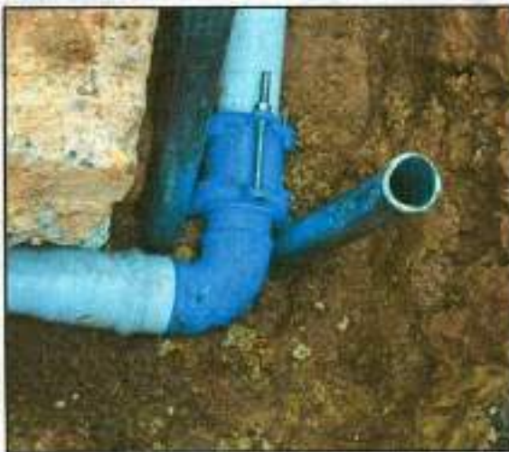
INP-03. Suministro, transporte e Instalacion tubería PVC RD21 de 2"
