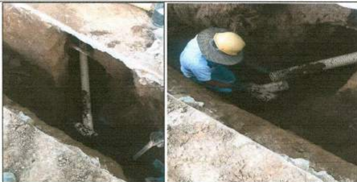
6.1. Suministro, Transporte e instalacion de tuberia PVC corrugada \Phi=160 mm (6") para alcantarillado
