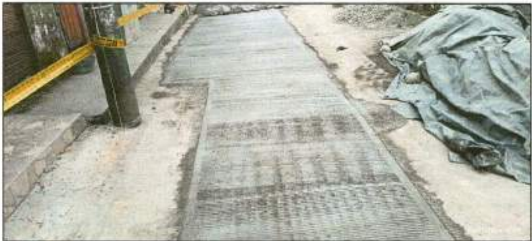
INP-05. Suministro, Transporte e instalacion de sardinel Ancho = 0.15 cm, en concreto 3000 PSI
