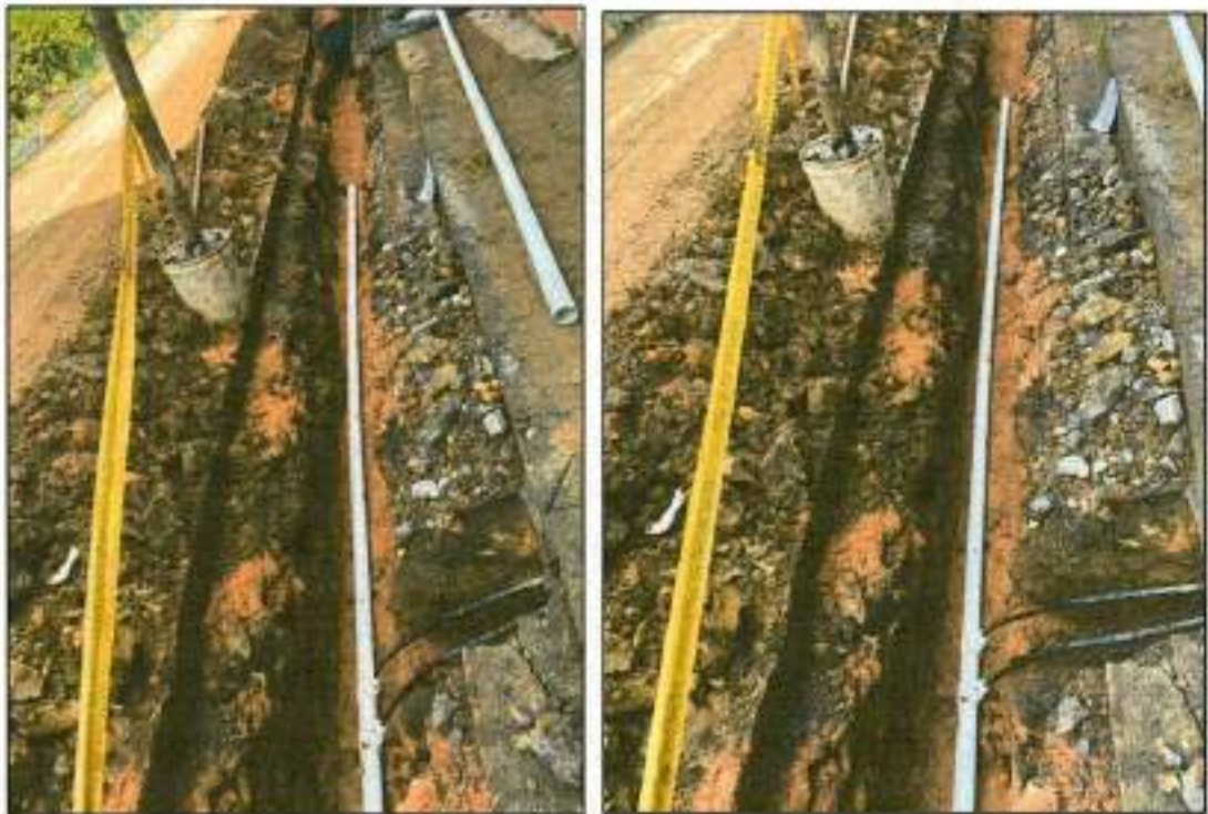
INP-03. Instalacion de hidrante (Tipo milan 3" extremo brida)
