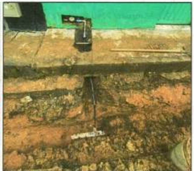
7.4. Suministro, transporte e Instalacion tubería pvc RD21 de 3"
