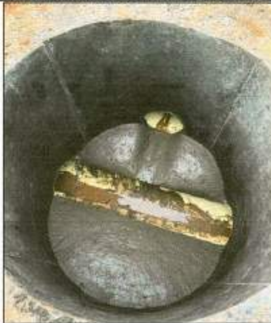
6.4. Base/ cañuela camara D=1.20 m en concreto 3000 psi
