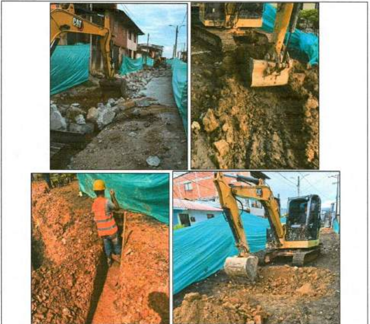
4.1. Rellenos compactos con material seleccionado de excavación
