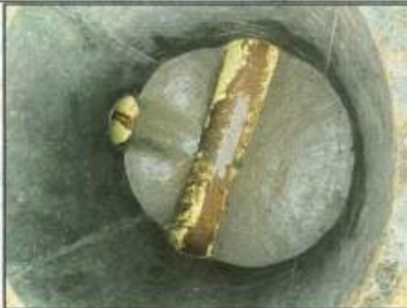
6.4. Base/ cañuela cámara D=1.20 m en concreto 3000 psi
