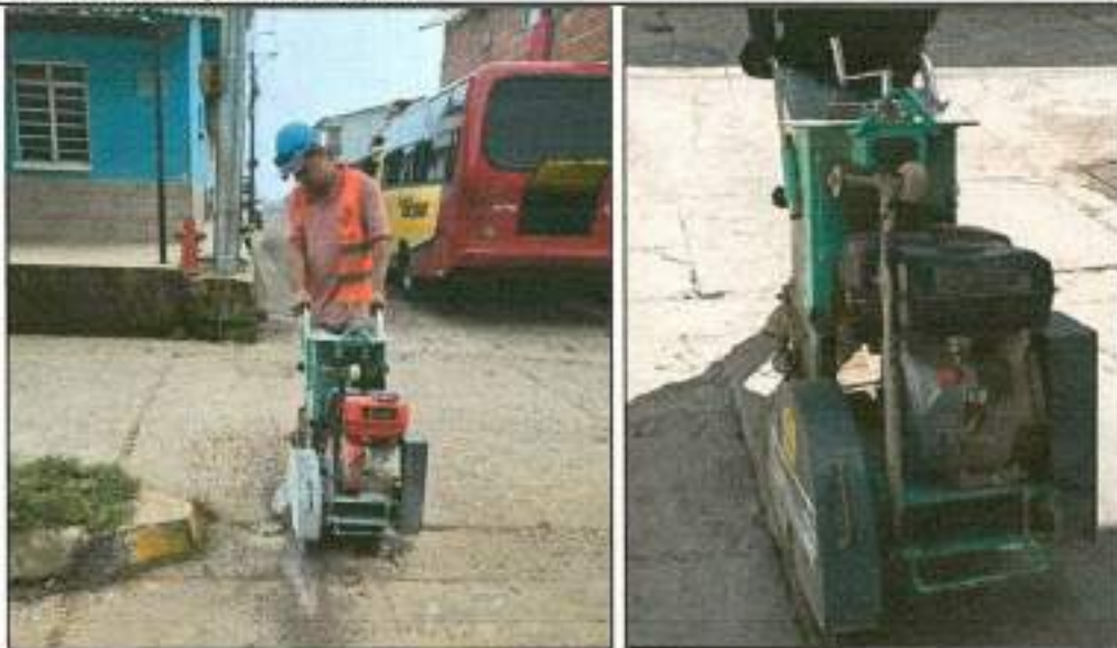
2.3. Corte mecanizado de pavimento 0,07m
