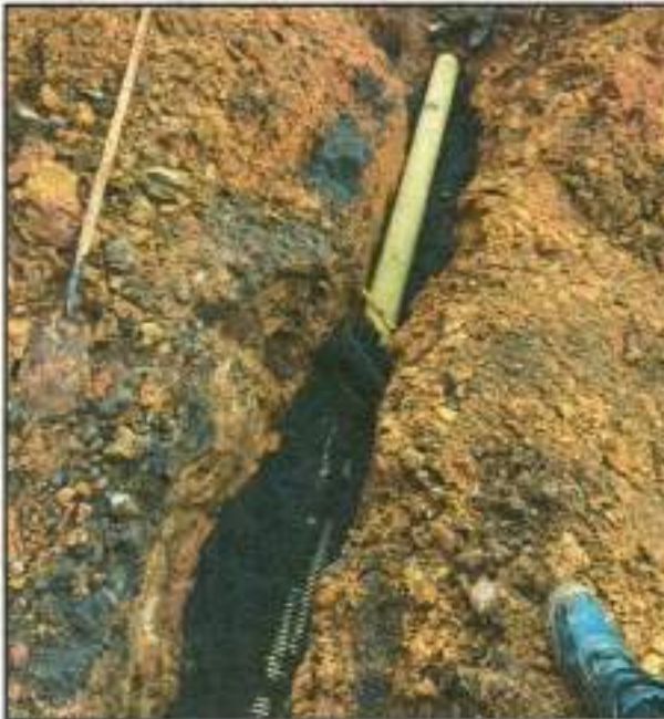
6.2. Suministro, Transporte e instalación de tubería PVC corrugada \Phi=12'' para alcantarillado, incluye manejo de aguas
