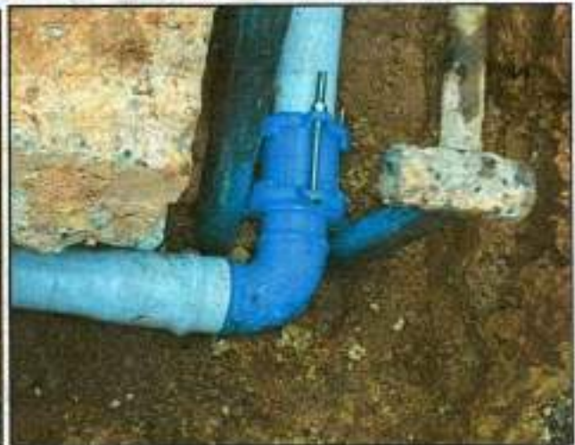
INP-03. Suministro, transporte e Instalacion tubería PVC RD21 de 2"
