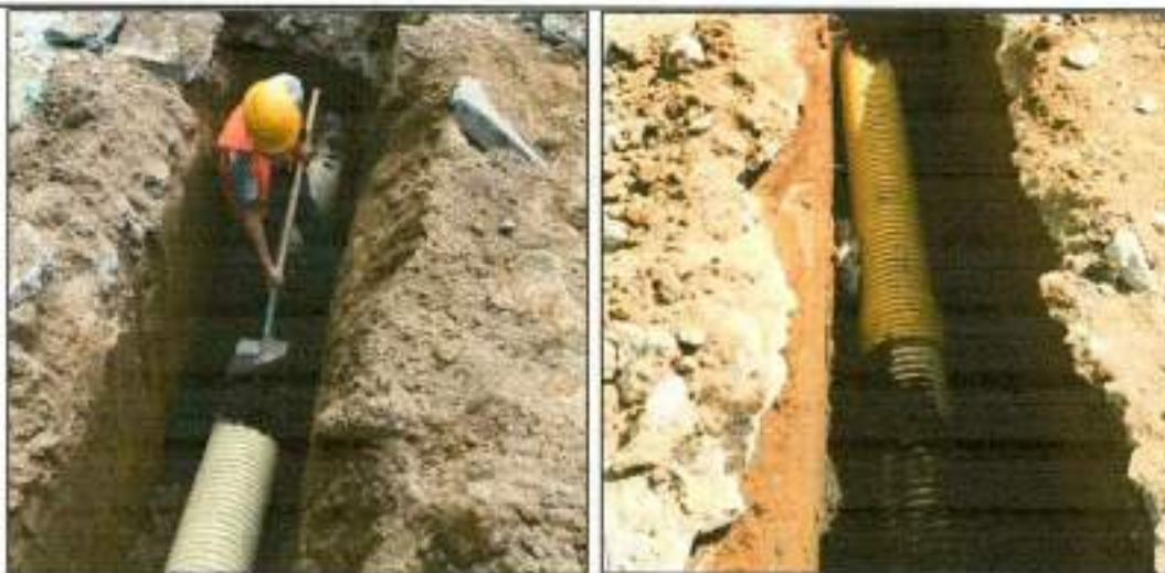
6.1. Suministro, Transporte e instalacion de tuberia PVC corrugada \Phi=160 mm (6") para alcantarillado
