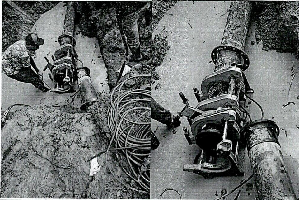
Fotos 2 y 3. Termofusión de la tubería de polietileno de 10", empalme de polietileno a polietileno con accesorios y tornillería
