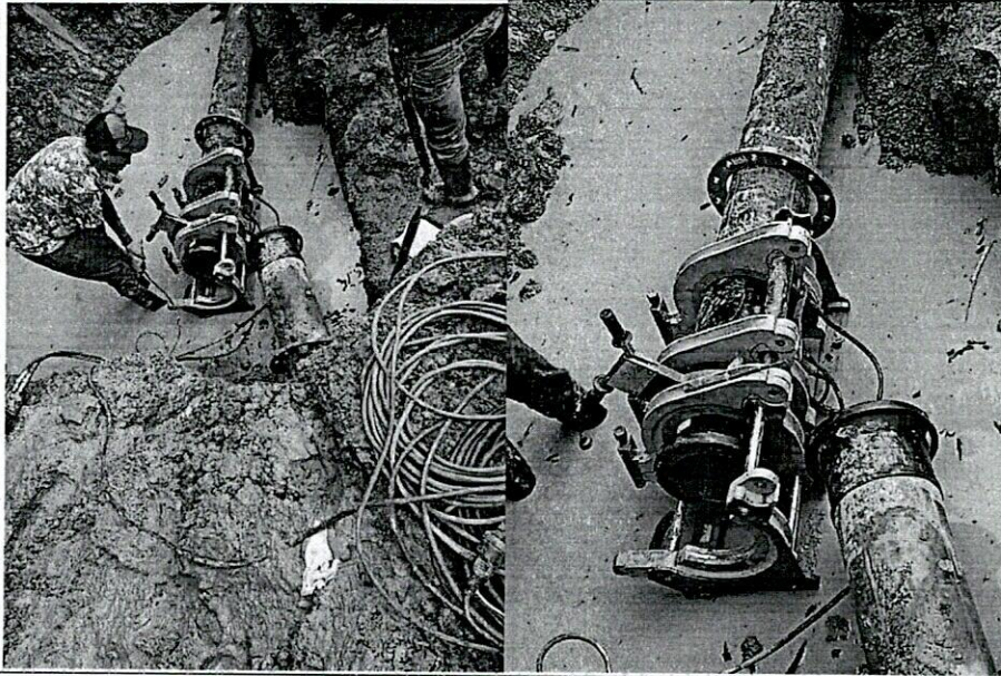
Fotos 2 y 3. Termofusión de la tubería de polietileno de 10'', empalme de polietileno a polietileno con accesorios y tornillería
