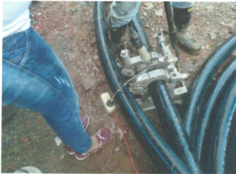
Termofusión de tubería de 3"
