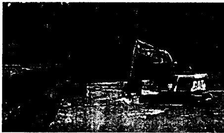
Ilustración 1. Transporte de Maquinaria Pesada, se realiza excavación y limpieza mecánica en El Llano – Rio Guarinó dando caudal a la misma
