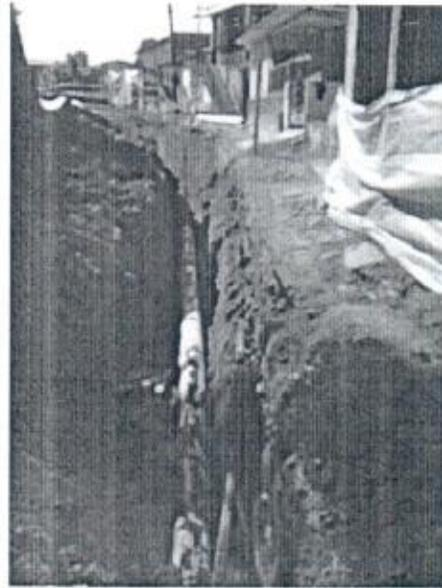
Llenos con arena par recubrimiento de tubería
