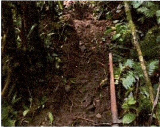
Foto No. 14: Excavación en conglomerado de 0-2 m.
