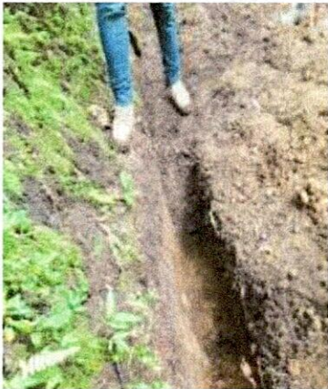
Foto No. 3: Lleno con material de sitio
