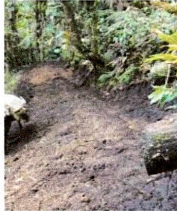
Foto No. 15: Lleno con material de sitio.
