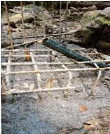
Foto No. 16: Concreto 4000 PSI y acero de refuerzo
