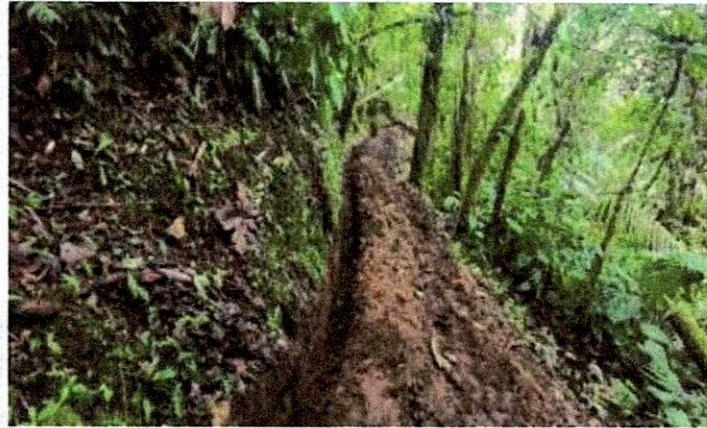
Foto No. 2: Excavación en material común.
