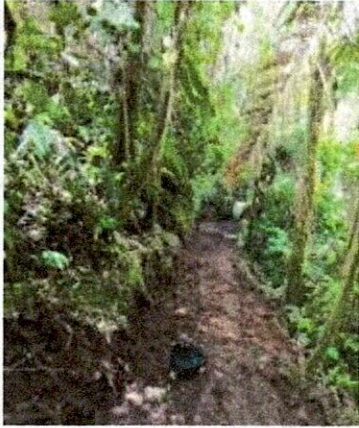
Foto No. 1: Descapote y limpieza
