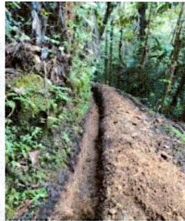
Fotos No. 12 y 13: Excavaciones en material común 0-2 m.
