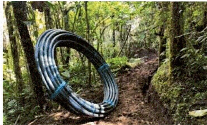
Foto No. 4: Instalación tubería
