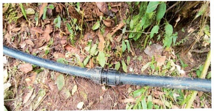
Foto No. 5: Suministro Instalación unión mecánica polietileno 90 mm
