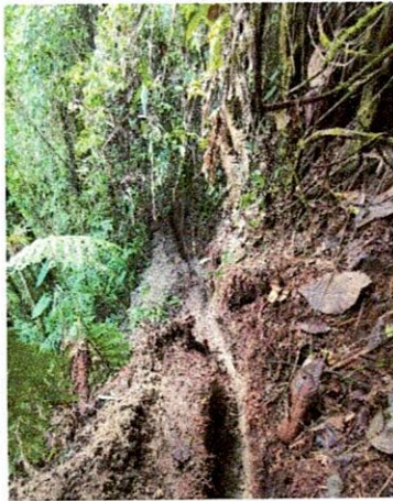
Foto No. 35: Excavación material común
