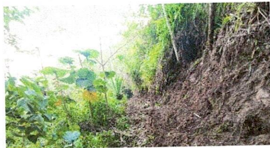
Foto No. 15: Lleno con material de sitio
