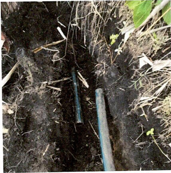
Foto No. 4: Suministro e Instalación tubería polietileno 90 mm
