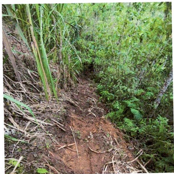
Foto No. 23: Lleno con material de sitio
