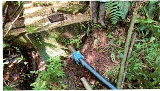
Foto No. 8: Suministro e instalación acople HD garra tigre pead x acero
