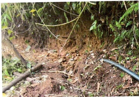
Foto No. 11: Lleno con material del sitio
