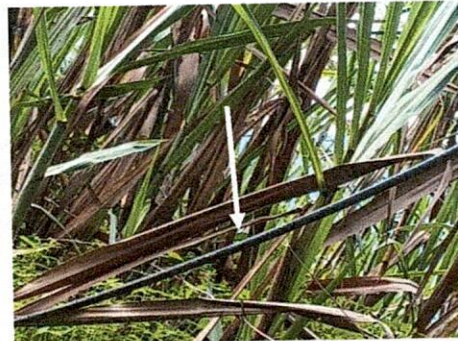
Foto No. 14: Instalación tubería polietileno ½"
