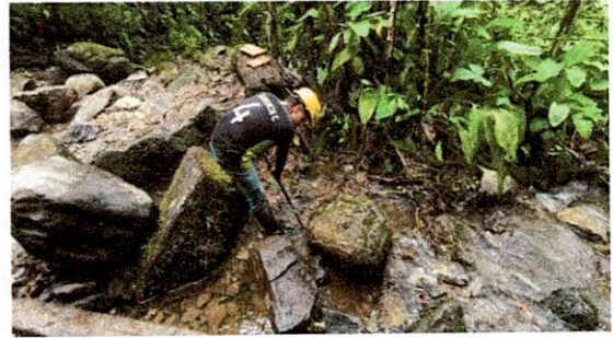
Foto No. 3: Excavación en roca.
