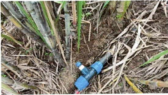
Foto No. 7: Suministro e instalación TEE PEAD PE - 100 90 mm a 63 mm
