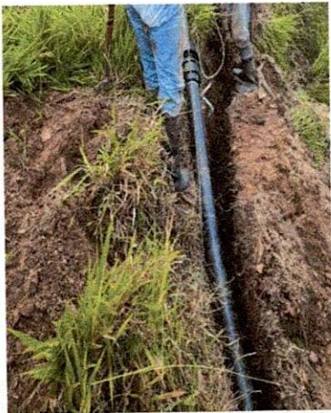
Foto No. 31: Instalación tubería 4"
