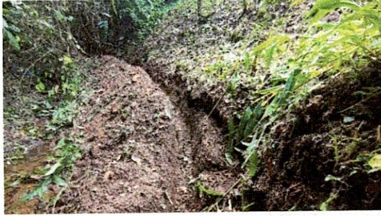
Foto No. 2: Excavación en material común.
