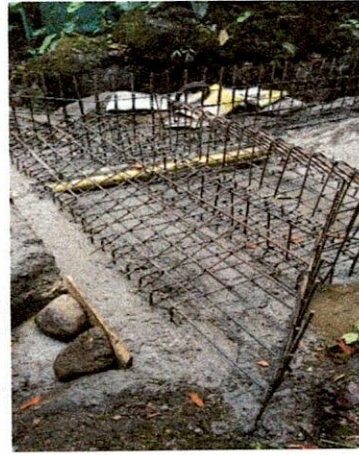
Foto No. 37: Acero de refuerzo
