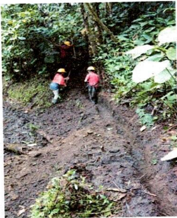
Foto No. 25: Excavación material común
