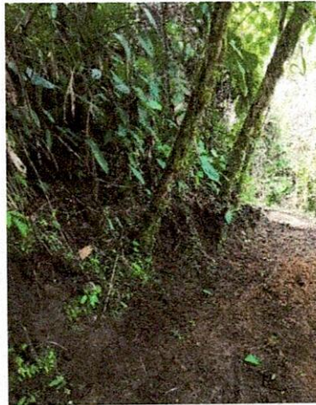
Foto No. 36: Lleno con material del sitio
