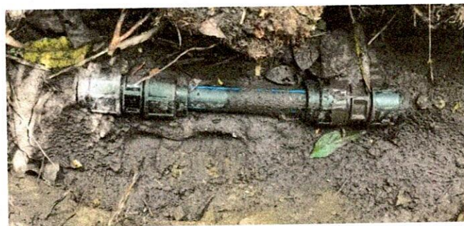
Foto No. 41: Suministro e instalación de unión PEAD PE - 100 63 mm PN 16
