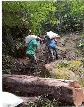
Foto No. 43: Trasiego de material a punto de instalación con personal de obra
