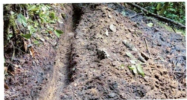
Foto No. 39: Excavación en Conglomerado
