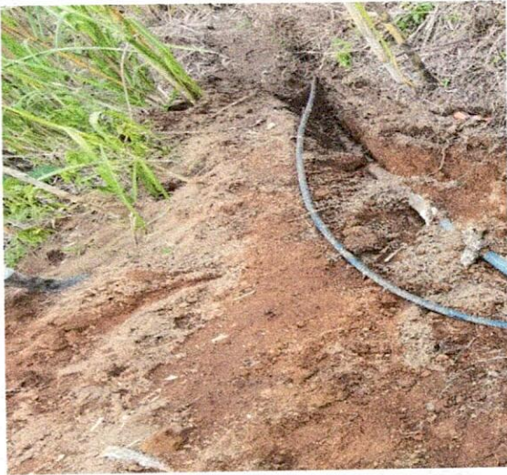
Foto No. 9: Suministro e instalación tubería polietileno 1"
