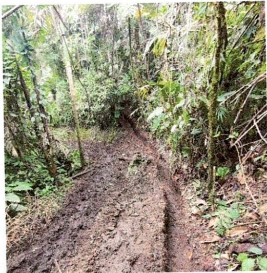
Foto No. 13: Excavación material común
