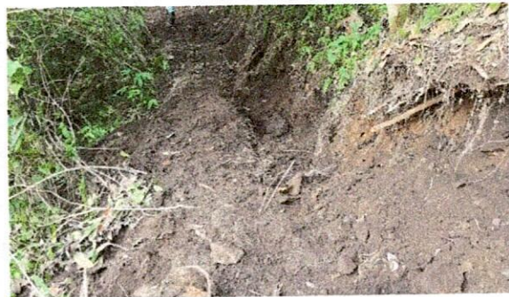
Foto No. 10: Excavación en conglomerado
