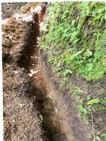
Foto No. 17: Excavación material común
