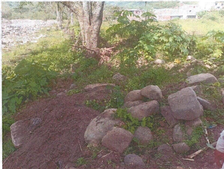
Excavación en roca
