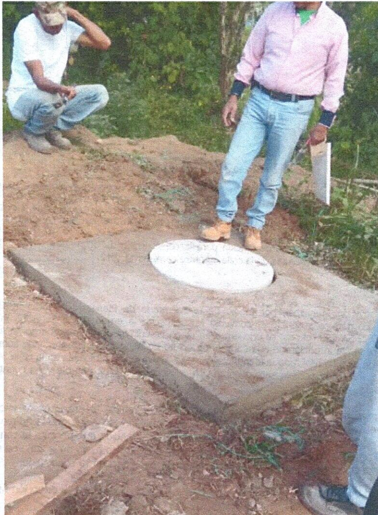
Terminado final de cámara
