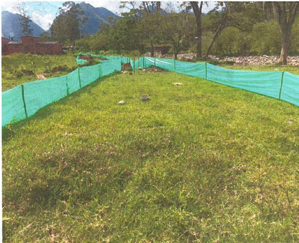
Cerramiento, señalización e inicio de la excavación
