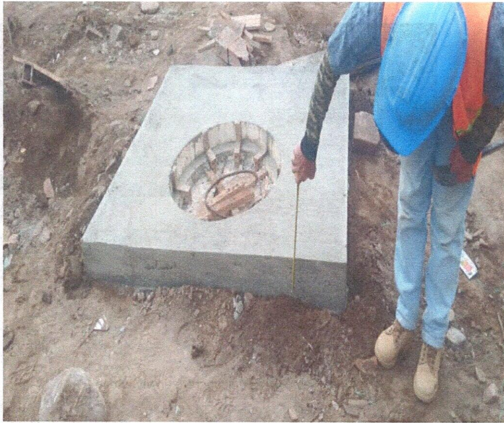
Losa superior cámara de inspección
