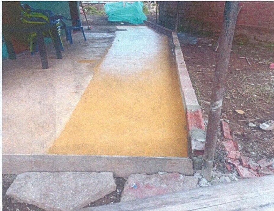
Reposición de concreto en vivienda
