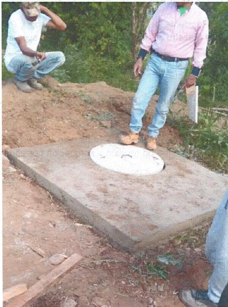
Terminado final de cámara
