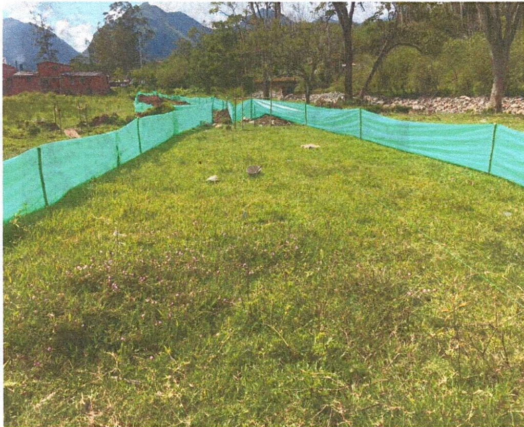
Cerramiento, señalización e inicio de la excavación
