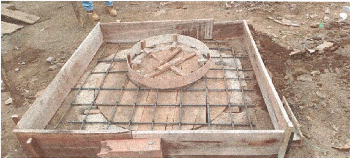
Acero de refuerzo para losa superior de cámara
