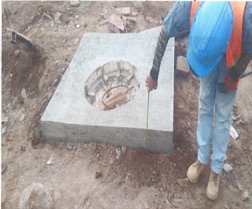
Losa superior cámara de inspección
