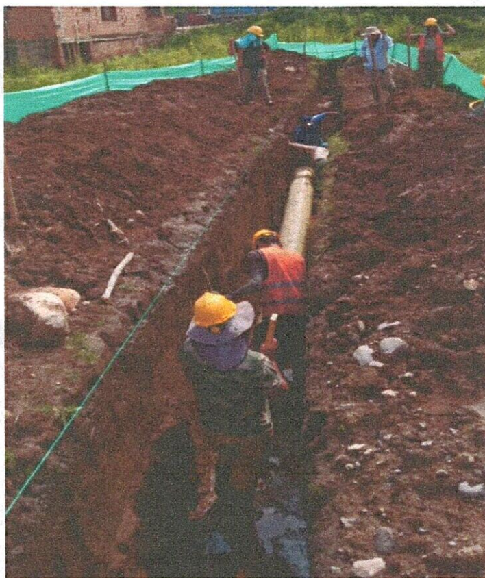
Instalación de tubería pvc 12" corrugada
