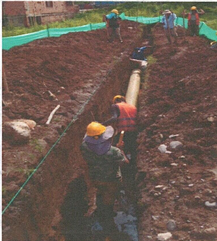
Instalación de tubería pvc 12" corrugada
