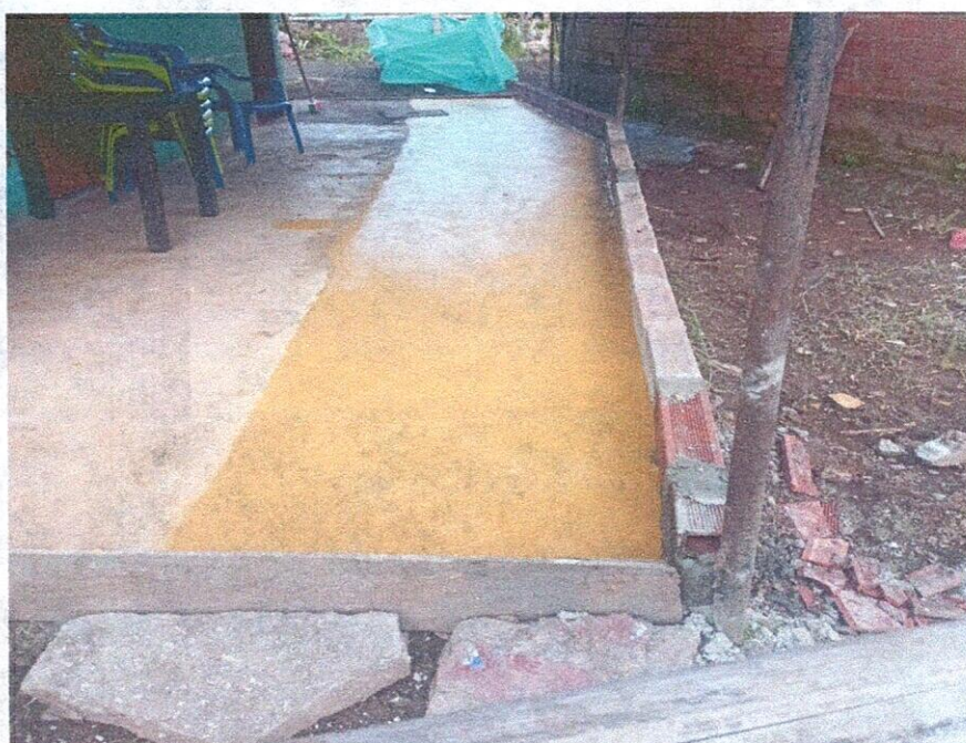
Reposición de concreto en vivienda
