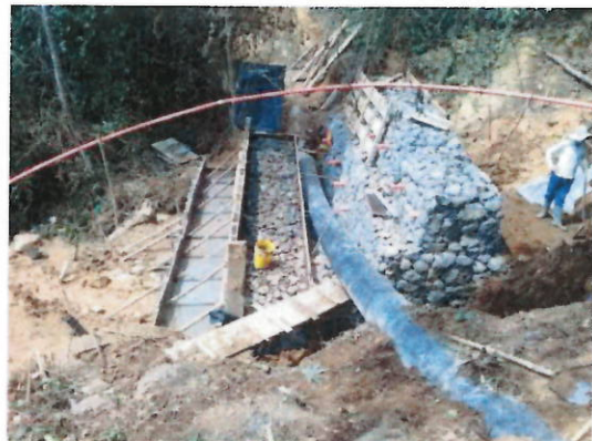
Suministro e instalación de gaviones en piedra con malla eslabonada
