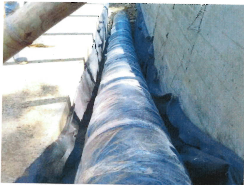
Suministro e instalación de geotextil Nt 1600
