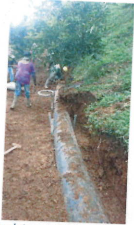
Anclaje con 4 tubos diámetro 2" acero l=3,0 m incluye amarre en alambre galvanizado
