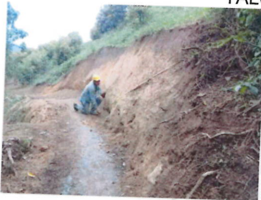
Excavaciones para perfilar el talud
