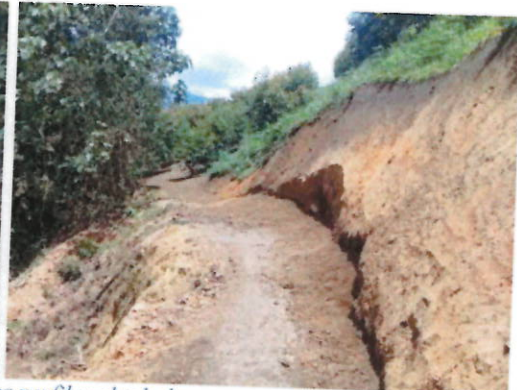
Excavaciones para perfilar el talud
