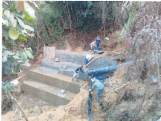
Concreto de 3000 psi para recubrimiento de gaviones, incluye el sobrecarreo de material al hombro
