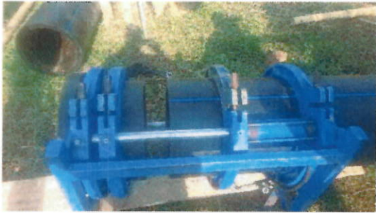
Instalación de tubería de diámetro 18" por termo fusión
