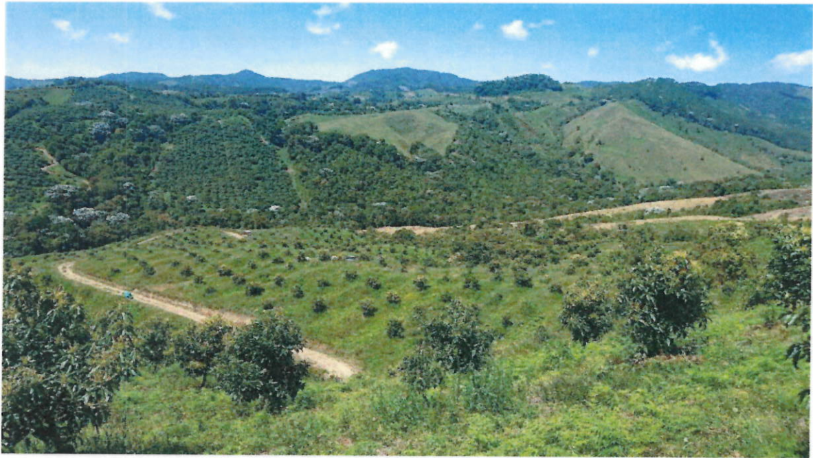
Panorámica del lugar de la obra
