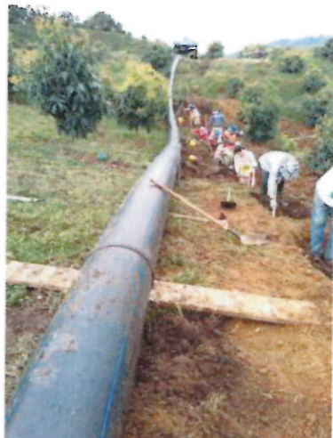
Instalación de la tubería
