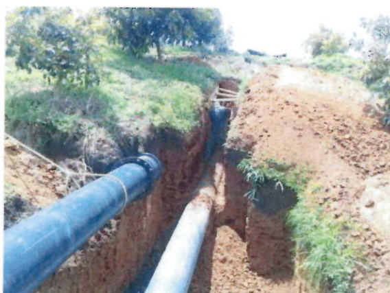
Instalación de la tubería
