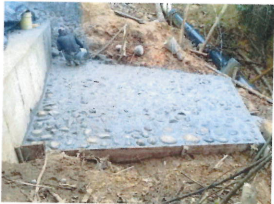
Enrocado con ligante en concreto 50% piedra, 50% concreto incluye acarreo al hombro del concreto
