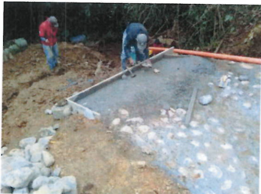
Enrocado con ligante en concreto 50% piedra, 50% concreto incluye acarreo al hombro del concreto
