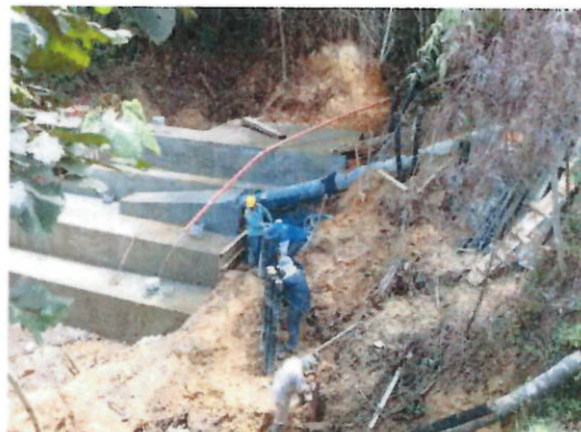
Concreto de 3000 psi para recubrimiento de gaviones, incluye el sobrecarreo de material al hombro
