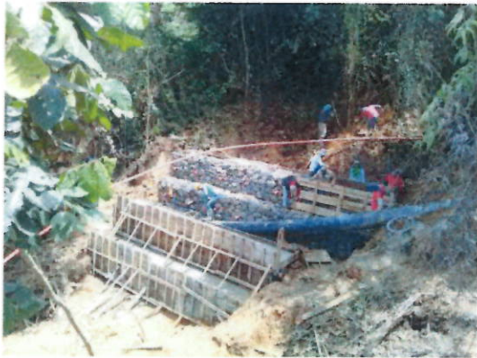
Suministro e instalación de gaviones en piedra con malla eslabonada
