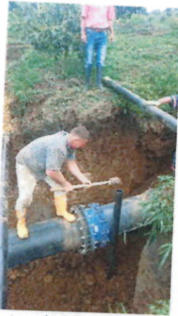
Anclaje con 4 tubos diámetro 2" acero l=3,0 m incluye amarre en alambre galvanizado
