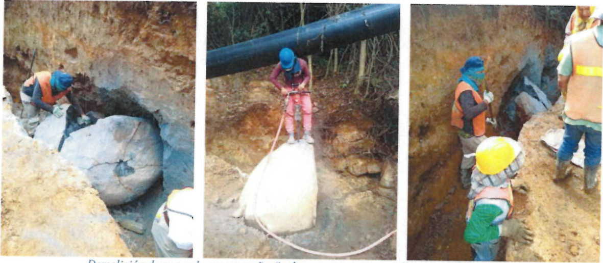
Demolición de rocas de gran tamaño (incluye compresor, martillo y darda hidráulica)
