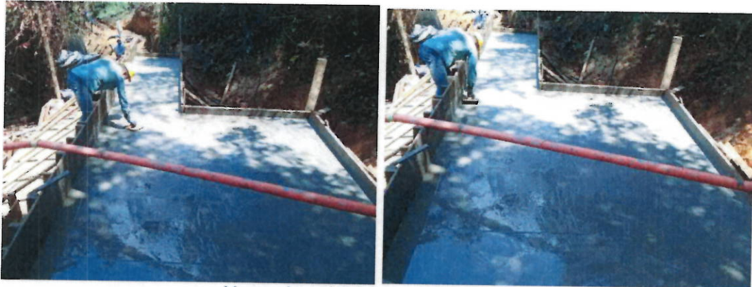
Mortero de nivelación para gaviones e=-0,05m
