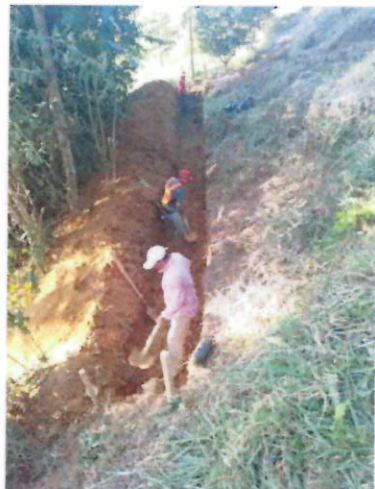
Excavaciones en material común
