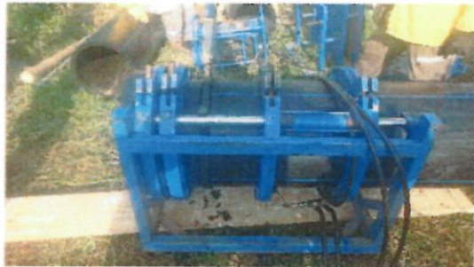
Instalación de tubería de diámetro 18" por termo fusión
