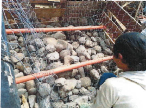
Suministro e instalación de tubería ALL 3" lloraderos en gavioneria
