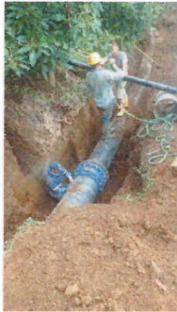
Empalme con tubería existente incluye tornillos y empaques
