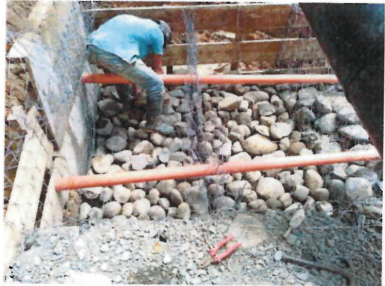
Suministro e instalación de tubería ALL 3" lloraderos en gavioneria
