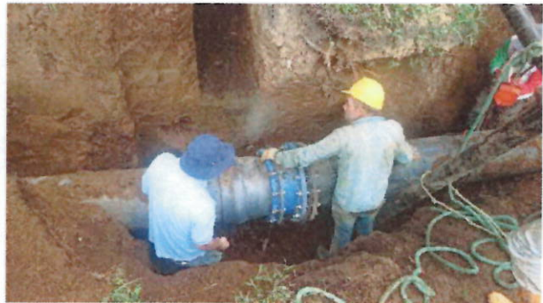
Empalme con tubería existente incluye tornillos y empaques
