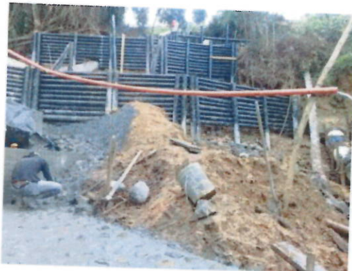
Anclaje con 4 tubos diámetro 2" acero l=3,0 m incluye amarre en alambre galvanizado
