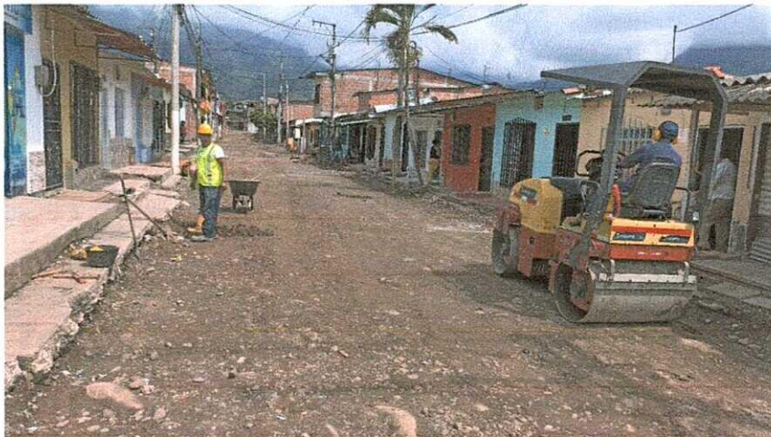
CONFORMACION SUB RASANTE CON MEDIO MECANICO
