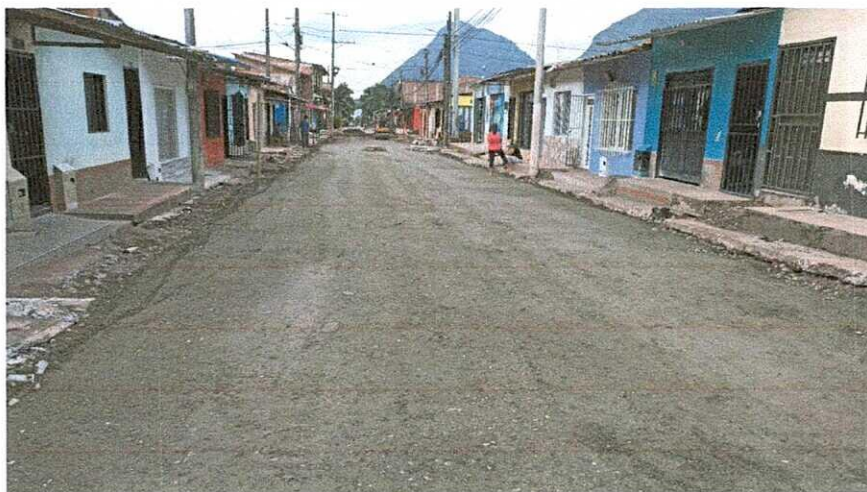
INSTALACION SUB BASE GRANLAR
