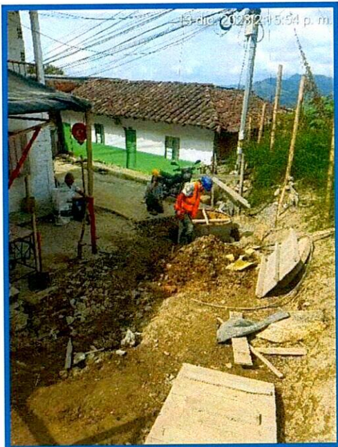
CONSTRUCCION DE CAMARA DE INSPECCION 14
