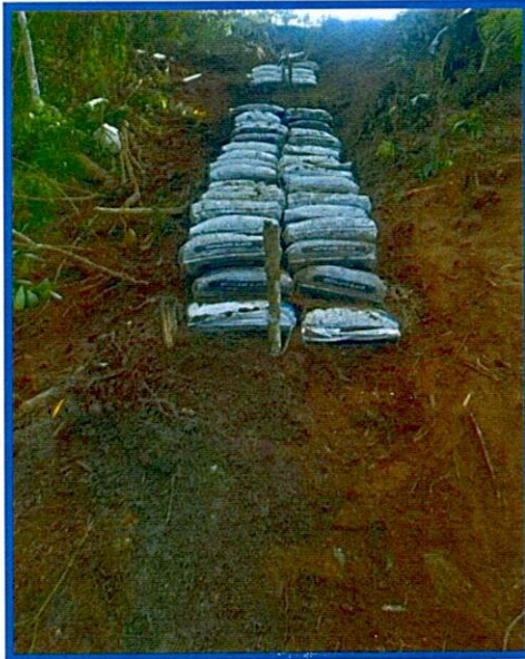
CONSTRUCCION DE TRINCHOS EN COSTALES
