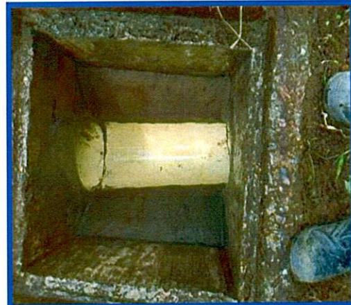
CONSTRUCCION DE BASE Y CAÑUELA EN CAJA DE INSPECCION EXISTENTE
