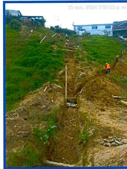
EXCAVACIONES EN ZANJA PARA INSTALACION DE TUBERIA NOVAFORT PVC DE 12" Y EXCAVACIONES PARA DOMICILIARIAS
