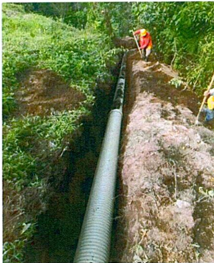
INSTALACION DE ENTIBADOS TIPO 1 PARA EXCAVACIONES EN ZANJA
