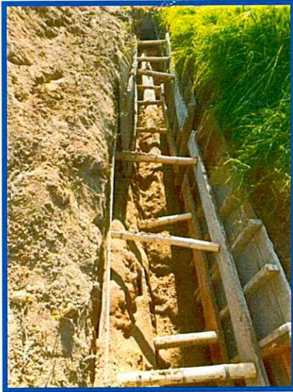
EXCAVACIONES EN ZANJA PARA INSTALACION DE TUBERIA NOVAFORT PVC DE 12" Y EXCAVACIONES PARA DOMICILIARIAS
