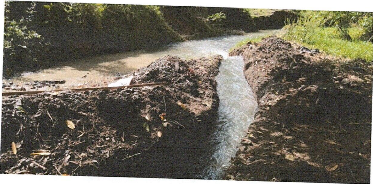
INSTALACION DE TUBERIA PASO SUBFLUVIAL
